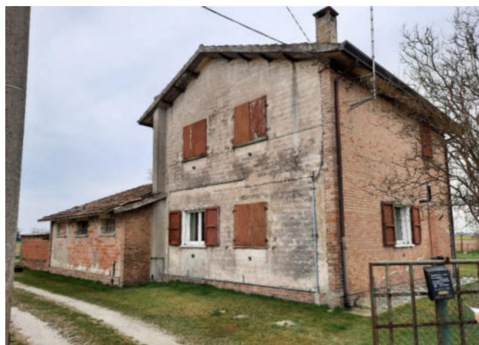
Figura 16. Foto Fonte: Regione Emilia-Romagna – Sopralluogo 2022
