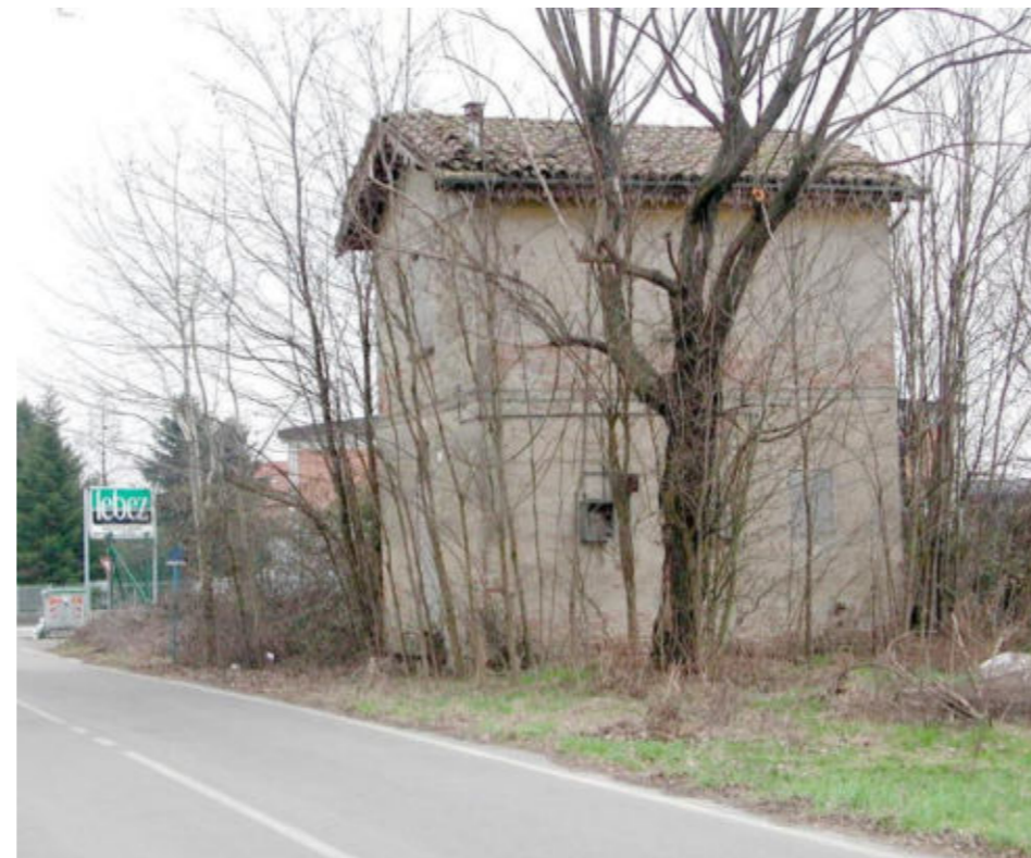
3 - Inquadramento casa cantoniera ex tratt ferroviaria Bagnolo – Carpi
