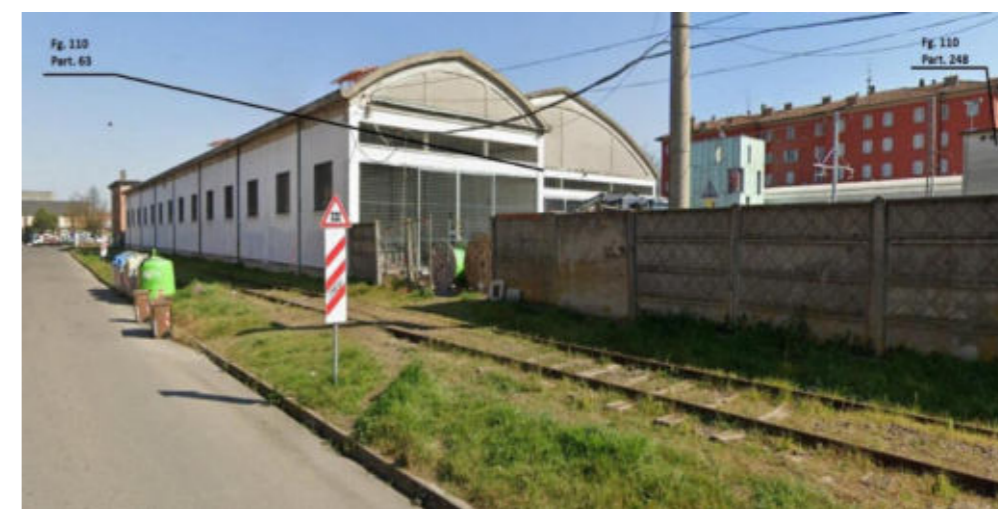
4 - Inquadramento capannone autorimessa e torre impianti, foglio 110, part. 63 - 248
