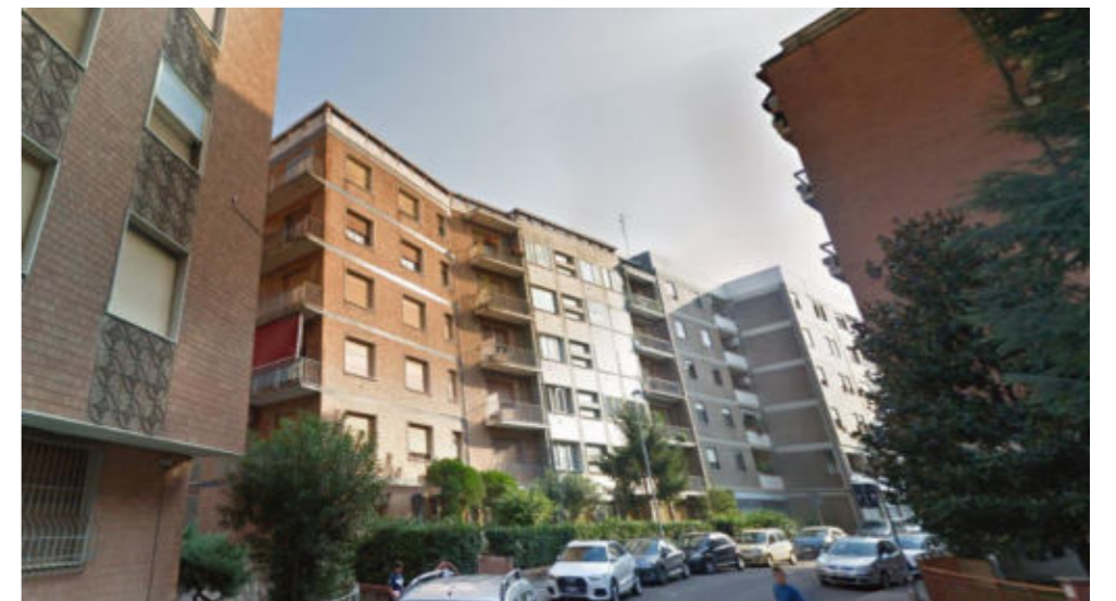
Figura 33-Vista del complesso immobiliare
