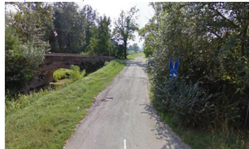
3 –area verde adiacente TRESINARO (ZONA 1) ex tratta ferroviaria
