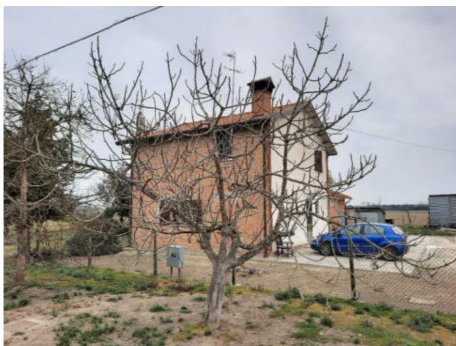
Figura 14 Foto Fonte: Regione Emilia-Romagna – Sopralluogo 2022
