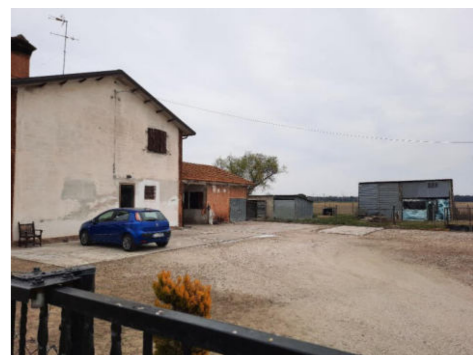
Figura 15 Foto Fonte: Regione Emilia-Romagna – Sopralluogo 2022
