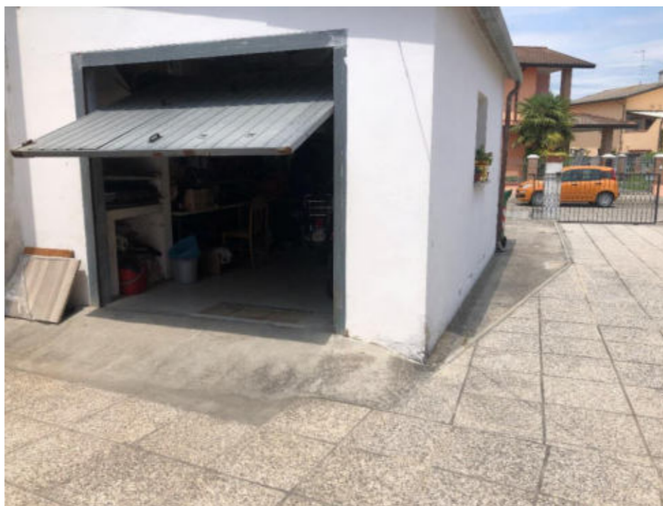
Figura 18. Foto fonte: Regione Emilia-Romagna – sopralluogo 2022
