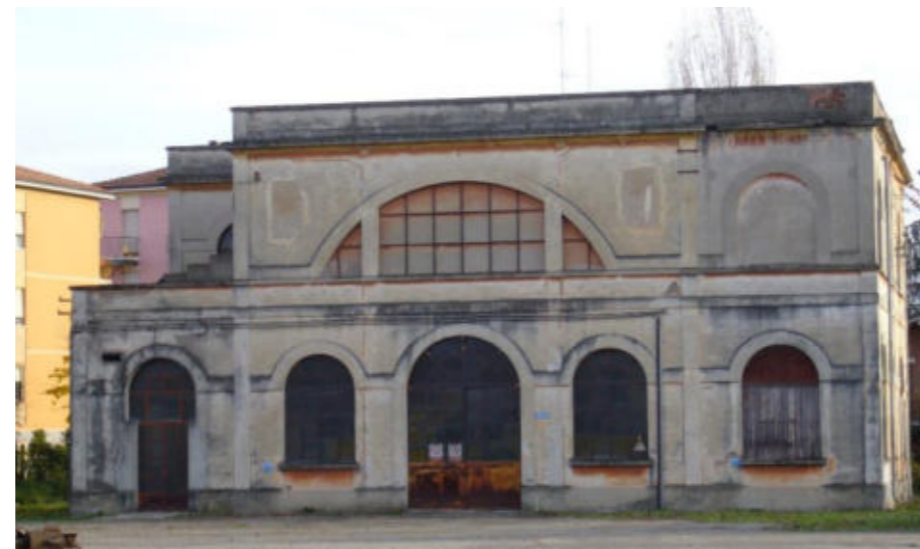
Figura 20 – Sottostazione elettrica (SSE), foglio 175, part. 205
