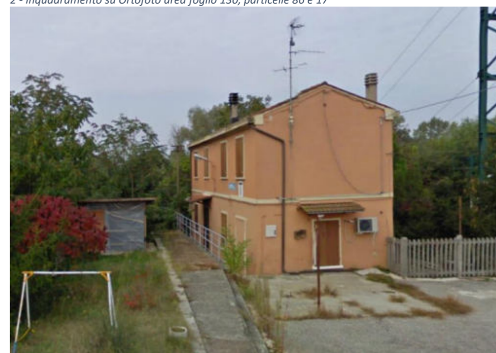
Figura 36 - Foto vista Casa cantoniera interno alla particella 17 del foglio 130
