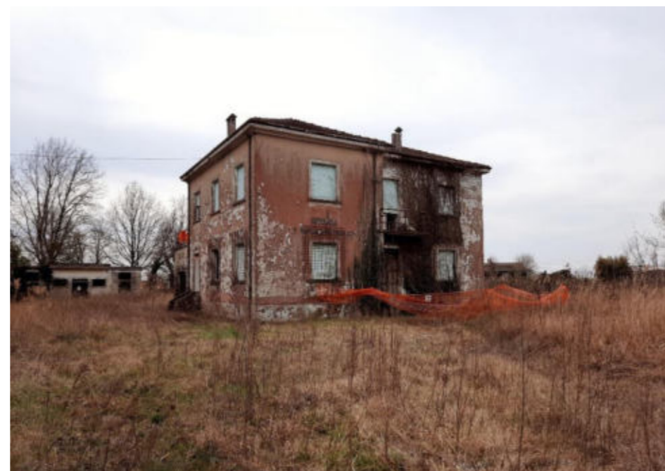
Figura 17. Foto Fonte: Regione Emilia-Romagna - sopralluogo 2022
