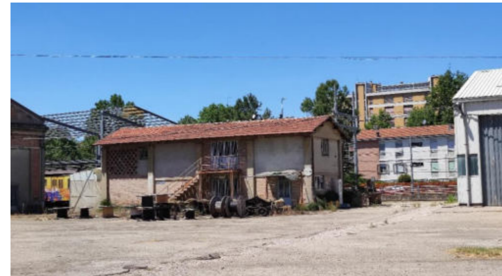
13 – Fabbricato uso magazzino, foglio 175, part. 198
