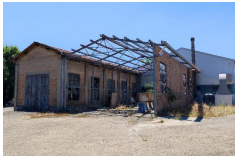
14 – Fabbricato ex lavaggio, foglio 175, part. 197
