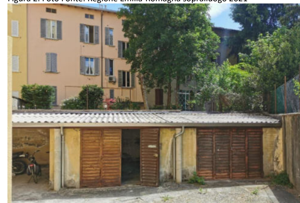
Figura 4. Foto Fonte: Regione Emilia-Romagna sopralluogo 2021 - Sub61
