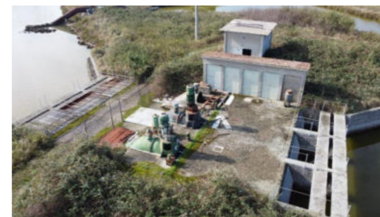
Figura 5. Ex SIVALCO Fonte: Regione Emilia – Romagna sopralluogo 2023
