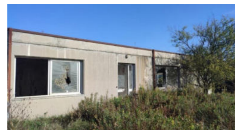
Figura 6. Ex SIVALCO Fonte: Regione Emilia – Romagna sopralluogo 2023
