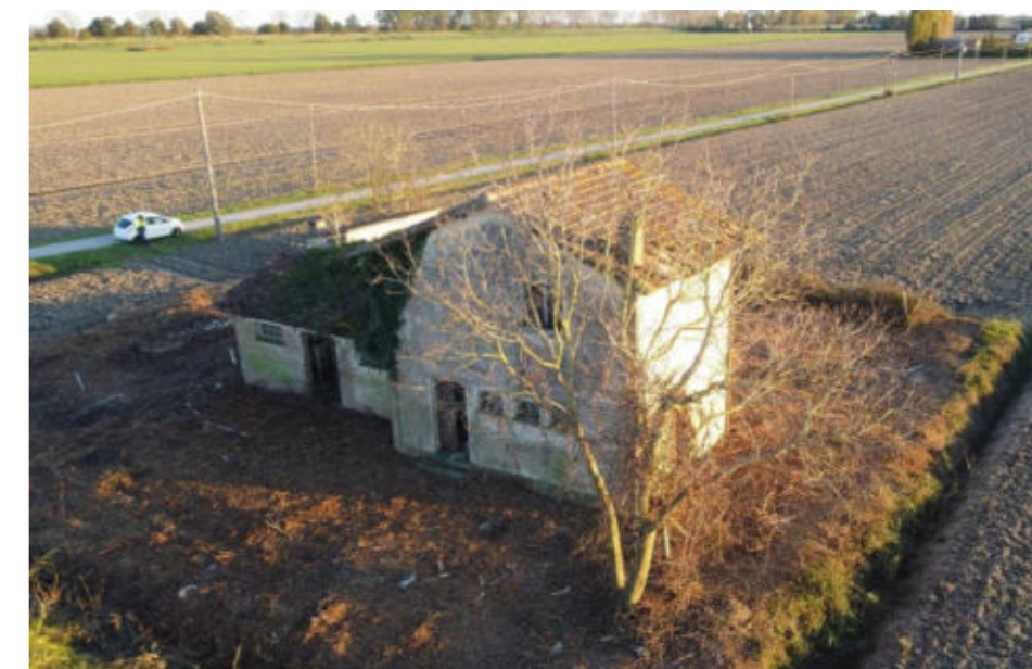
Figura 20. Foto Fonte: Regione Emilia-Romagna – Sopralluogo 2023
