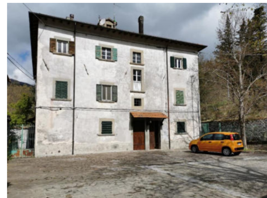
Figura 14. Foto Fonte: Regione Emilia-Romagna sopralluogo 2021
