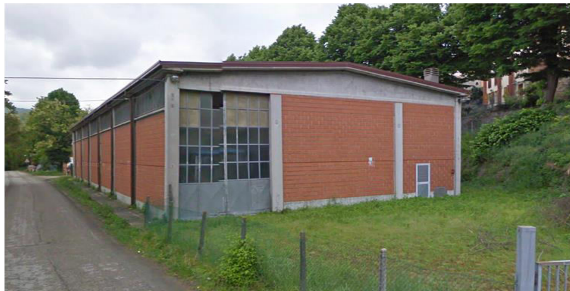
4 – Deposito/officina Autobus (ex magazzino ferroviario, foglio 13, particella 549, sub. 4
