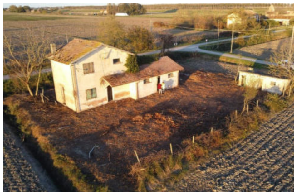
Figura 19. Foto Fonte: Regione Emilia-Romagna – Sopralluogo 2023
