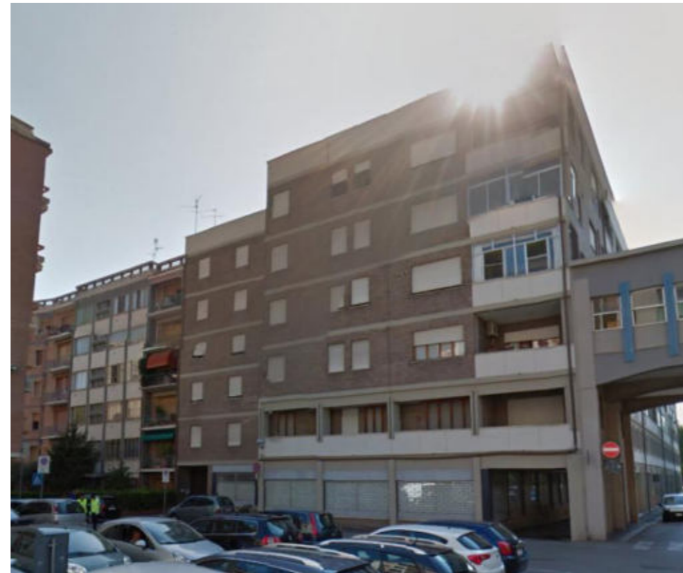
Figura 31-Vista frontale del complesso immobiliare
