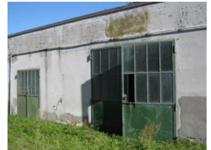
Figura 43. Fabbricato B - cantina e ricovero attrezzi. Piccolo edificio costruito in muratura di mattoni con copertura piana in laterocemento, della superficie lorda complessiva di circa 75,00 mq, disposta sul solo piano terra e suddivisa in due locali.
