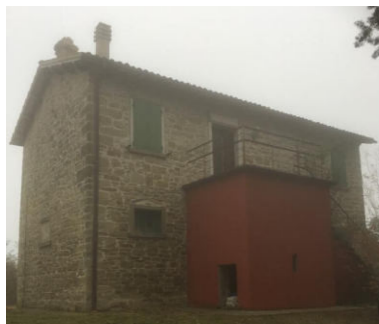
Figura 1. Foto il Fabbricato principale Fonte: Sopralluogo RER – 2018
