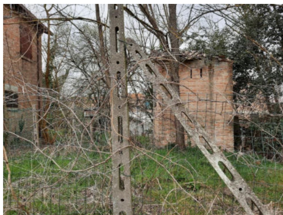
Figura 8. Foto Fonte: Regione Emilia-Romagna -sopralluogo 2022
