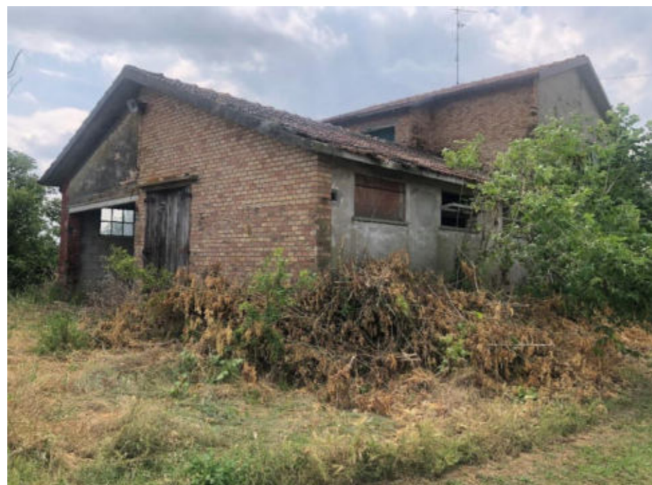
Figura 1. Foto Fonte: Regione Emilia-Romagna – sopralluogo 2022
