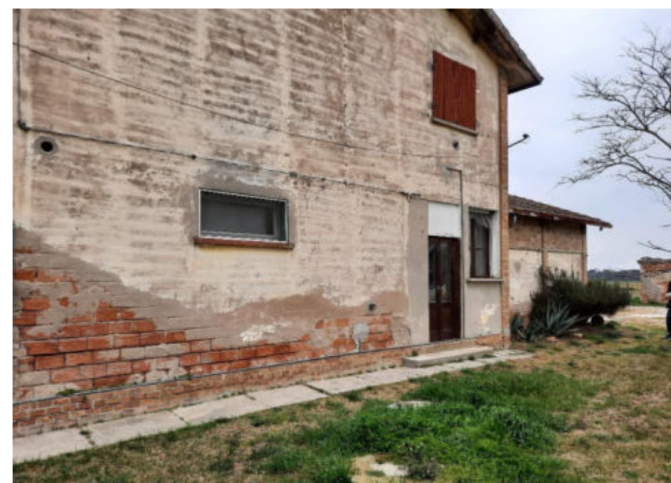
Figura 17. Foto Fonte: Regione Emilia-Romagna – Sopralluogo 2022
