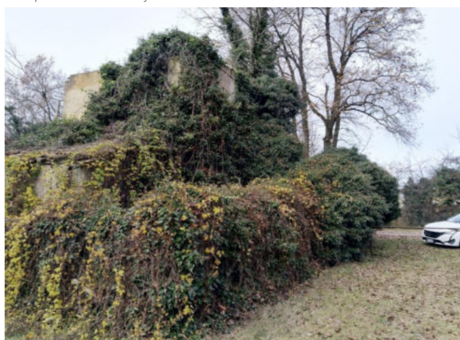
4 - Inquadramento casa cantoniera ex tratta ferroviaria Bagnolo – altra visuale
