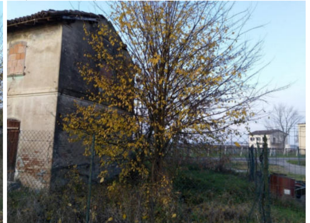
4 - Inquadramento casa cantoniera ex tratta ferroviaria Bagnolo – Carpi altra visuale
