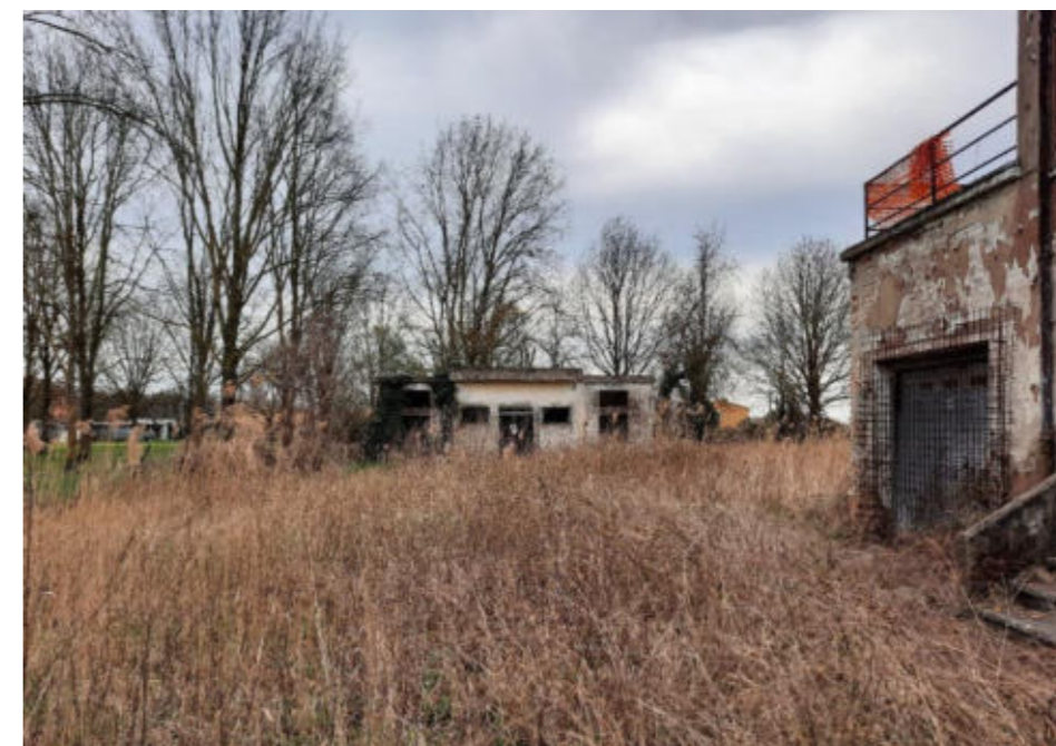
Figura 18. Foto Fonte: Regione Emilia-Romagna - sopralluogo 2022
