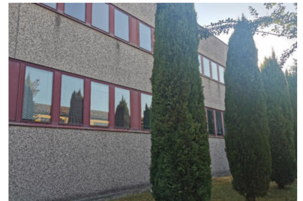
Figura 10. Foto Fonte: Regione Emilia-Romagna sopralluogo 2022
