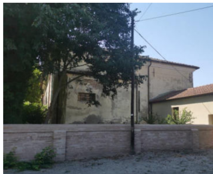
Figura 35. Foto Fonte: Regione Emilia-Romagna sopralluogo 2022
