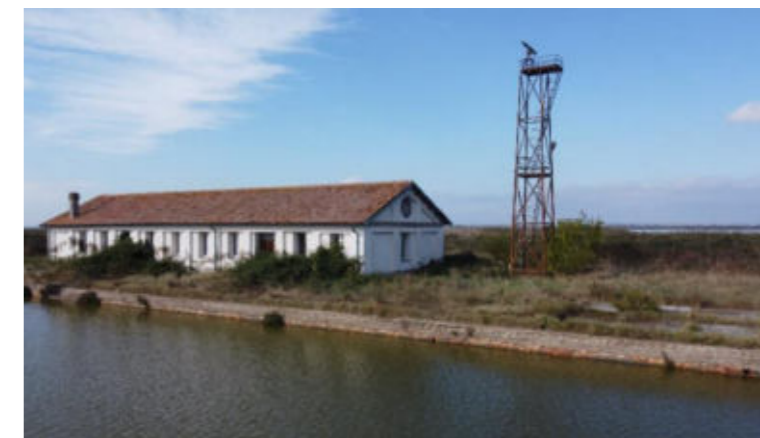
Figura 3. Ex SIVALCO Fonte: Regione Emilia – Romagna sopralluogo 2023
