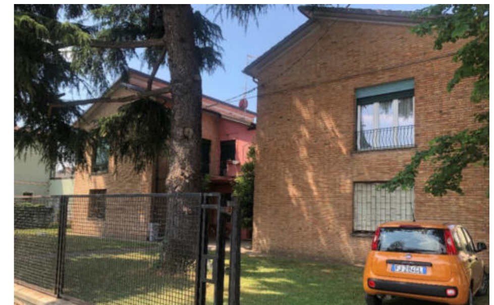
Figura 16. Foto Fonte: Regione Emilia-Romagna - sopralluogo 2022
