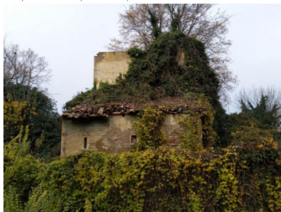
3 - Inquadramento casa cantoniera ex tratta ferroviaria Bagnolo – Carpi
