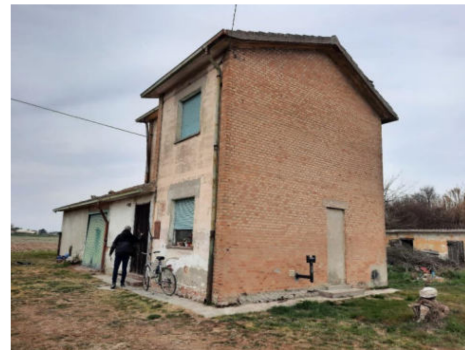
Figura 13. Foto Fonte: Regione Emilia-Romagna – sopralluogo 2022
