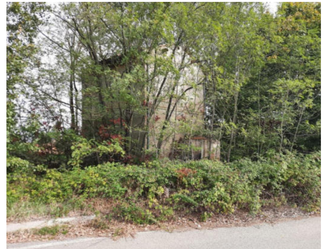
4 - Inquadramento casa cantoniera ex tratta ferroviaria Bagnolo – Carpi altra visuale
