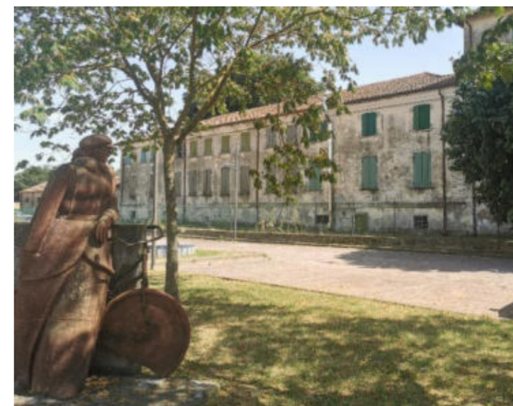
Figura 36. Foto Fonte: Regione Emilia-Romagna sopralluogo 2022
