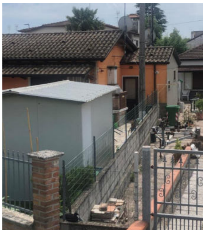
Figura 22. Foto fonte: Regione Emilia-Romagna – sopralluogo 2022
