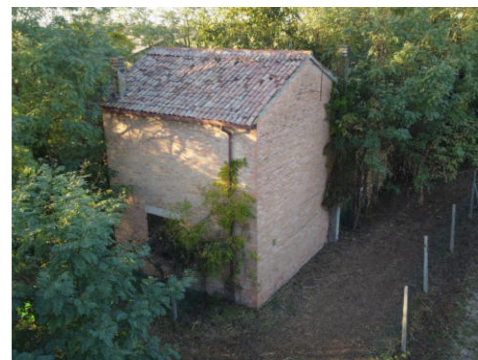
Figura 9. Foto Fonte: Regione Emilia-Romagna – sopralluogo 2023
