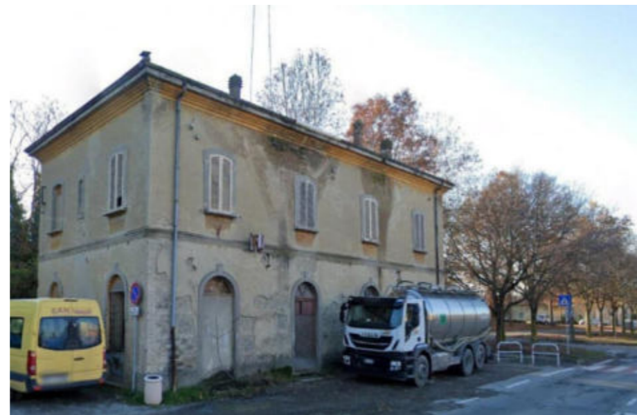
5 - Altra visuale ex fabbricato viaggiatori, foglio 19, particella 410
