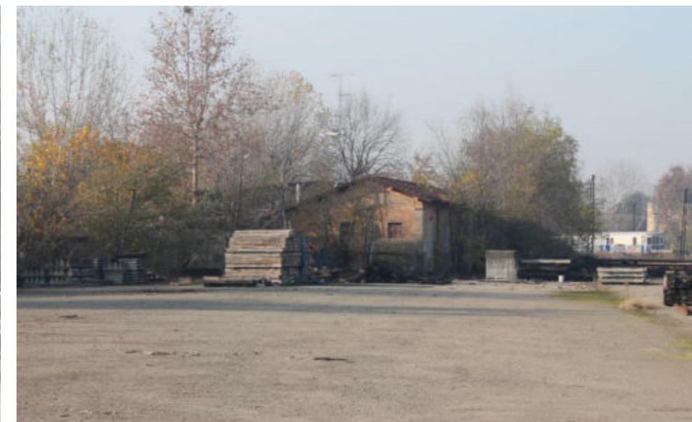
8 – Fabbricato ex circolo ferroviario, foglio 175, part. 204
