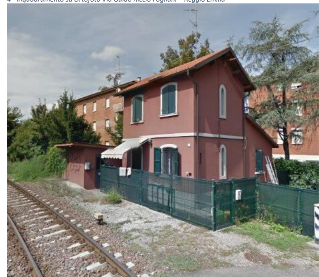
7 - Inquadramento Casa Cantoniera Via Guido Riccio Fogliano, foglio 110, part. 61
