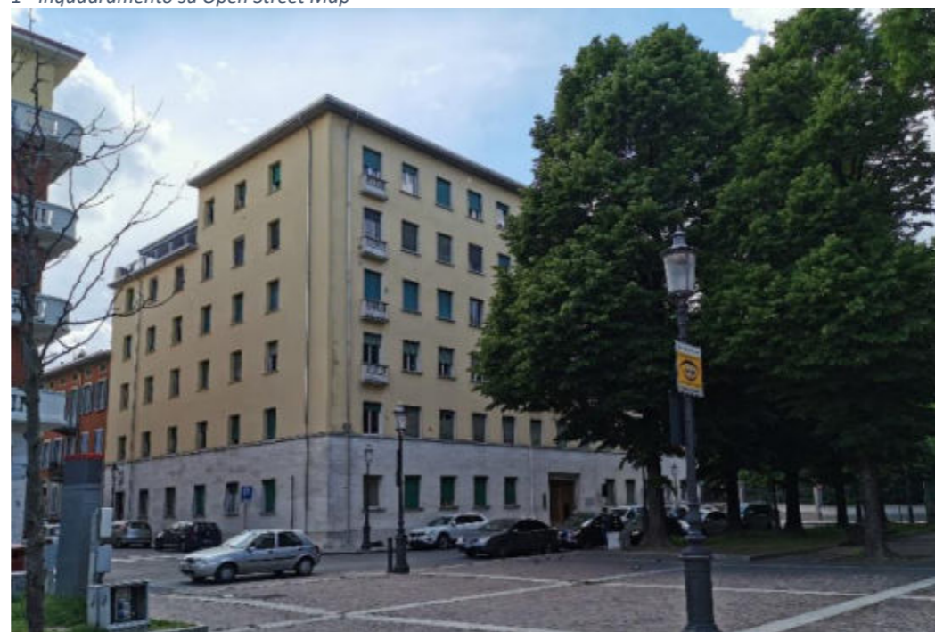
Figura 1. Foto Fonte: Regione Emilia-Romagna sopralluogo 2021
