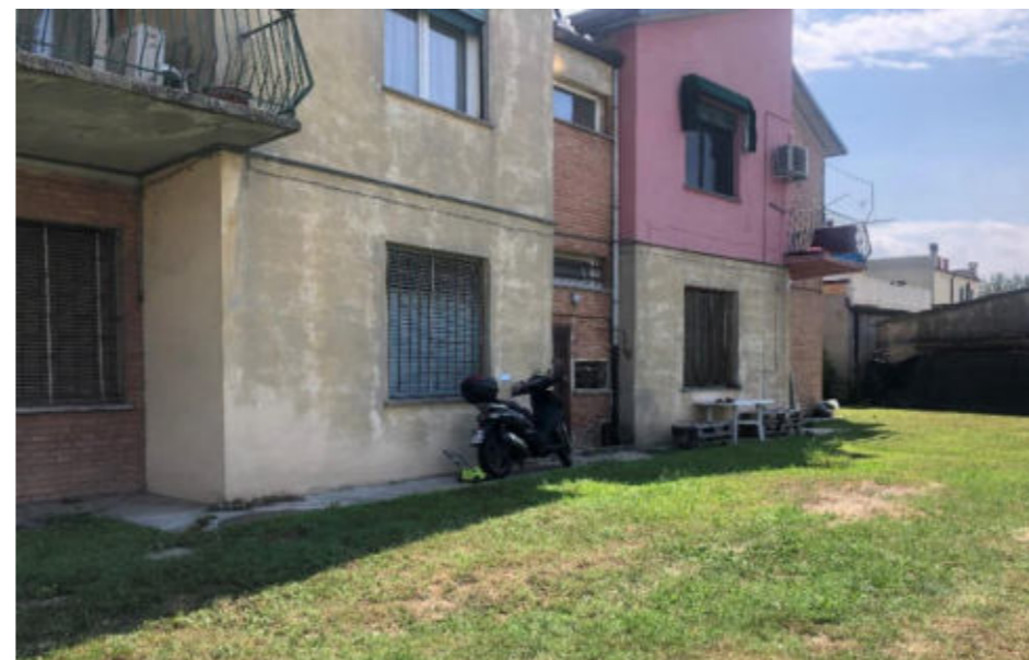
Figura 15. Foto Fonte: Regione Emilia-Romagna - sopralluogo 2022
