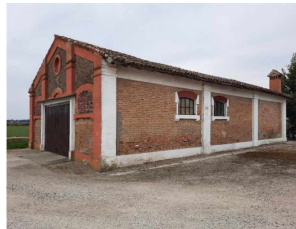
Figura 11. Foto Fonte: Regione Emilia-Romagna – sopralluogo 2022
