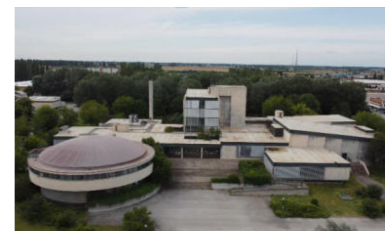
Figura 19. Foto Part. 11 (palazzina ex C.O). Fonte: Regione Emilia-Romagna sopralluogo 2023
