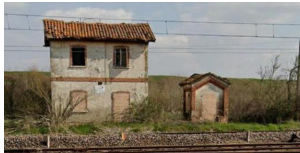
3 - Lato Suzzara vista Casa Cantoniera Foglio 127 - Mappale 40
