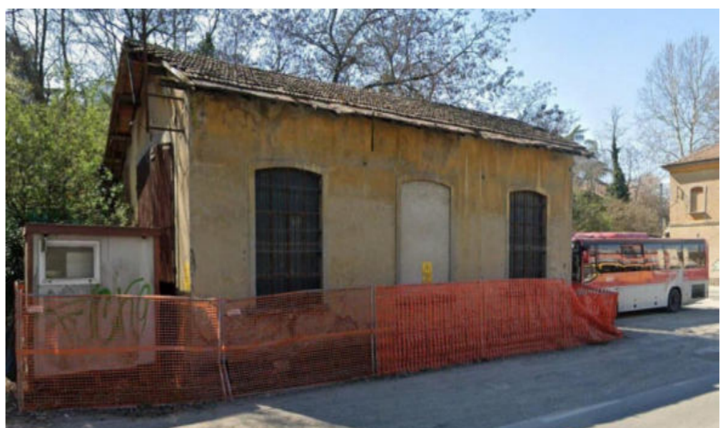
6 - Altra visuale ex deposito locomotori, foglio 19, particella 412
