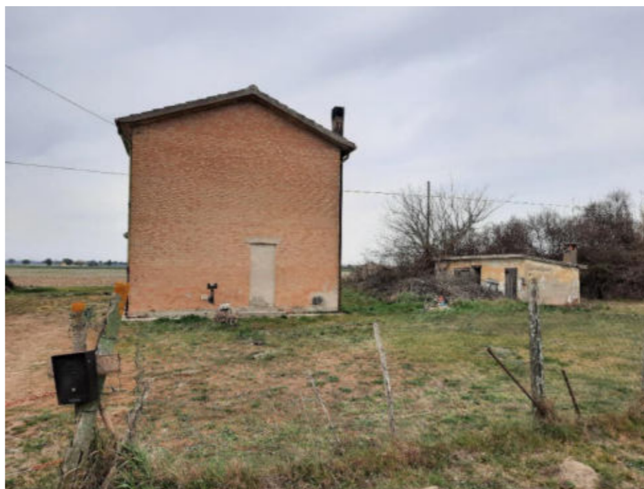
Figura 12. Foto Fonte: Regione Emilia-Romagna – sopralluogo 2022
