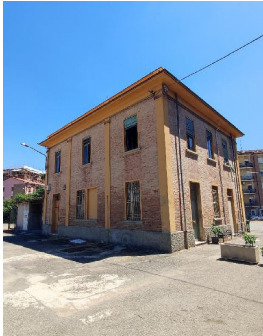
12 – Fabbricato spogliatoio, foglio 175, part. 199
