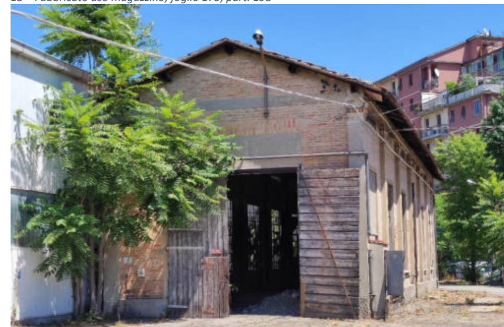
14 – Fabbricato ex lavaggio, foglio 175, part. 197 – Altra Vista
