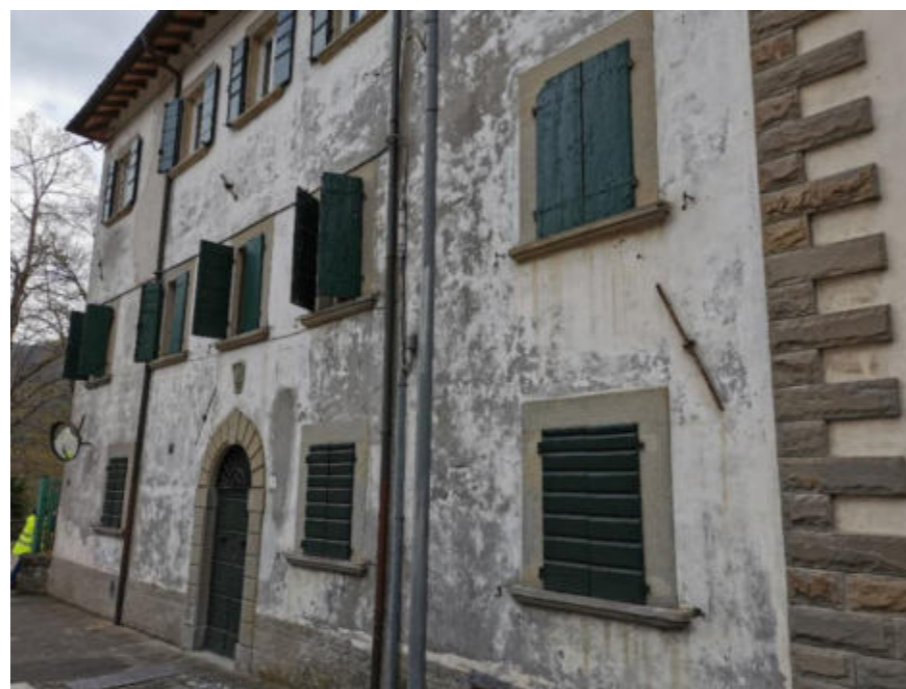
Figura 13. Foto Fonte: Regione Emilia-Romagna sopralluogo 2021
