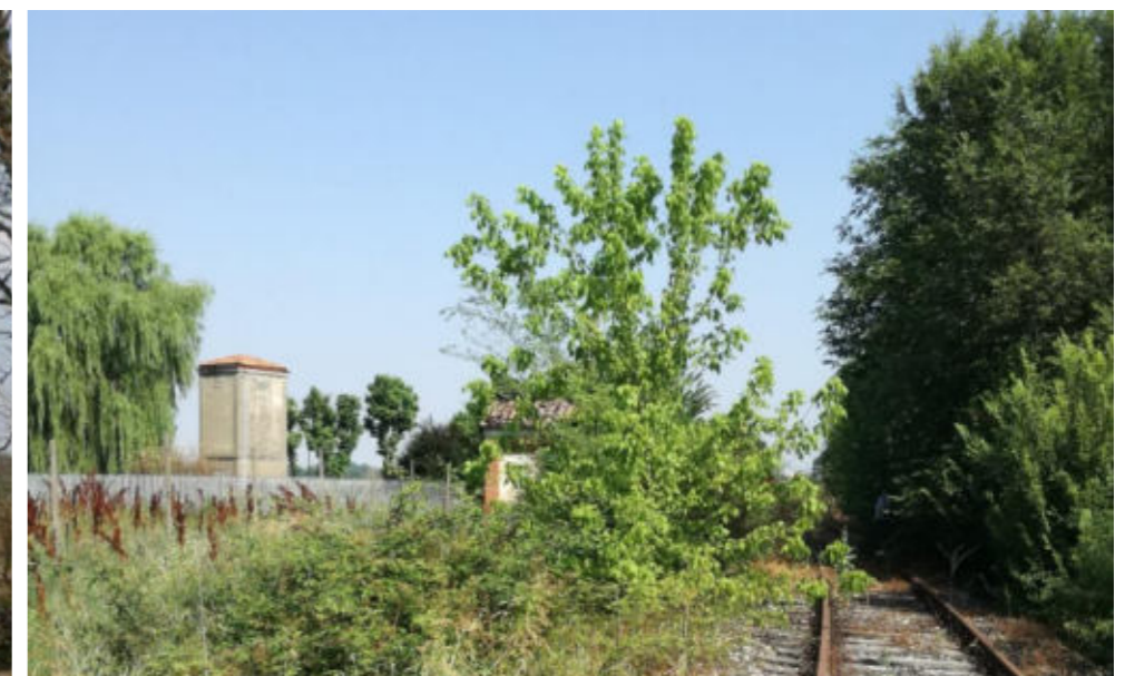
2 - Foto fabbricato collabente direzione Bondeno
