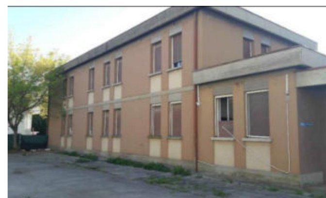
EDIFICIO 4: PALAZZINA UFFICI. L'edificio, di tipologia tradizionale a forma di C, è formato da due piani fuori terra. Presenta una struttura mista in muratura e cemento armato con tamponamenti laterali in laterizio intonacati e tinteggiati, e copertura piana con finitura superficiale in guaina ardesiata.
