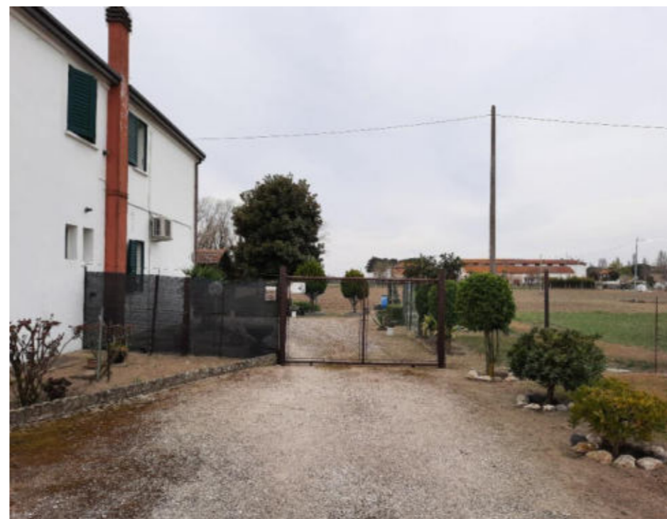
Figura 10. Foto Fonte: Regione Emilia-Romagna – sopralluogo 2022
