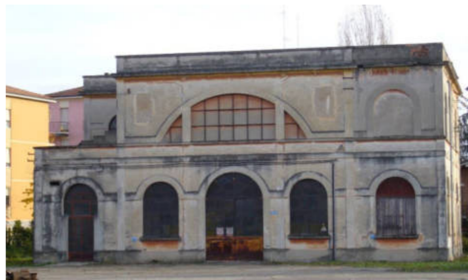
Figura 18 – Sottostazione elettrica (SSE), foglio 175, part. 205
