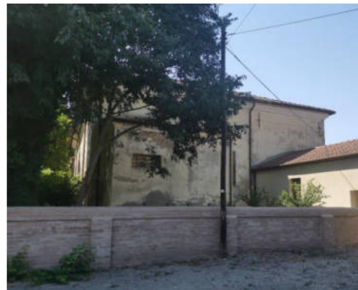
Figura 30. Foto Fonte: Regione Emilia-Romagna sopralluogo 2022
