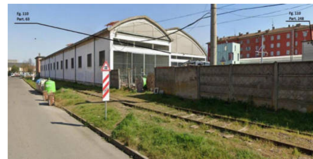
4 - Inquadramento capannone autorimessa e torre impianti, foglio 110, part. 63 - 248
