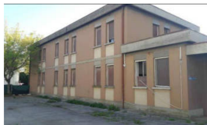
EDIFICIO 4: PALAZZINA UFFICI. L'edificio, di tipologia tradizionale a forma di C, è formato da due piani fuori terra. Presenta una struttura mista in muratura e cemento armato con tamponamenti laterali in laterizio intonacati e tinteggiati, e copertura piana con finitura superficiale in guaina ardesiata.
