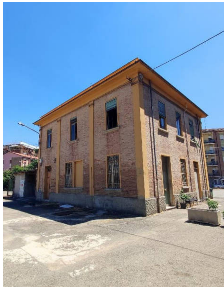
12 – Fabbricato spogliatoio, foglio 175, part. 199
