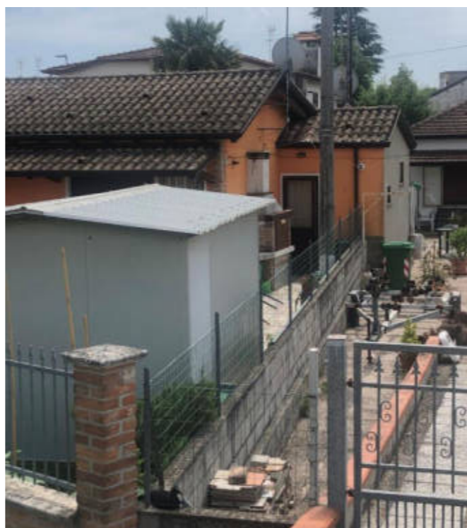
Figura 22. Foto fonte: Regione Emilia-Romagna – sopralluogo 2022
