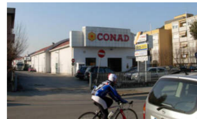
EDIFICIO 2: EX INCUBATOIO. Il complesso è una tipologia "in linea" con struttura mista in muratura e cemento armato con tamponamenti laterali in intonacati e tinteggiati; il tutto sormontato, nella porzione principale, da una copertura voltata con finitura superficiale in guaina ardesiata, mentre nella porzione di fabbricato ad ovest è presente una copertura a falde in laterizio.
