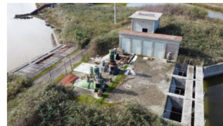
Figura 5. Ex SIVALCO Fonte: Regione Emilia – Romagna sopralluogo 2023
