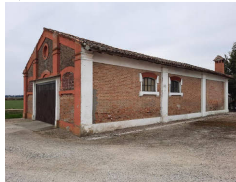
Figura 8. Foto Fonte: Regione Emilia-Romagna – sopralluogo 2022
