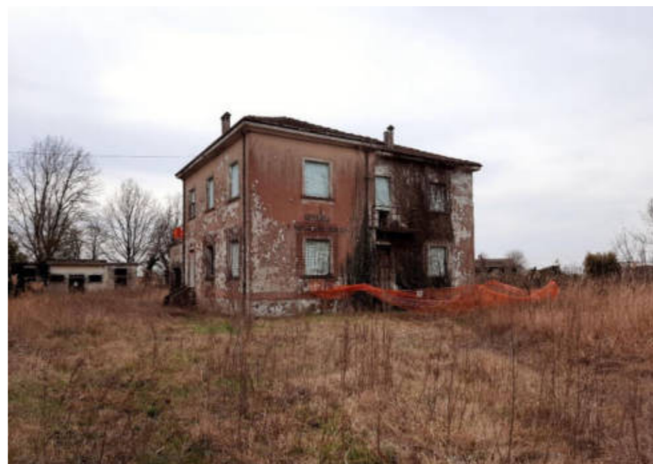
Figura 15. Foto Fonte: Regione Emilia-Romagna - sopralluogo 2022
