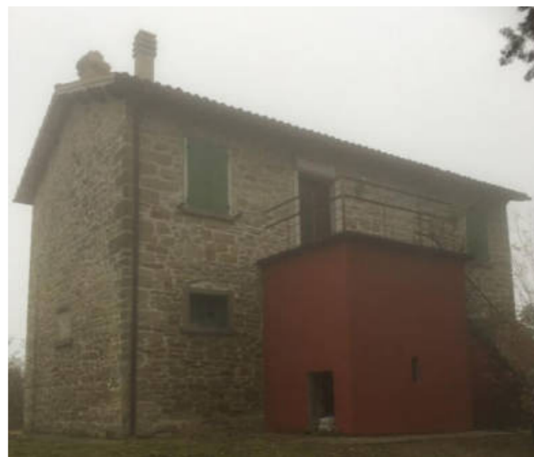
Figura 1. Foto il Fabbricato principale Fonte: Sopralluogo RER – 2018
