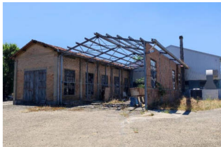
14 – Fabbricato ex lavaggio, foglio 175, part. 197
