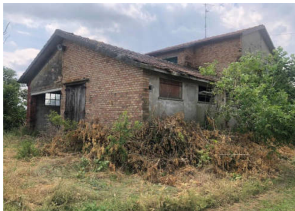
Figura 1. Foto Fonte: Regione Emilia-Romagna – sopralluogo 2022
