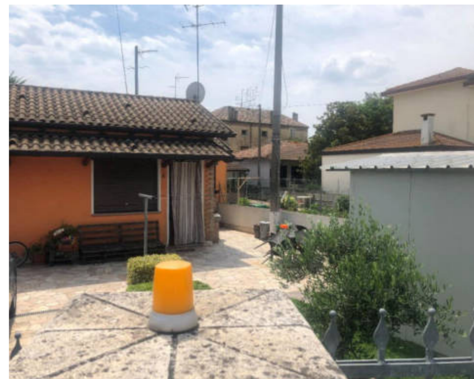
Figura 23. Foto fonte: Regione Emilia-Romagna – sopralluogo 2022
