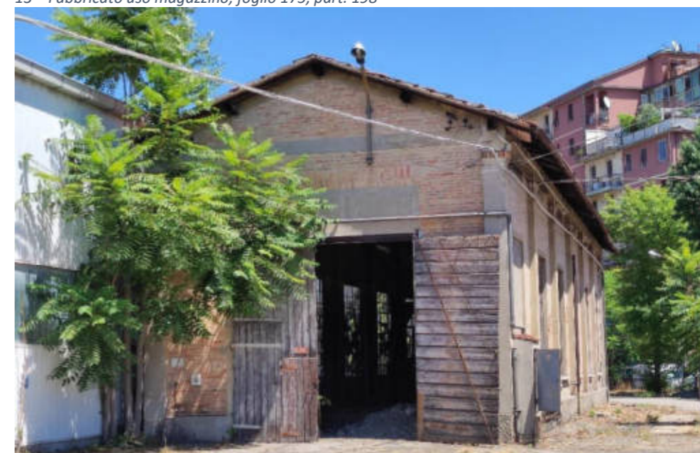
14 – Fabbricato ex lavaggio, foglio 175, part. 197 – Altra Vista
