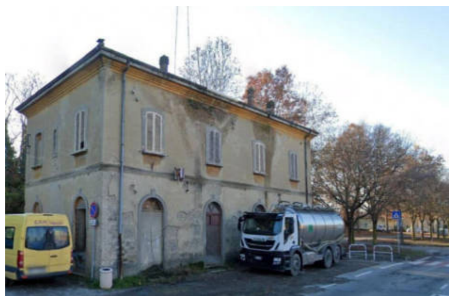
5 - Altra visuale ex fabbricato viaggiatori, foglio 19, particella 410
