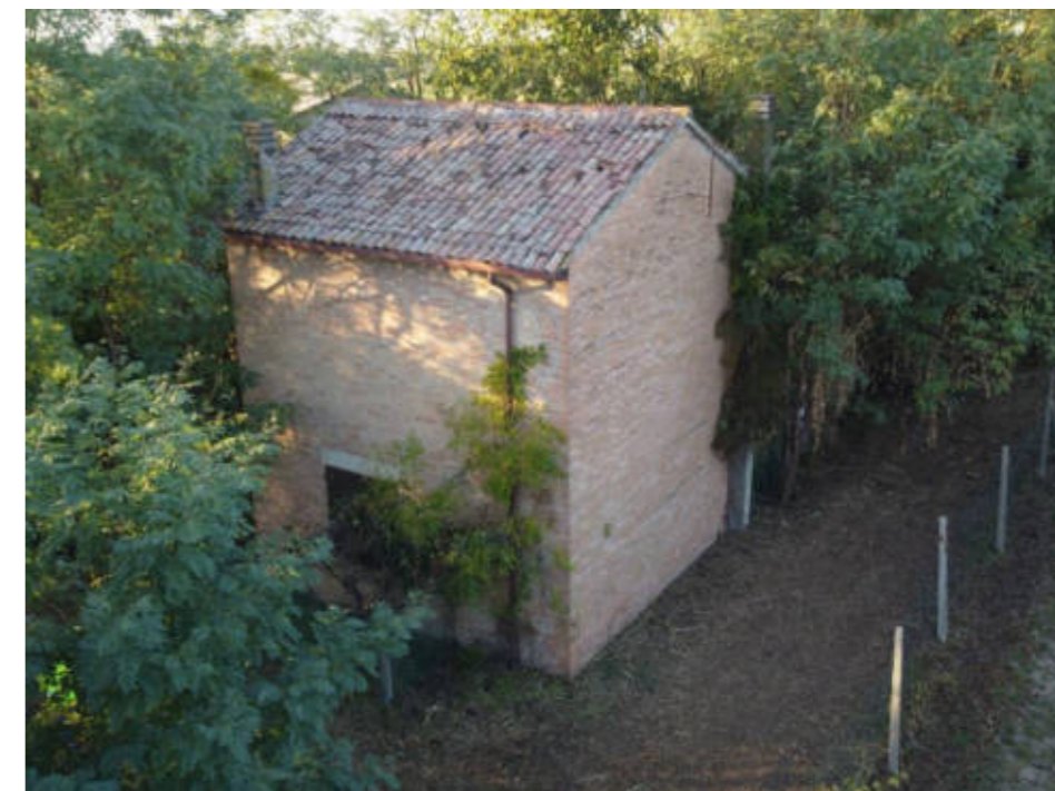
Figura 6. Foto Fonte: Regione Emilia-Romagna – sopralluogo 2023
