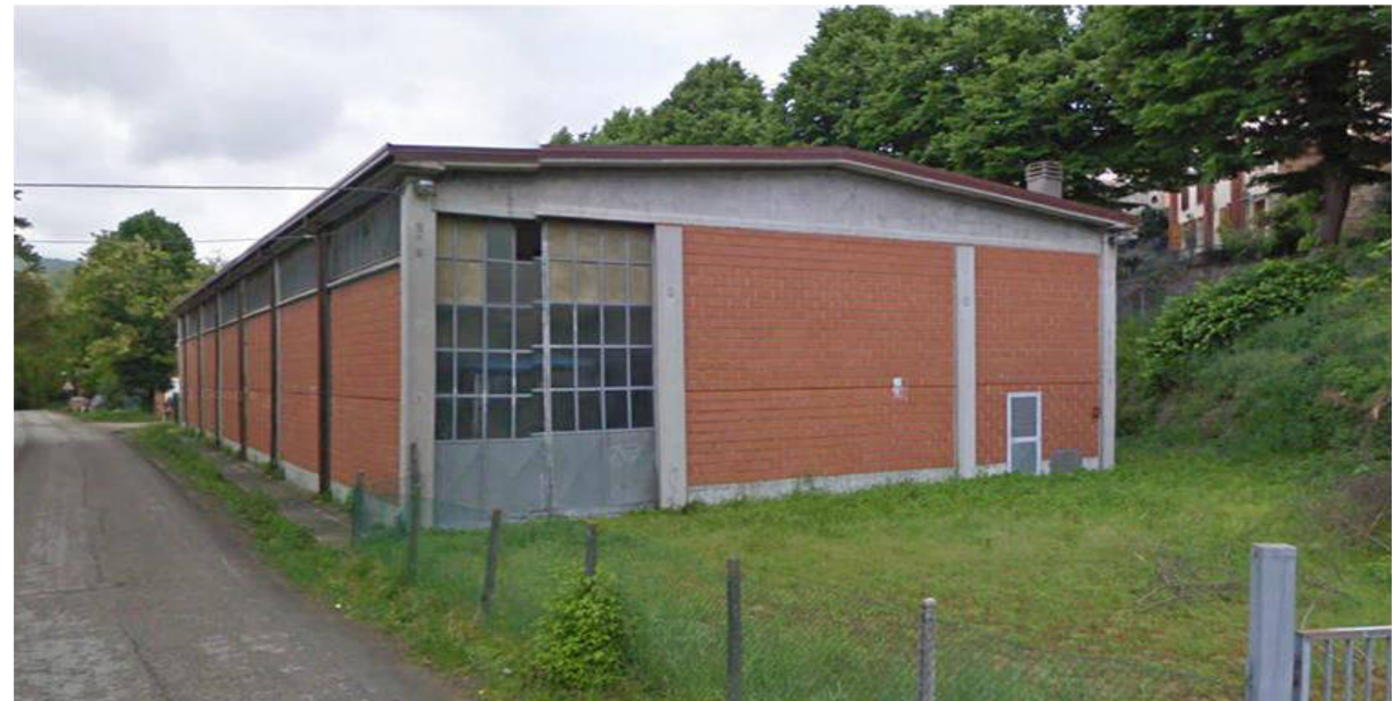
4 – Deposito/officina Autobus (ex magazzino ferroviario, foglio 13, particella 549, sub. 4
