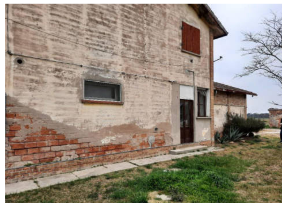
Figura 14. Foto Fonte: Regione Emilia-Romagna – Sopralluogo 2022
