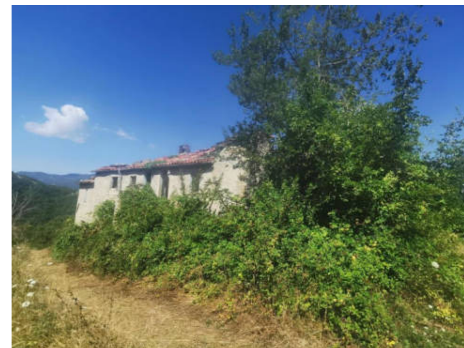
10 - Il fabbricato principale visto da monte; Fonte: Regione Emilia-Romagna - sopralluogo 2024
