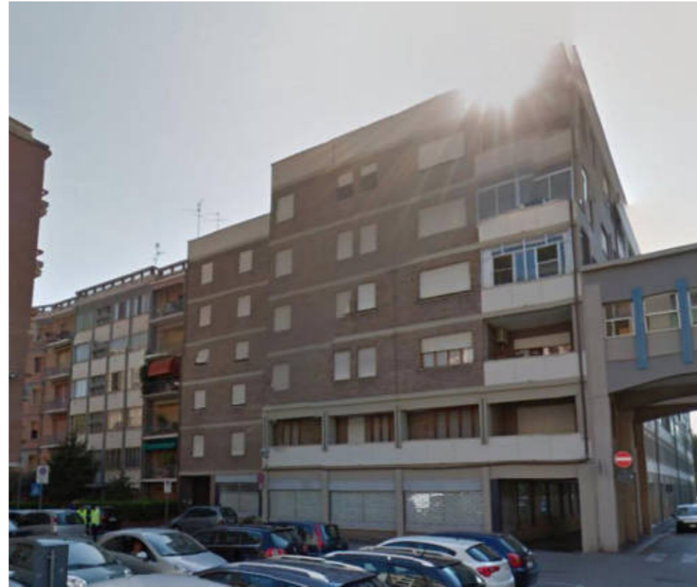
Figura 29-Vista frontale del complesso immobiliare
