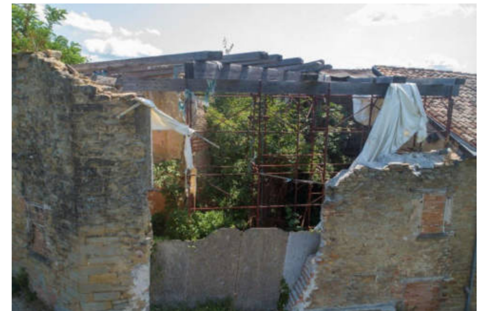
10 - Il fabbricato visto con il drone; Fonte: Regione Emilia-Romagna - sopralluogo 2024
