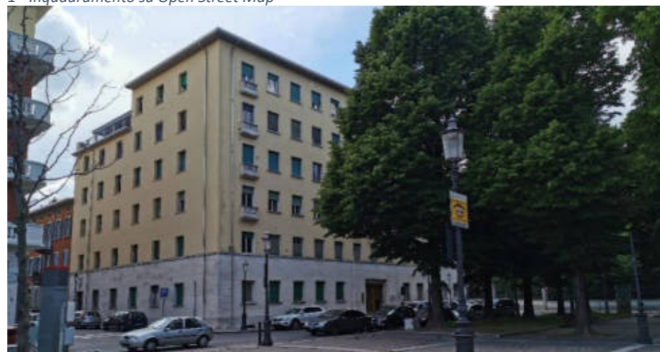
Figura 1. Foto Fonte: Regione Emilia-Romagna sopralluogo 2021
