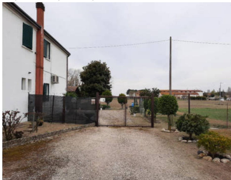
Figura 7. Foto Fonte: Regione Emilia-Romagna – sopralluogo 2022
