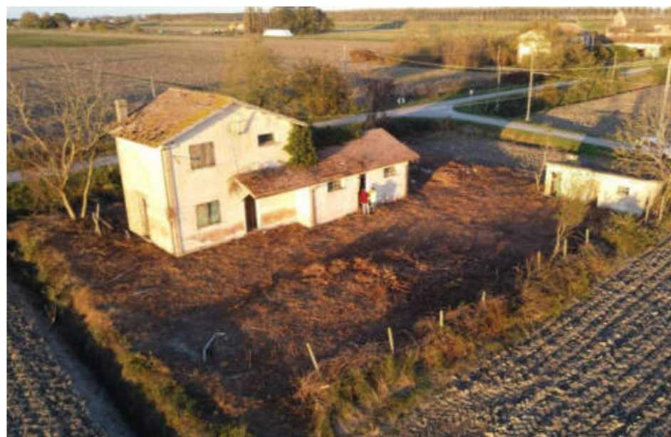
Figura 16. Foto Fonte: Regione Emilia-Romagna – Sopralluogo 2023
