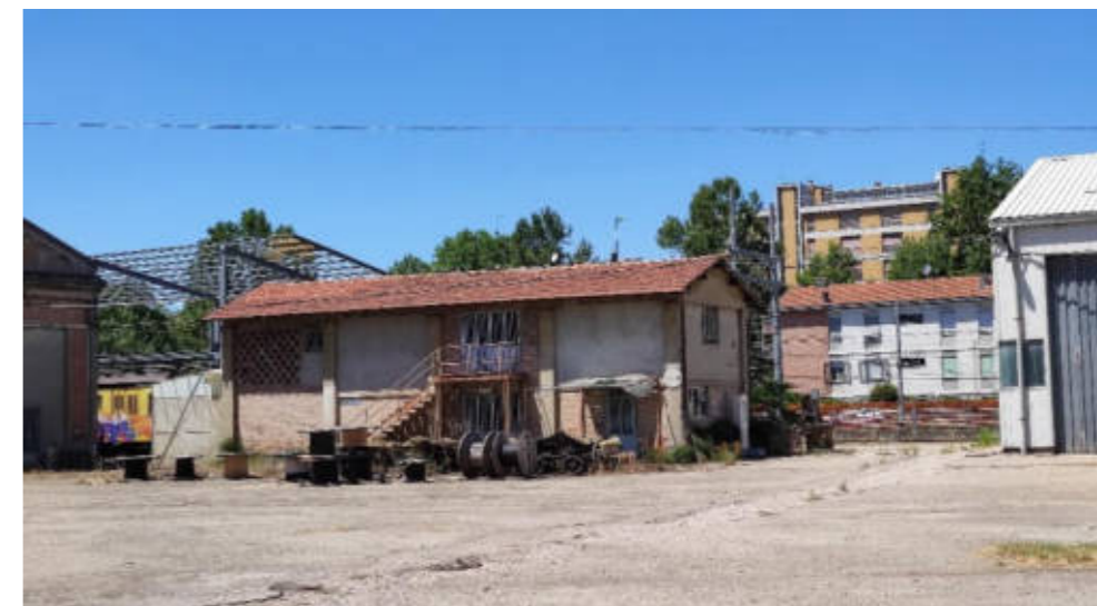
13 – Fabbricato uso magazzino, foglio 175, part. 198
