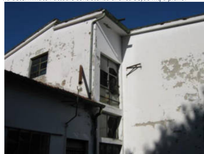
Figura 36. Fabbricato C - magazzini, locali allevamento, spogliatoi, servizi, mensa. Edificio in muratura di mattoni e solaio in laterocemento con manto di copertura in cotto, costituito da tre corpi di fabbrica per una superficie complessiva di circa 735,00 mq al piano terra, 560,00 mq al piano primo.
