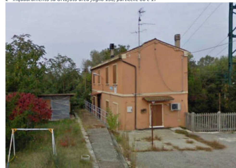
Figura 34 - Foto vista Casa cantoniera interno alla particella 17 del foglio 130
