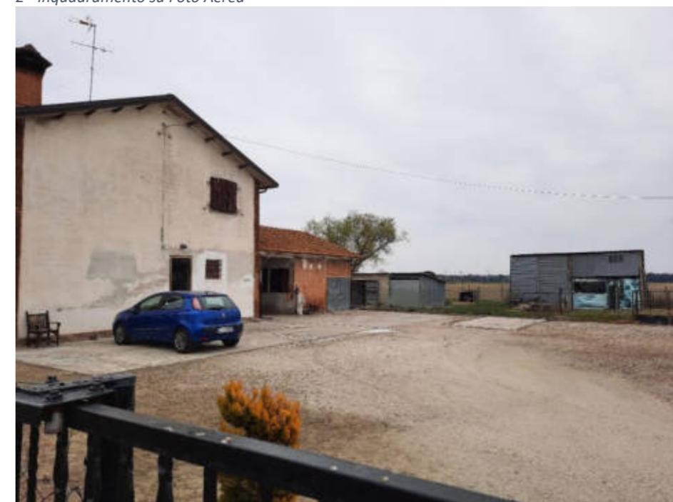
Figura 12 Foto Fonte: Regione Emilia-Romagna – Sopralluogo 2022
