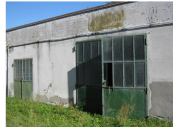
Figura 38. Fabbricato B - cantina e ricovero attrezzi. Piccolo edificio costruito in muratura di mattoni con copertura piana in laterocemento, della superficie lorda complessiva di circa 75,00 mq, disposta sul solo piano terra e suddivisa in due locali.
