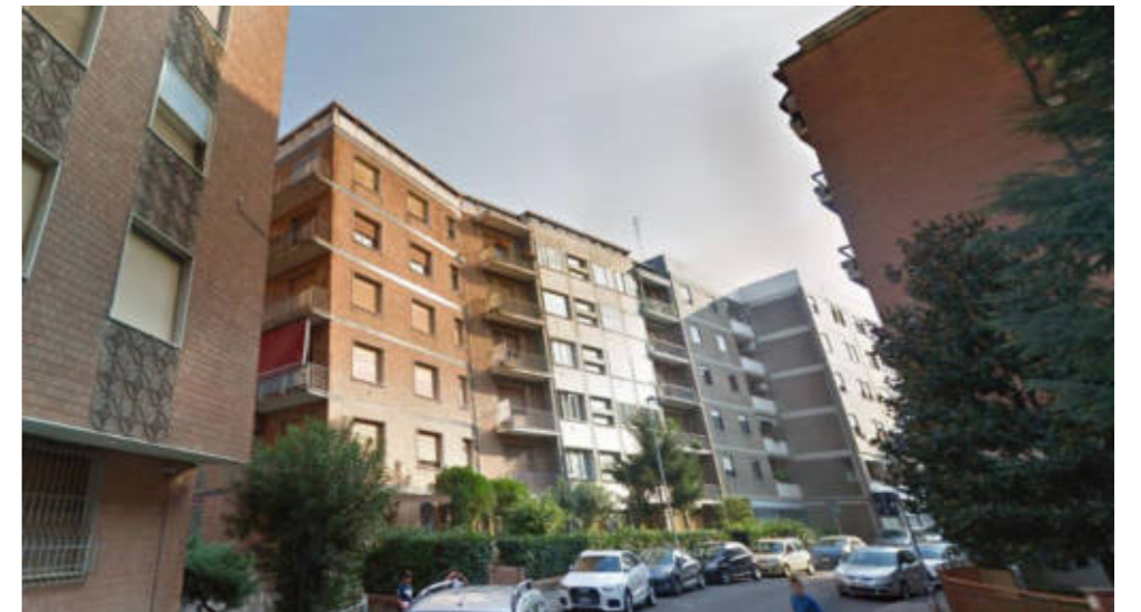
Figura 31-Vista del complesso immobiliare
