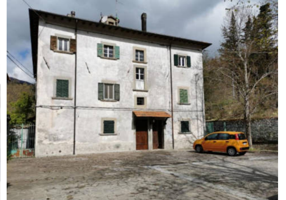
Figura 12. Foto Fonte: Regione Emilia-Romagna sopralluogo 2021
