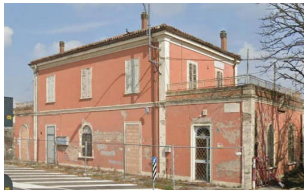
5 - Lato Suzzara vista Ex F.V. Vecchia Stazione di Bondeno Foglio 127 - Mappale 176
