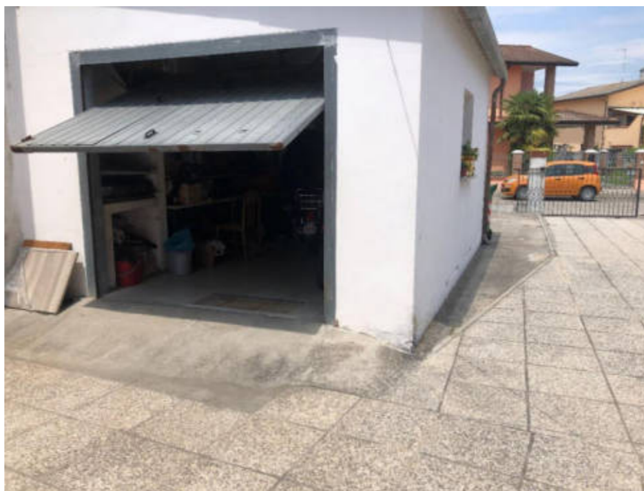
Figura 18. Foto fonte: Regione Emilia-Romagna – sopralluogo 2022
