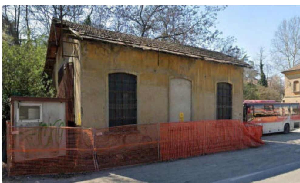
6 - Altra visuale ex deposito locomotori, foglio 19, particella 412
