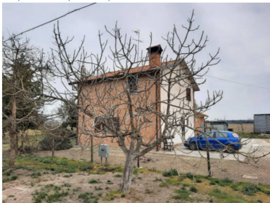
Figura 11 Foto Fonte: Regione Emilia-Romagna – Sopralluogo 2022
