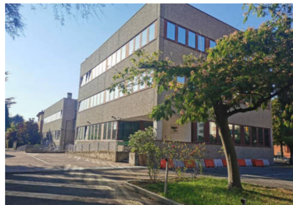
Figura 7. Foto Fonte: Regione Emilia-Romagna sopralluogo 2022
