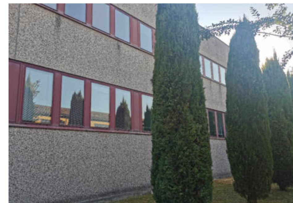
Figura 8. Foto Fonte: Regione Emilia-Romagna sopralluogo 2022
