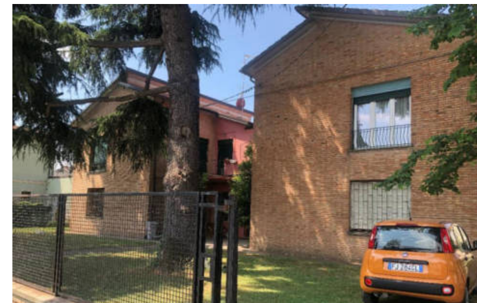
Figura 14. Foto Fonte: Regione Emilia-Romagna - sopralluogo 2022
