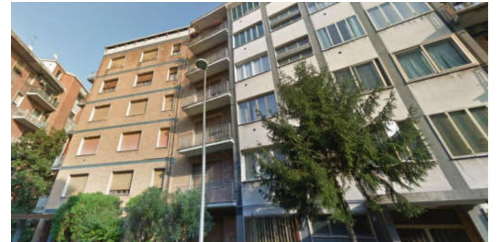
Figura 30-Vista frontale del complesso immobiliare
