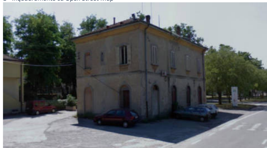
3 - Inquadramento ex fabbricato viaggiatori, foglio 19, particella 410
