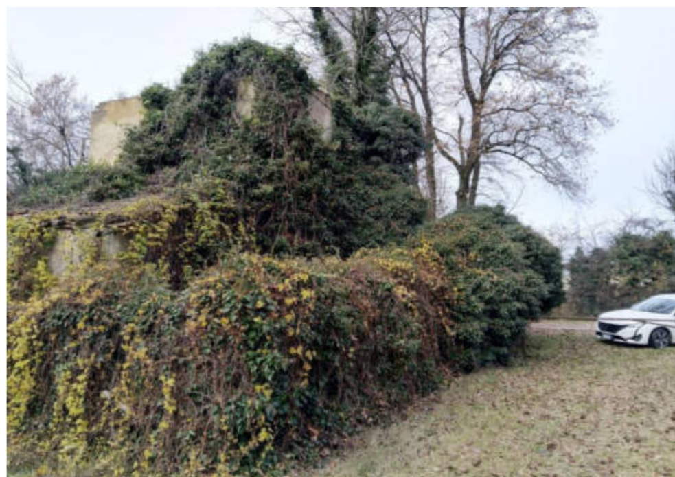
4 - Inquadramento casa cantoniera ex tratta ferroviaria Bagnolo – altra visuale
