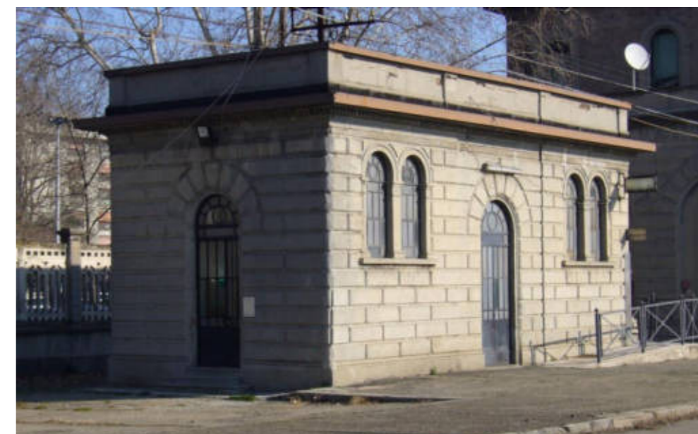
Figura 19 – Pertinenza Stazione Modena Piazza Manzoni foglio 175, part. 189
