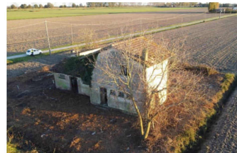
Figura 17. Foto Fonte: Regione Emilia-Romagna – Sopralluogo 2023
