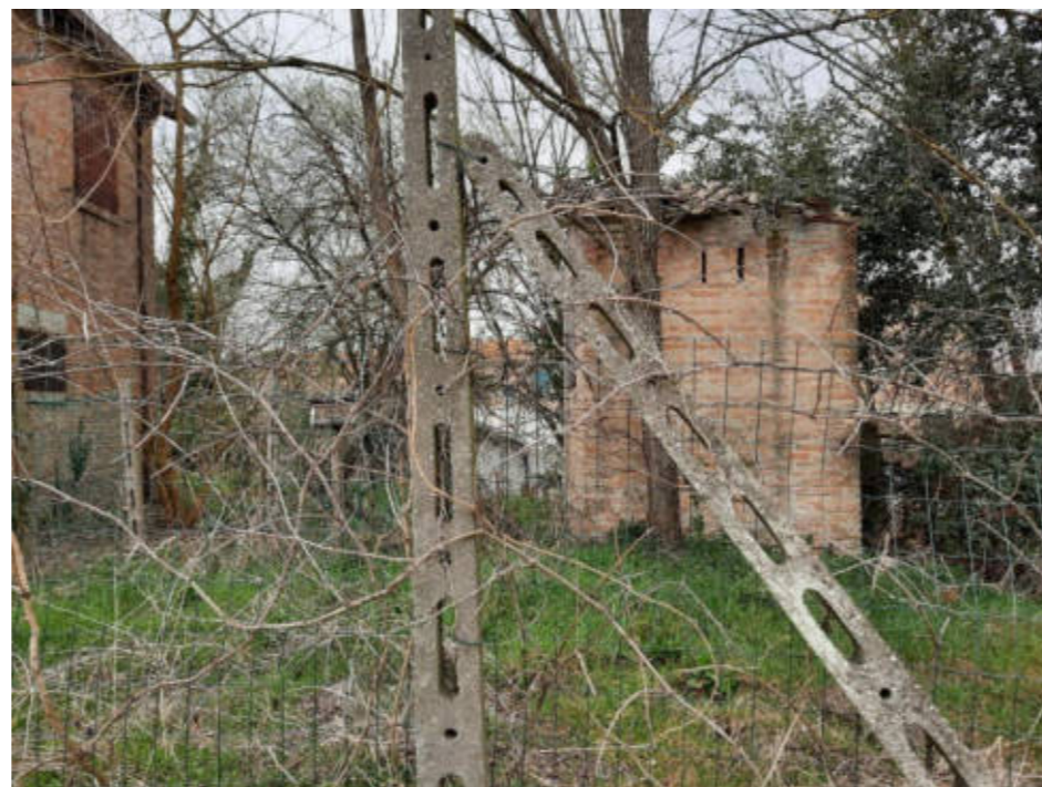
Figura 5. Foto Fonte: Regione Emilia-Romagna -sopralluogo 2022
