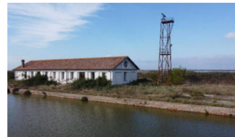
Figura 3. Ex SIVALCO Fonte: Regione Emilia – Romagna sopralluogo 2023
