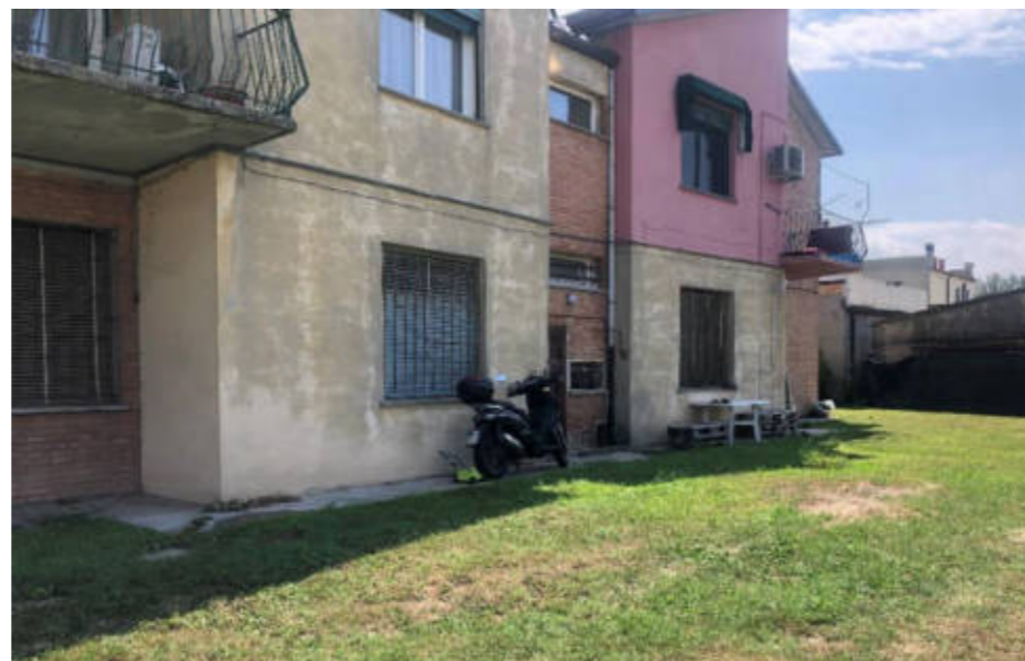
Figura 13. Foto Fonte: Regione Emilia-Romagna - sopralluogo 2022
