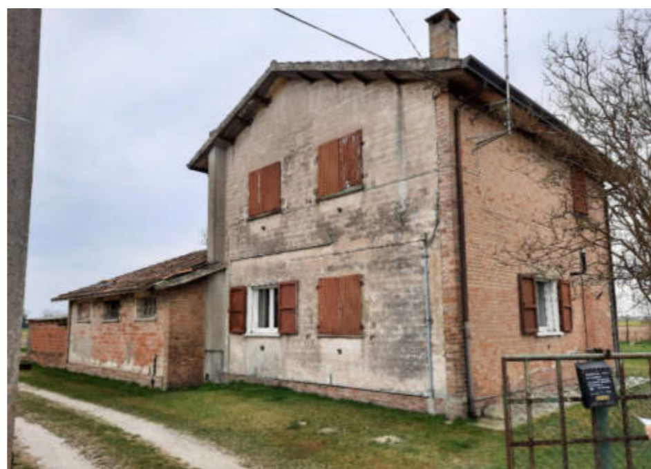
Figura 13. Foto Fonte: Regione Emilia-Romagna – Sopralluogo 2022
