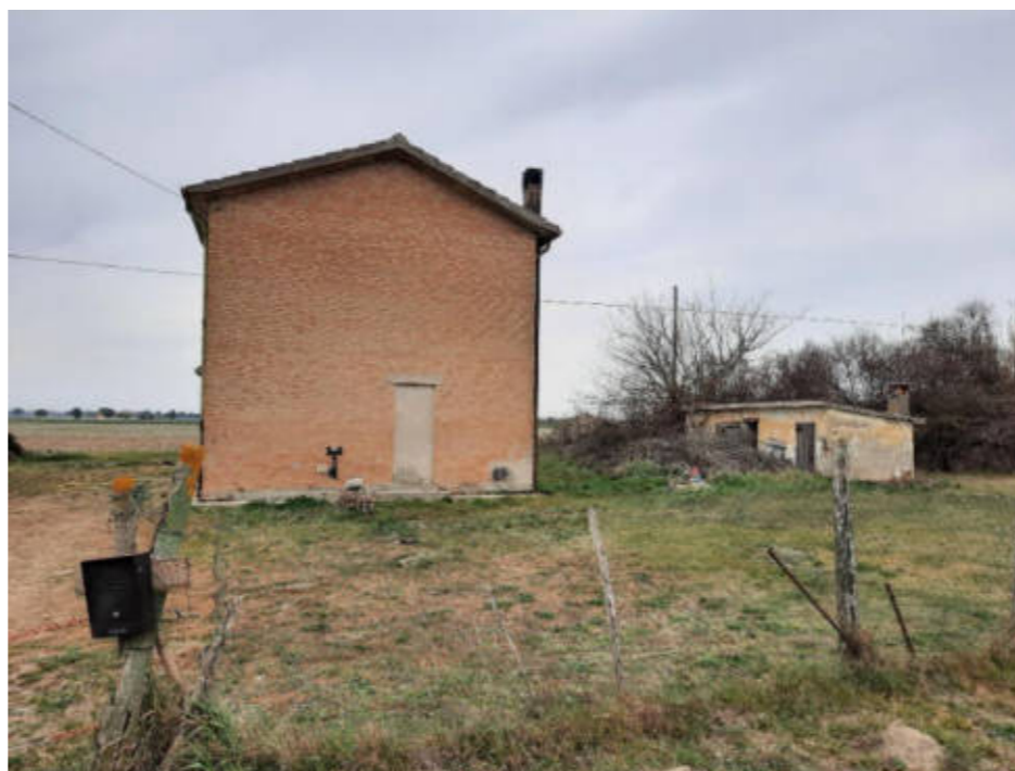
Figura 9. Foto Fonte: Regione Emilia-Romagna – sopralluogo 2022
