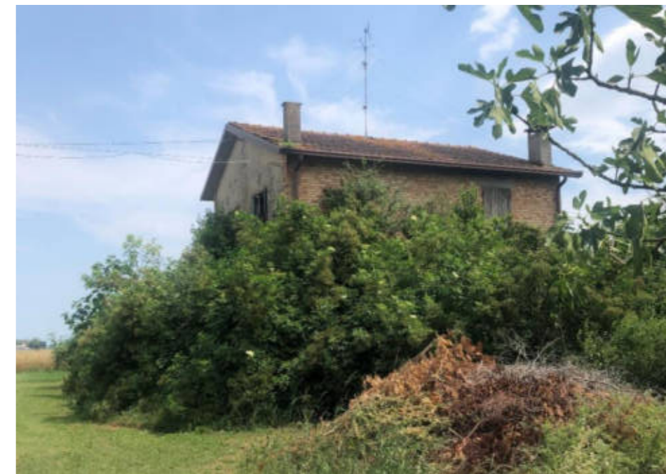
Figura 2. Foto Fonte: Regione Emilia-Romagna – sopralluogo 2022
