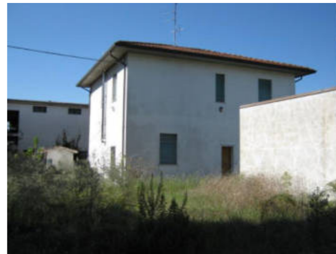
Figura 35. Fabbricato A - palazzina uffici e abitazione del custode. Edificio in muratura e cemento armato originariamente costituito dal solo piano terra, poi oggetto di un intervento di sopraelevazione che ne ha determinato l'attuale consistenza di circa 98,00 mq a piano.
