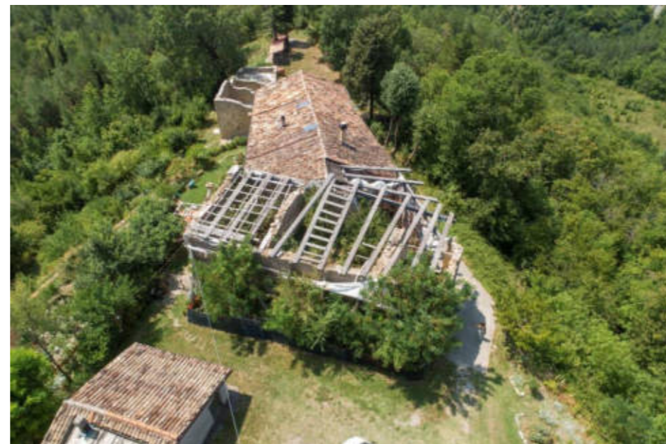
10 - Il fabbricato visto con il drone; Fonte: Regione Emilia-Romagna - sopralluogo 2024
