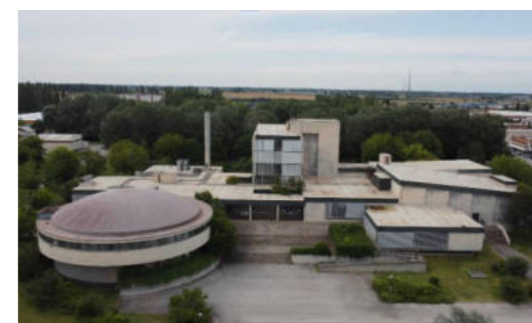
Figura 14. Foto Part. 11 (palazzina ex C.O). Fonte: : Regione Emilia-Romagna sopralluogo 2023
