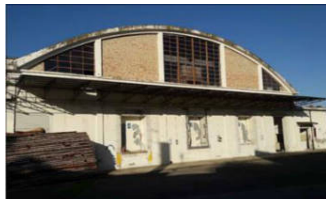
EDIFICIO 1: MACELLO. L'edificio 1 si presenta come una tipologia "a blocco" a forma di L, con una struttura mista in muratura e cemento armato con tamponamenti laterali in laterizio intonacati e tinteggiati. La copertura è voltata, di ampie luci, con travi in cemento armato e finitura superficiale in guaina ardesiata.
