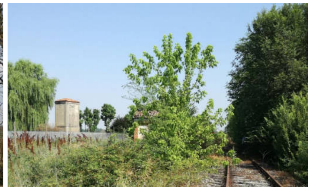
2 - Foto fabbricato collabente direzione Bondeno
