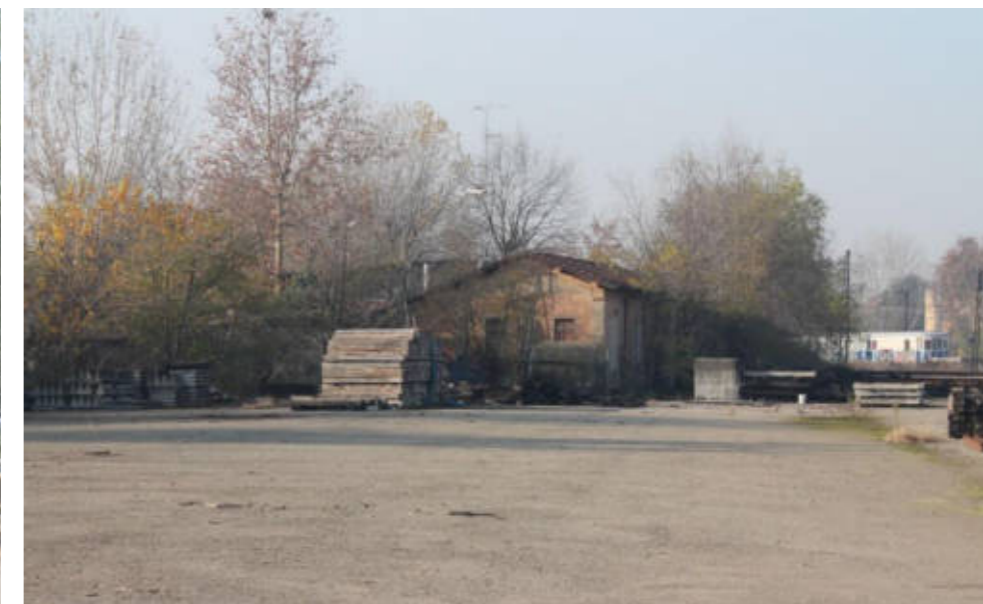
8 – Fabbricato ex circolo ferroviario, foglio 175, part. 204
