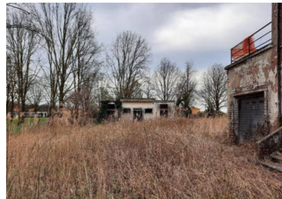
Figura 16. Foto Fonte: Regione Emilia-Romagna - sopralluogo 2022
