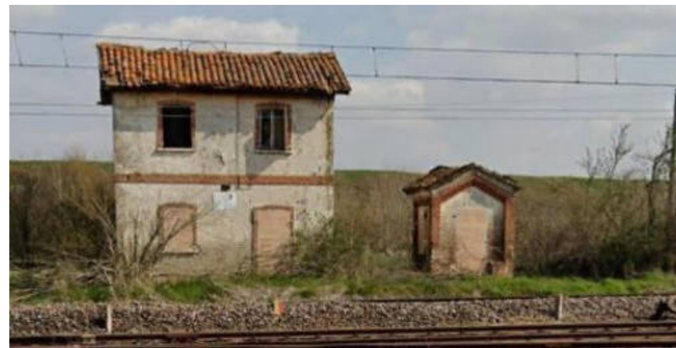
3 - Lato Suzzara vista Casa Cantoniera Foglio 127 - Mappale 40
