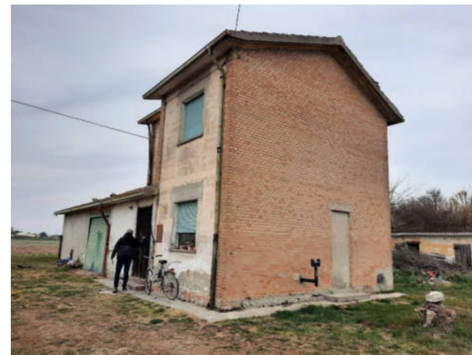
Figura 10. Foto Fonte: Regione Emilia-Romagna – sopralluogo 2022
