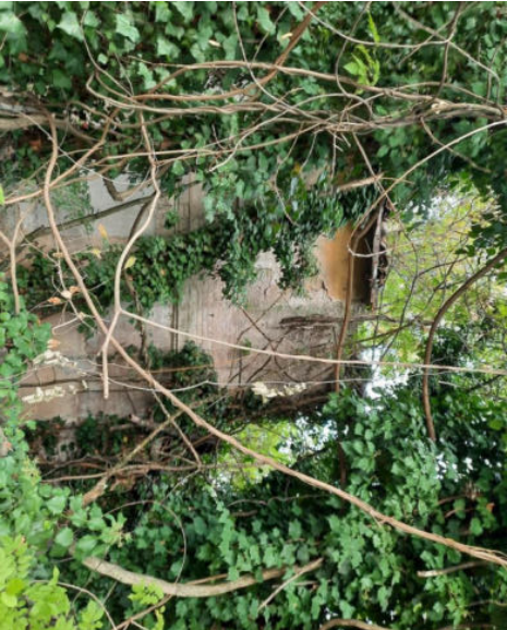
3 - Inquadramento casa contorniera ex tratt. ferroviaria Bagnole – Carpi
