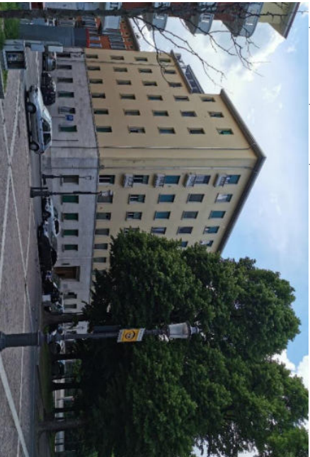
Figura 1. Foto fonte: Regione Emilia-Romagna sopralluogo 2021
