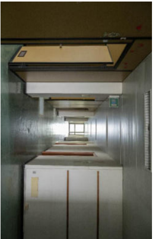
Figura 22 Part.11 (palazzina uffici ex COO). Fonte: Regione Emilia Romagna sopralluogo luglio 2023
