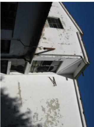
Figura 40. Fabbricato A - palazzina uffici e abitazione del custode. Edificio in muratura e cemento armato originariamente costituito dal solo piano terra, poi oggetto di un intervento di sopraelevazione che ne ha determinato l'attuale consistenza di circa 98,00 mq a piano.
