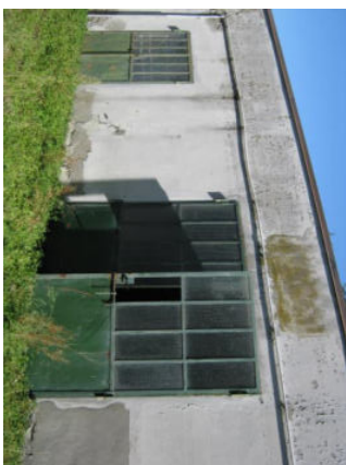
Figura 43. Fabbricato B - cantina e ricovero attrezzi. Piccolo edificio costruito in muratura di mattoni con copertura piana in laterocemento, della superficie lorda complessiva di circa 75,00 mq, disposta sul solo piano terra e suddivisa in due locali.
