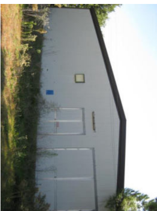
Figura 43. Fabbricato B - cantina e ricovero attrezzi. Piccolo edificio costruito in muratura di mattoni con copertura piana in laterocemento, della superficie lorda complessiva di circa 75,00 mq, disposta sul solo piano terra e suddivisa in due locali.
