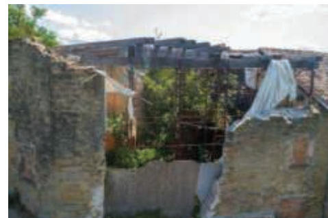
4 - Il fabbricato visto con il drone; Fonte: Regione Emilia-Romagna - sopralluogo 2024
