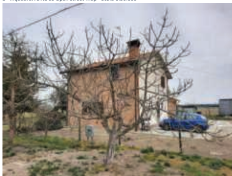
3 - Foto Fonte: Regione Emilia-Romagna – Sopralluogo 2022
