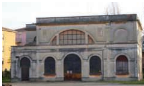
Figura 19 – Sottostazione elettrica (SSE), foglio 175, part. 205
