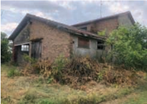
3 - Foto Fonte: Regione Emilia-Romagna – sopralluogo 2022
