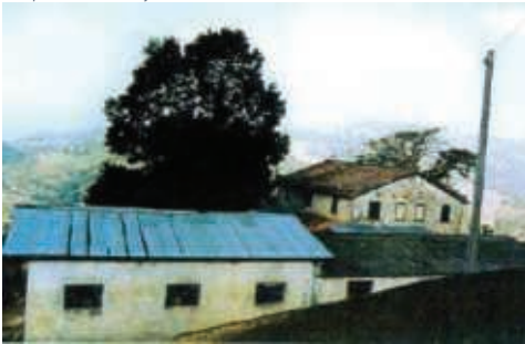
4 - Foto realizzata da tecnici della Regione Emilia-Romagna nel sopralluogo 1987
