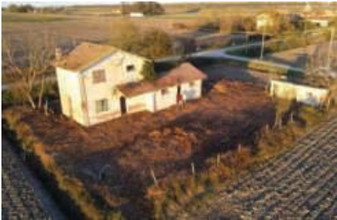
3 - Foto Fonte: Regione Emilia-Romagna – Sopralluogo 2023
