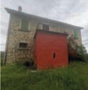
3 - Il Fabbricato principale Fonte: Sopralluogo RER – 2024
