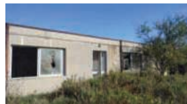
6 - Ex SIVALCO Fonte: Regione Emilia – Romagna sopralluogo 2023
