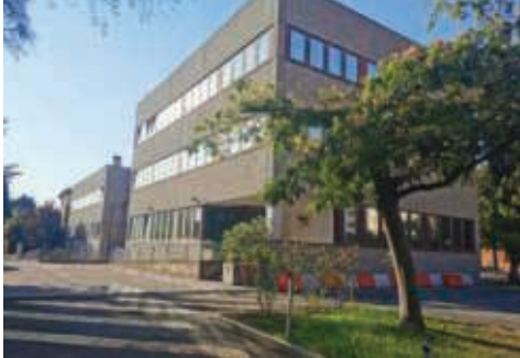
3 - Foto Fonte: Regione Emilia-Romagna sopralluogo 2022
