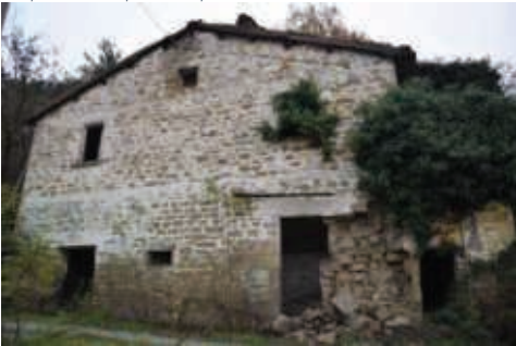
3 - Foto realizzata da tecnici della Regione Emilia-Romagna nel sopralluogo 2024
