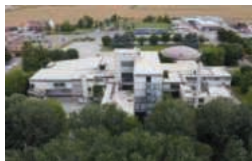
4 - Foto Part. 11 (palazzina ex C.O). Fonte: : Regione Emilia-Romagna sopralluogo 2023
