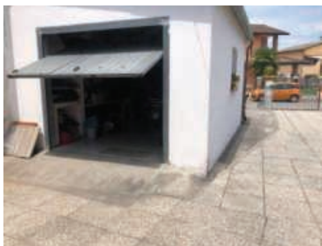
3 - Foto fonte: Regione Emilia-Romagna – sopralluogo 2022
