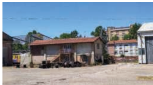
13 – Fabbricato uso magazzino, foglio 175, part. 198
