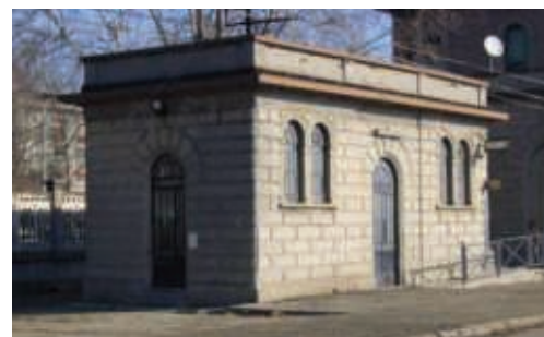
Figura 20 – Pertinenza Stazione Modena Piazza Manzoni foglio 175, part. 189
