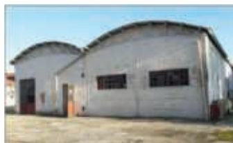
6 - EDIFICIO 3: CELLE E SERVIZI. L'edificio è costituito da due elementi "in linea" di analoga forma, dimensione e tipologia, di un piano fuori terra. Presenta una struttura portante in cemento armato con travi e pilastri e tamponamenti laterali in pannelli prefabbricati in cls tinteggiati, e copertura voltata con manto di copertura in lamiere grecate e finitura superficiale in guaina ardesiata.
