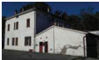
8 - EDIFICIO 5: CASA CUSTODE. L'edificio è una casa colonica in muratura intonacata e tinteggiata, costituita da due piani fuori terra e un piano sottotetto, oltre a un magazzino di un piano fuori terra. Gli infissi esterni sono con telai in legno. La copertura, a padiglione nella porzione adibita ad abitazione e a due falde nella porzione adibita a servizi, presenta una struttura portante con orditura lignea ed uno strato superiore di finitura in laterizio.
