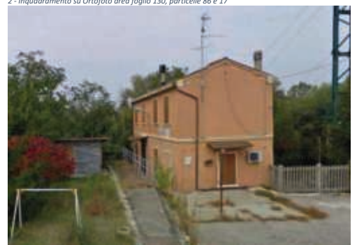
Figura 37 - Foto vista Casa cantoniera interno alla particella 17 del foglio 130
