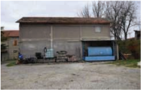
3 - Foto realizzata da tecnici della Regione Emilia-Romagna nel sopralluogo
