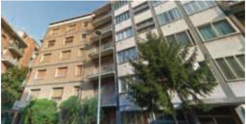
Figura 33- Vista frontale del complesso immobiliare
