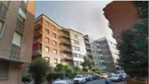
Figura 34- Vista del complesso immobiliare
