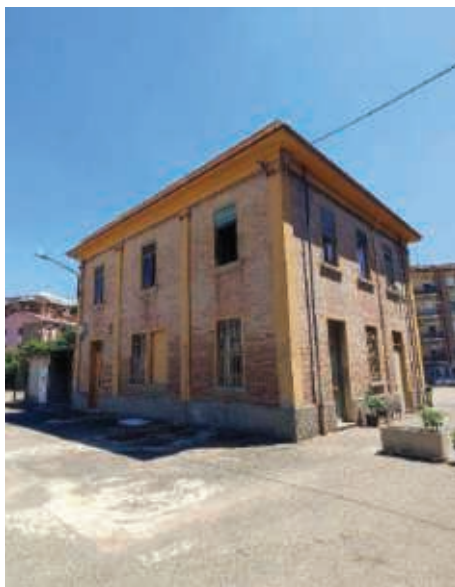
12 – Fabbricato spogliatoio, foglio 175, part. 199
