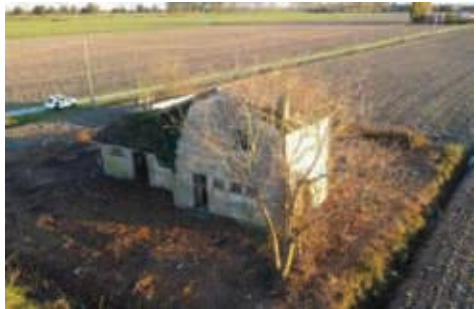
4 - Foto Fonte: Regione Emilia-Romagna – Sopralluogo 2023
