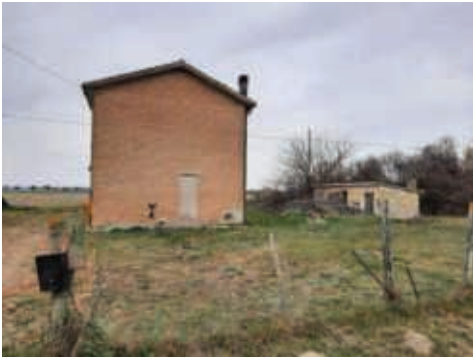
3 - Foto Fonte: Regione Emilia-Romagna – sopralluogo 2022
