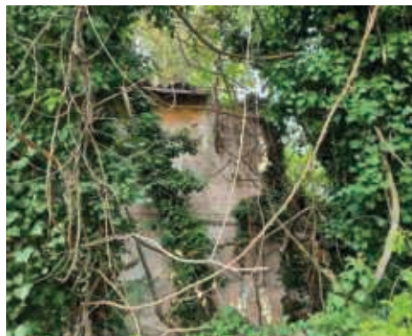
3 - Inquadrimento casa cantoniera ex tratti ferroviaria Bagnolo – Carpi
