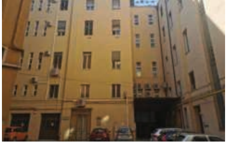
4 - Regione Emilia-Romagna sopralluogo 2022
