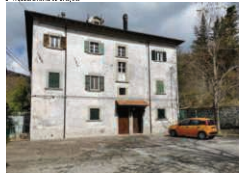
4 - Figura 3. Foto Fonte: Regione Emilia-Romagna sopralluogo 2021
