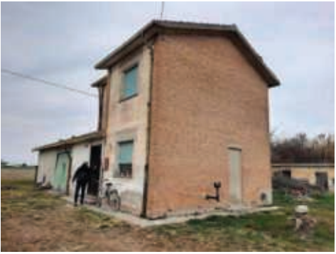
4 - Foto Fonte: Regione Emilia-Romagna – sopralluogo 2022
