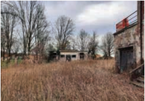
4 - Foto Fonte: Regione Emilia-Romagna - sopralluogo 2022
