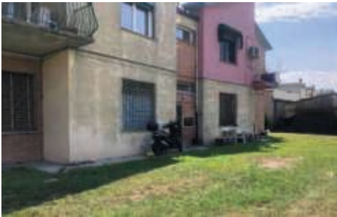
3 - Figura 4. Foto Fonte: Regione Emilia-Romagna - sopralluogo 2022
