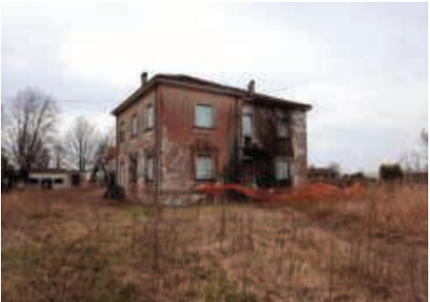
3 - Foto Fonte: Regione Emilia-Romagna - sopralluogo 2022
