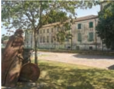
7 - Foto Fonte: Regione Emilia-Romagna sopralluogo 2022
