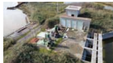
5 - Ex SIVALCO Fonte: Regione Emilia – Romagna sopralluogo 2023
