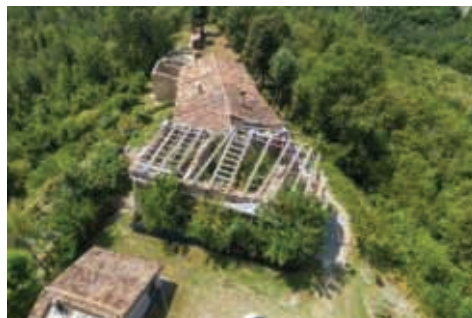
3 - Il fabbricato visto con il drone; Fonte: Regione Emilia-Romagna - sopralluogo 2024
