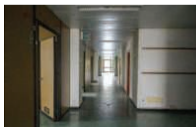
8 - Part.11 (palazzina uffici ex COO). Fonte_Regione Emilia Romagna sopralluogo luglio 2023
