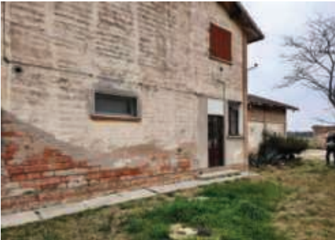
4 - Foto Fonte: Regione Emilia-Romagna – Sopralluogo 2022
