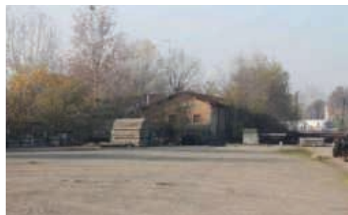
8 – Fabbricato ex circolo ferroviario, foglio 175, part. 204
