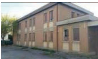
7 - EDIFICIO 4: PALAZZINA UFFICI. L'edificio, di tipologia tradizionale a forma di C, è formato da due piani fuori terra. Presenta una struttura mista in muratura e cemento armato con tamponamenti laterali in laterizio intonacati e tinteggiati, e copertura piano con finitura superficiale in guaina ardesiata.
