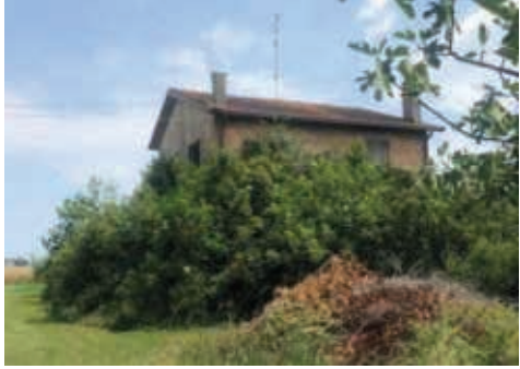
4 - Foto Fonte: Regione Emilia-Romagna – sopralluogo 2022
