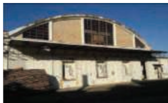
4 - EDIFICIO 1: MACELLO. L'edificio 1 si presenta come una tipologia "a blocco" a forma di L, con una struttura mista in muratura e cemento armato con tamponamenti laterali in laterizio intonacati e tinteggiati. La copertura è voltata, di ampie luci, con travi in cemento armato e finitura superficiale in guaina ardesiata.
