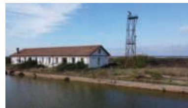
3 - Ex SIVALCO Fonte: Regione Emilia – Romagna sopralluogo 2023
