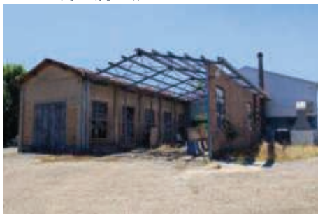
14 – Fabbricato ex lavaggio, foglio 175, part. 197
