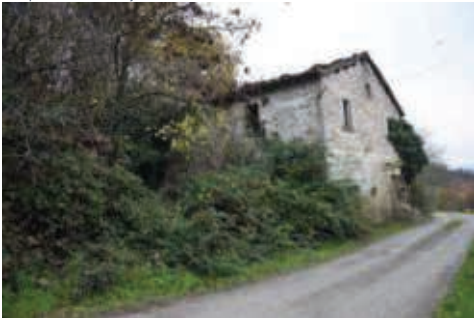
4 - Foto realizzata da tecnici della Regione Emilia-Romagna nel sopralluogo 2024
