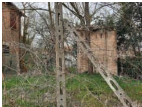
3 - Foto Fonte: Regione Emilia-Romagna -sopralluogo 2022
