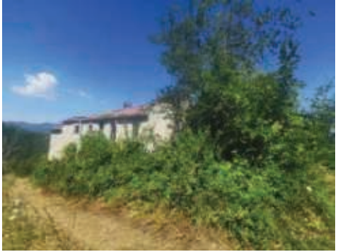
4 - Il fabbricato principale visto da monte; Fonte: Regione Emilia-Romagna – sopralluogo 2024
