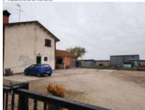
4 - Foto Fonte: Regione Emilia-Romagna – Sopralluogo 2022
