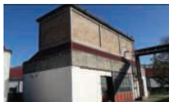
9 - EDIFICIO 7: locale tecnico ex centrale termica a gasolio. Il fabbricato è di forma rettangolare, con struttura in cemento armato travi-pilastri, tamponamenti in laterizio e copertura piana.
