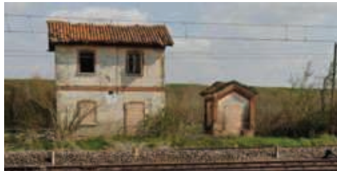
3 - Lato Suzzara vista Casa Cantoniera Foglio 127 - Mappale 40
