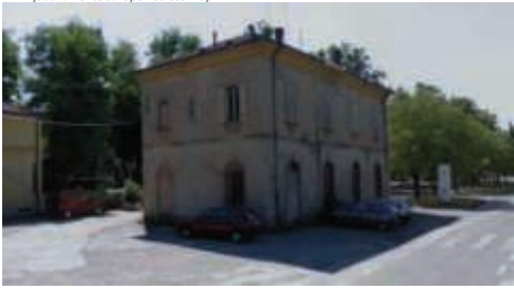
3 - Inquadramento ex fabbricato viaggiatori, foglio 19, particella 410
