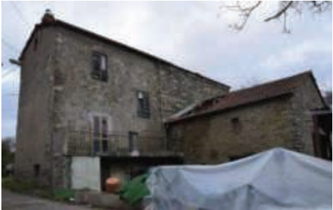
4 - Foto realizzata da tecnici della Regione Emilia-Romagna nel sopralluogo 2024
