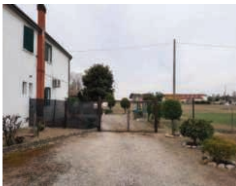
3 - Foto Fonte: Regione Emilia-Romagna – sopralluogo 2022
