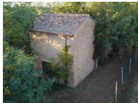
4 - Foto Fonte: Regione Emilia-Romagna - sopralluogo 2023
