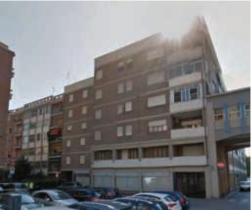
Figura 32- Vista frontale del complesso immobiliare
