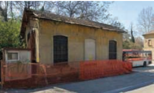
6 - Altra visuale ex deposito locomotori, foglio 19, particella 412
