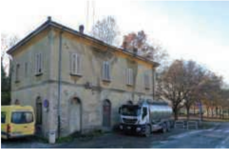
5 - Altra visuale ex fabbricato viaggiatori, foglio 19, particella 410
