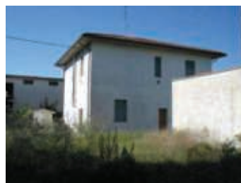
5 - Fabbricato A - palazzina uffici e abitazione del custode. Edificio in muratura e cemento armato originariamente costituito dal solo piano terra, poi oggetto di un intervento di sopraelevazione che ne ha determinato l'attuale consistenza di circa 98,00 mq a piano.
