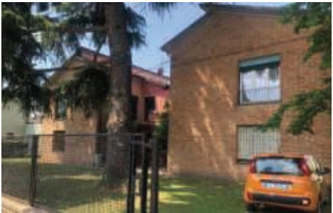
4 - Foto Fonte: Regione Emilia-Romagna - sopralluogo 2022
