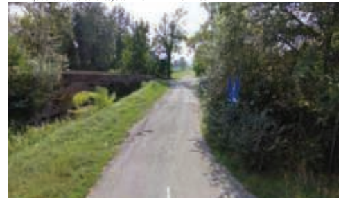
3 - area verde adiacente TRESINARO (ZONA 1) ex tratta ferroviaria
