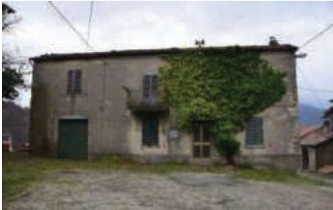
3 - Foto realizzata da tecnici della Regione Emilia-Romagna nel sopralluogo 2024
