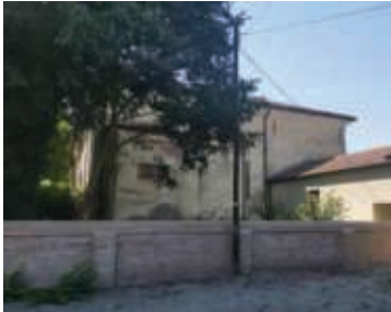
6 - Foto Fonte: Regione Emilia-Romagna sopralluogo 2022
