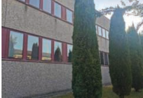
4 - Foto Fonte: Regione Emilia-Romagna sopralluogo 2022
