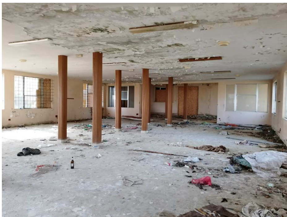
Interno: il piano terra, foto ottobre2023
