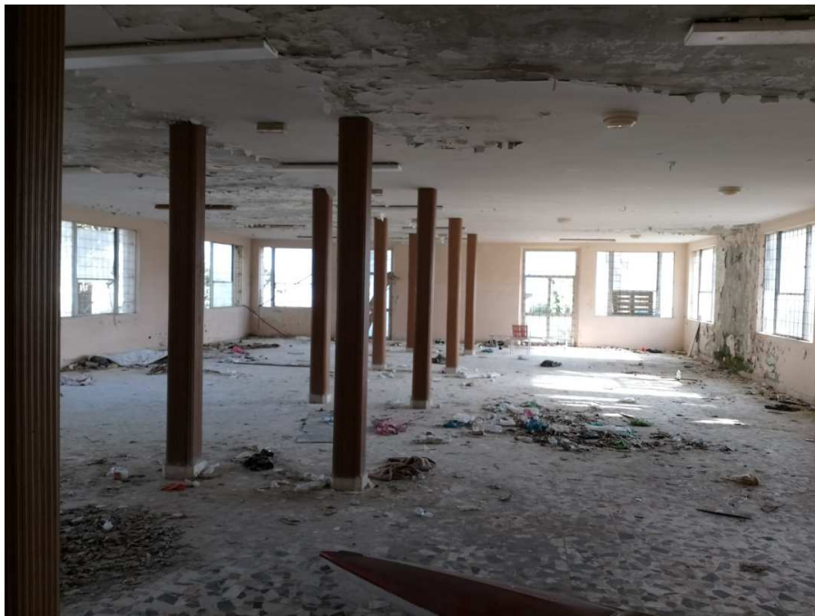
Interno: il piano terra, sala di soggiorno sottostante il terrazzo, foto ottobre2023
