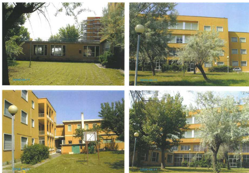
Documentazione fotografica allegata al progetto di riqualificazione, gennaio 2011
