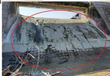
Figura 81 – Lavori di manutenzione straordinaria dei manufatti al servizio delle casse di espansione sul t. Enza (fonte: AIPo) – 2 di 3
