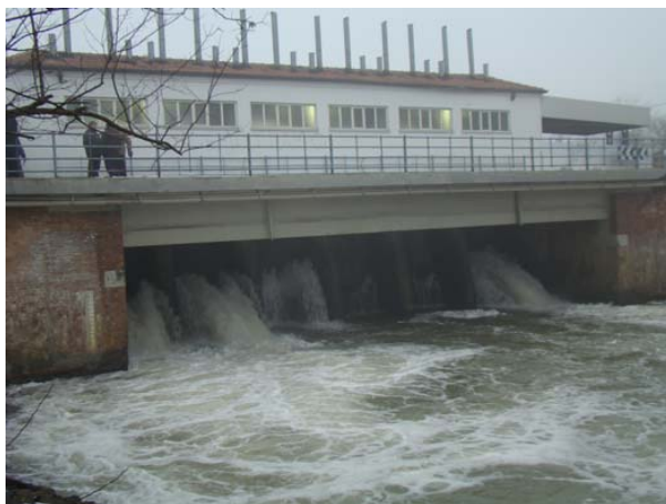
Fig17: Sostegno idraulico di Valpagliaro
