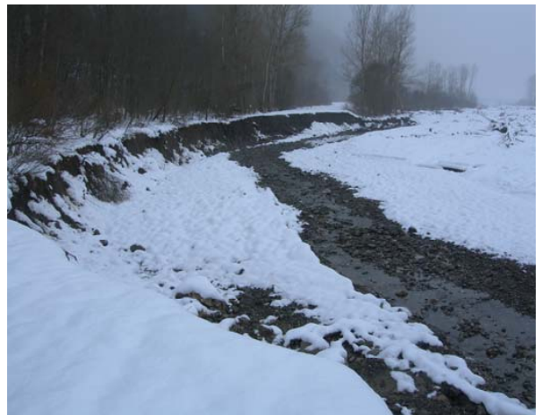
Fig14: a sinistra la frana di Montecasale (comune di Baiso); a destra erosione di sponda del fiume Secchia ed interruzione della pista Gatta Pianello
