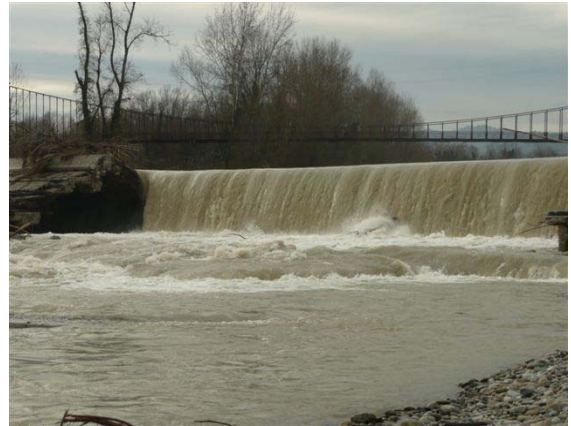
Fig16: Crollo del corpo centrale della briglia in località Palazzo Rossi sul fiume Reno
