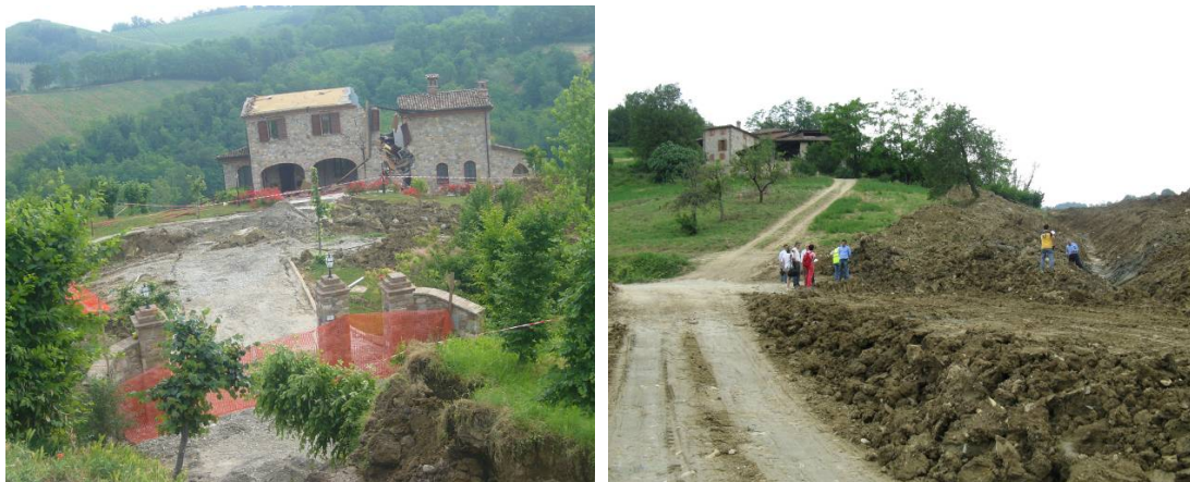
Figura 7. Frana di Fravica (Pianello Val Tidone): abitazione danneggiata di Casa del Gatto (a sinistra). Danneggiamento della S.P. n. 60 di Croce (a destra).
