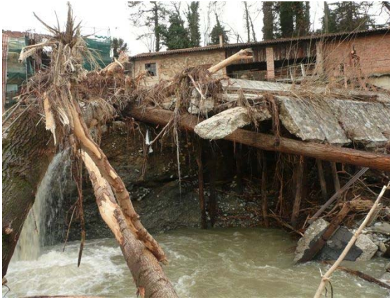
Fig16: Crollo del corpo centrale della briglia in località Palazzo Rossi sul fiume Reno
