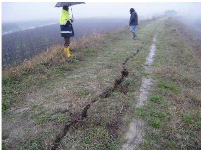
Fig18: Argine del Fiume Santerno con evidenti fenditure longitudinali
