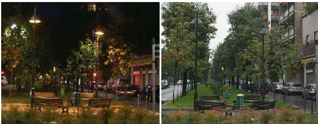
Fig.9 - Illuminazione (notturna e diurna) di aiuole e di giardini con impianto conforme alla L.R..19/2003 e della relativa direttiva applicativa [Immagine fornita da CieloBuio]
