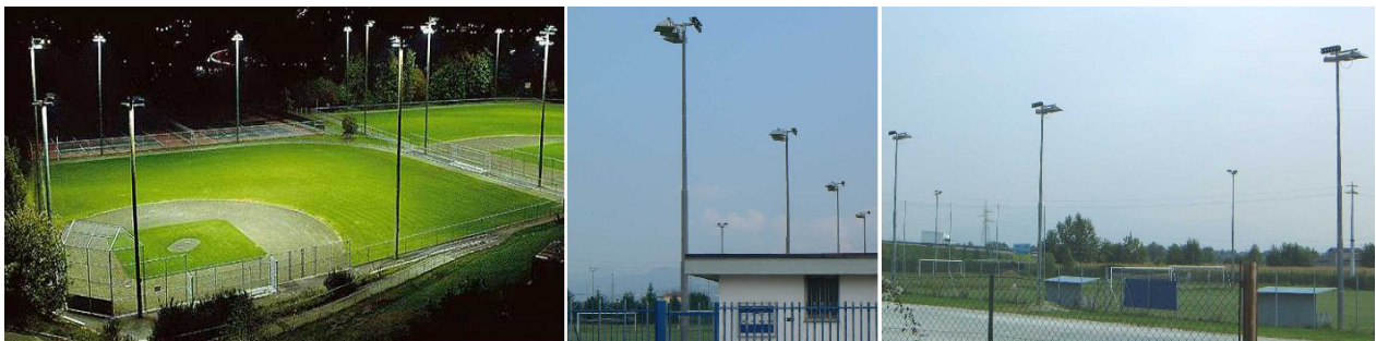
Fig.11 - Impianti sportivi illuminati in modo conforme alla L.R.19/2003 con proiettori asimmetrici orientati orizzontalmente e che non disperdono luce verso l'alto. [Immagine fornita da Cielobuio]
