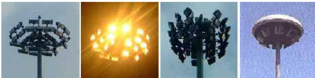
*Fig.17 - Torri faro "palesemente" inquinanti. Nell'ultimo impianto a destra infatti, il cappello ha l'unico obiettivo di proteggere gli apparecchi d'illuminazione dalle intemperie. [Immagine fornita da CieloBuio]*
