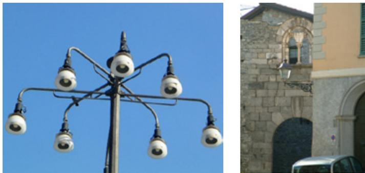
*Fig.4 – Esempio di messa a norma di impianti d'illuminazione d'epoca: con semplici e poco costose schermature (foto di sinistra) oppure, nel caso della foto di destra, ricondizionando antiche lanterne e facendole rientrare nella deroga dei 15 cd/klm a 90° ed oltre . [Immagine fornita da CieloBuio]*
