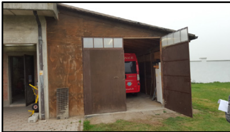
Struttura in legno da demolire
