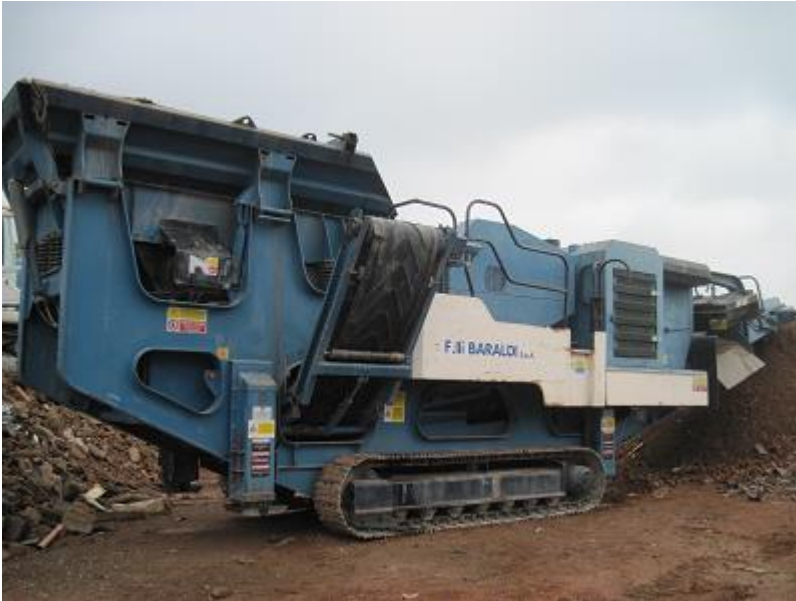
Foto 8.5 – L’impianto mobile all’arrivo in cantiere.
