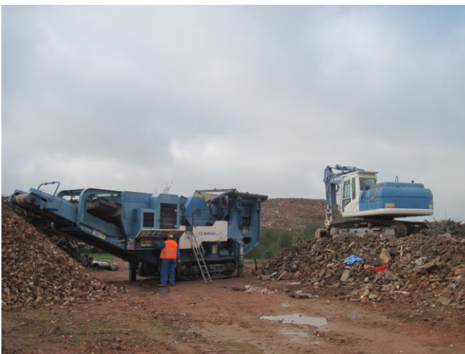
Foto 8.6 – L’impianto mobile in funzione
