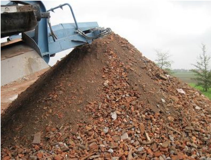
Foto 8.9 – Scarico del materiale misto
