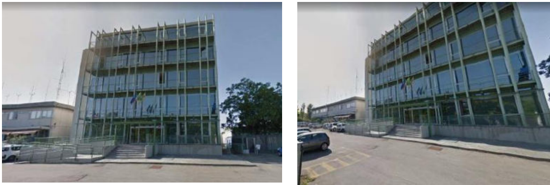
Figura 4-8 Edificio sede della DI.COMA.C.
