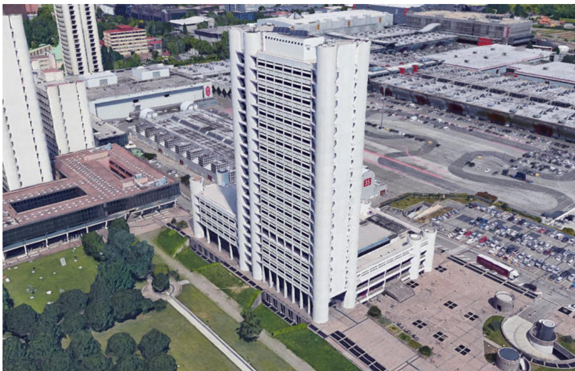
Figura 4-11 Edificio sede della DI.COMA.C.
