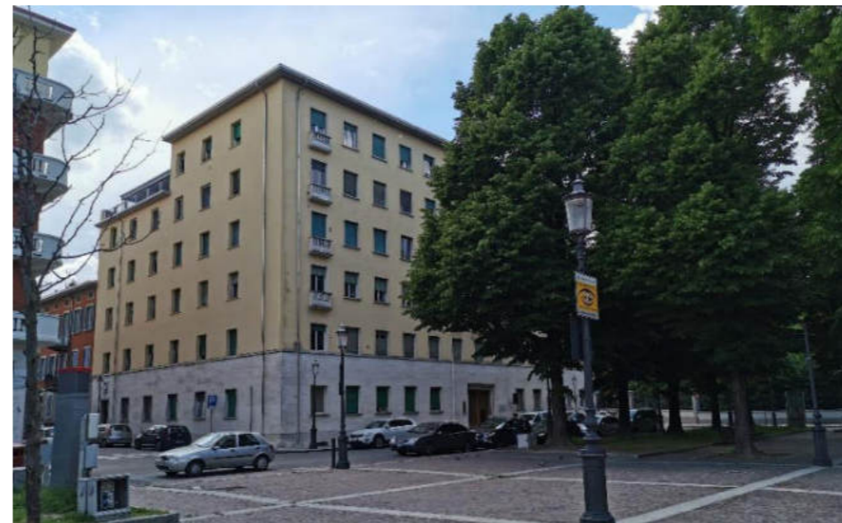
Figura 1. Foto Fonte: Regione Emilia-Romagna sopralluogo 2021
