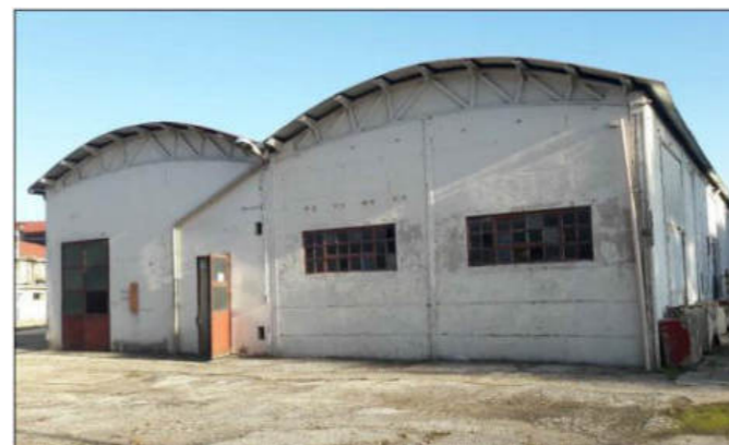
EDIFICIO 3: CELLE E SERVIZI. L'edificio è costituito da due elementi "in linea" di analoga forma, dimensione e tipologia, di un piano fuori terra. Presenta una struttura portante in cemento armato con travi e pilastri e tamponamenti laterali in pannelli prefabbricati in cls tinteggiati, e copertura voltata con manto di copertura in lamiera grecate e finitura superficiale in guaina ardesiata.
