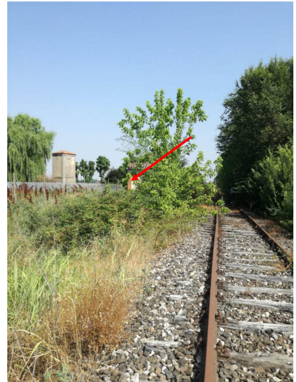
2 – Foto fabbricato collabente direzione Bondeno
