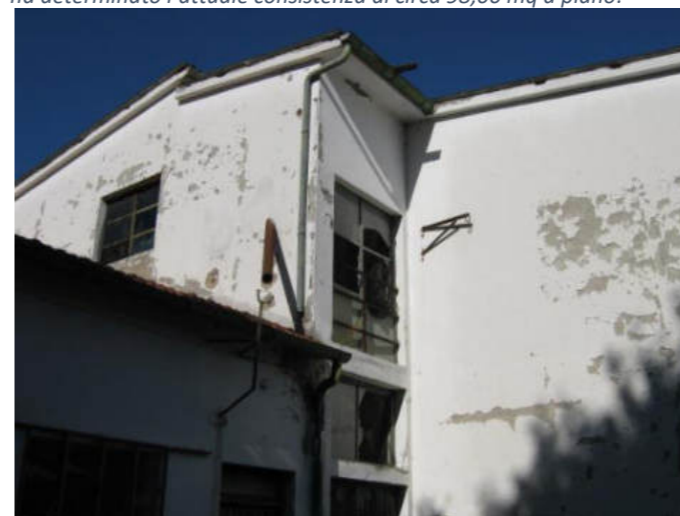
Figura 40. Fabbricato C - magazzini, locali allevamento, spogliatoi, servizi, mensa. Edificio in muratura di mattoni e solaio in laterocemento con manto di copertura in cotto, costituito da tre corpi di fabbrica per una superficie complessiva di circa 735,00 mq al piano terra, 560,00 mq al piano primo.
