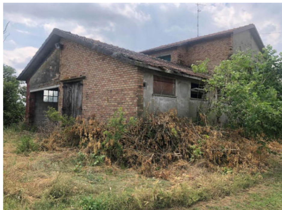
Figura 1. Foto Fonte: Regione Emilia-Romagna – sopralluogo 2022
