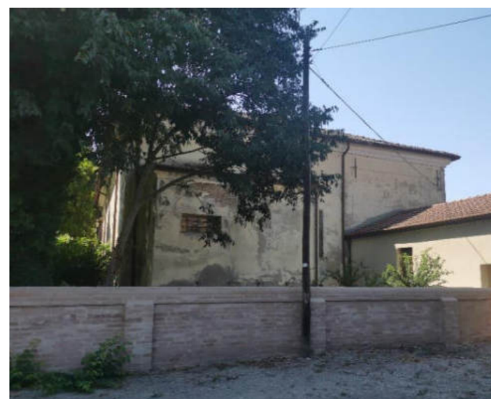
Figura 34. Foto Fonte: Regione Emilia-Romagna sopralluogo 2022
