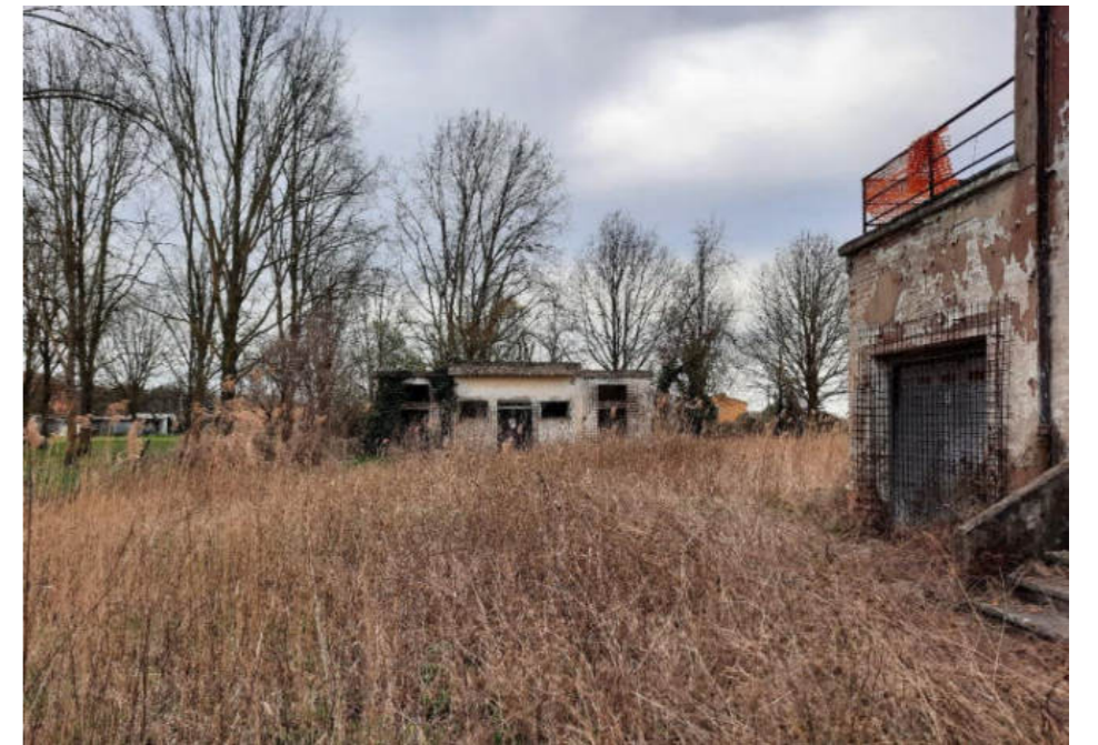
Figura 16. Foto Fonte: Regione Emilia-Romagna - sopralluogo 2022
