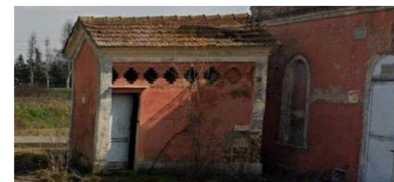
6 - Servizi Igienici Ex F.V. Vecchia Stazione di Bondeno Foglio 128 - Mappale 175
