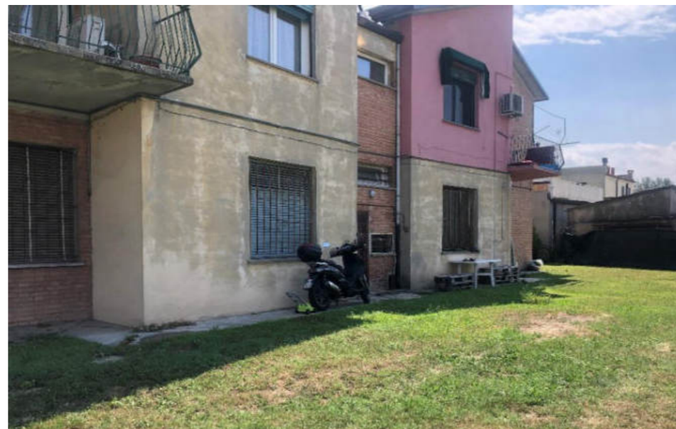
Figura 13. Foto Fonte: Regione Emilia-Romagna - sopralluogo 2022
