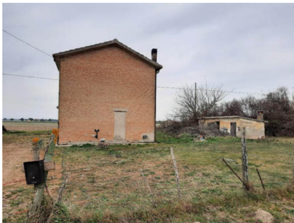
Figura 9. Foto Fonte: Regione Emilia-Romagna – sopralluogo 2022
