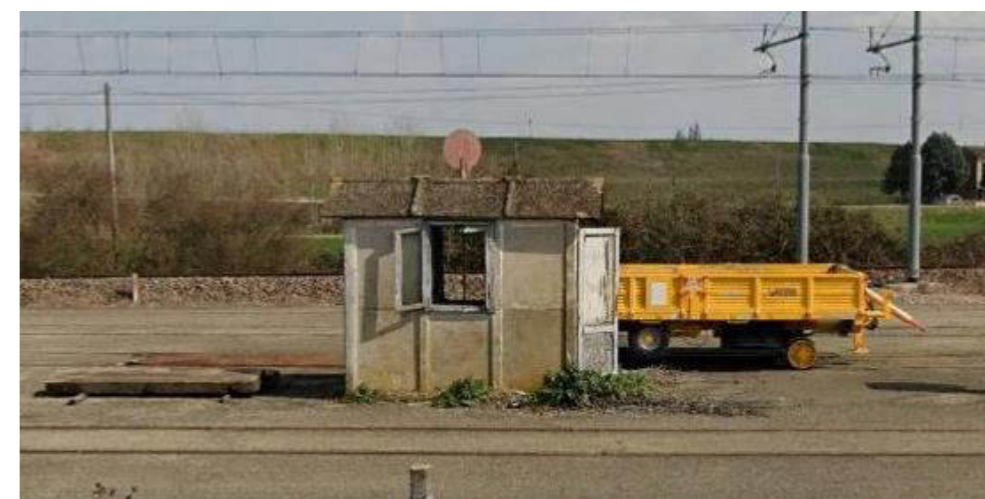
4 - Lato Ferrara vista Guardiola AREA SCALO Ferroviario Foglio 127 - Mappale 781
