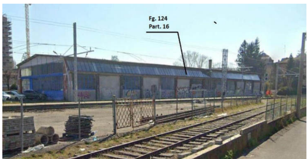
5 - Inquadramento capannone Industriale foglio 124, part. 16
