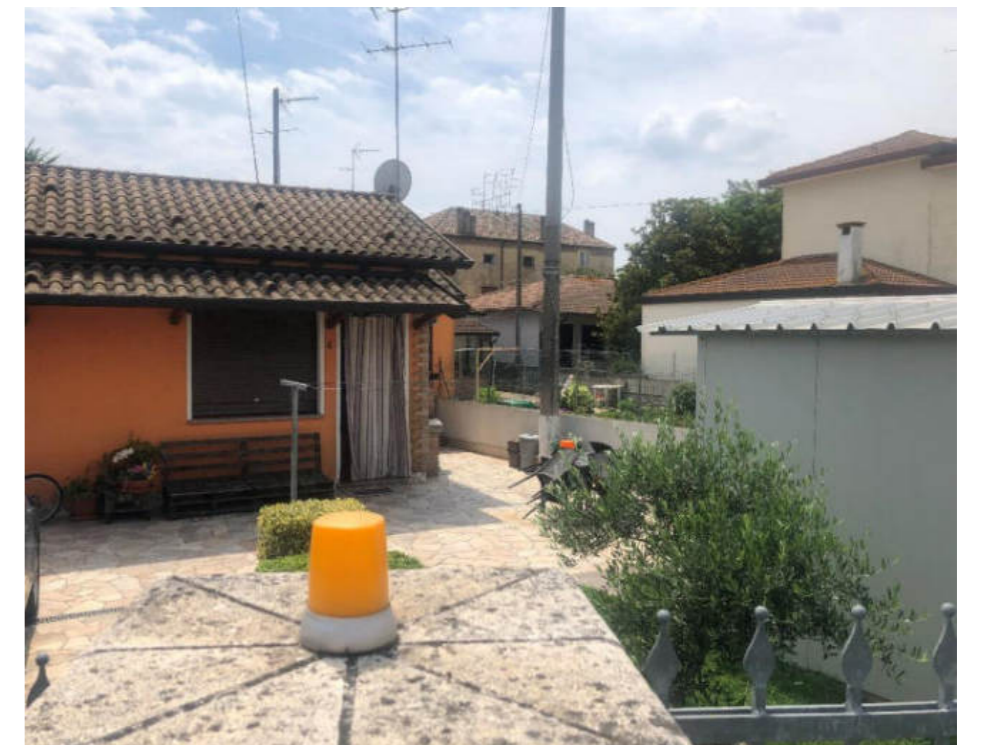
Figura 23. Foto fonte: Regione Emilia-Romagna – sopralluogo 2022
