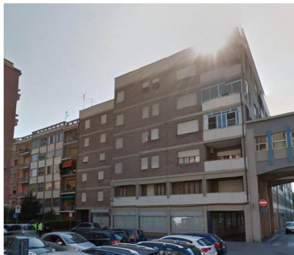
Figura 19-Vista frontale del complesso immobiliare
