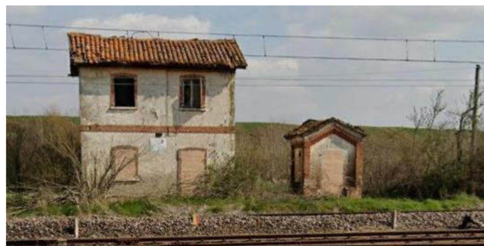
3 - Lato Suzzara vista Casa Cantoniera Foglio 127 - Mappale 40
