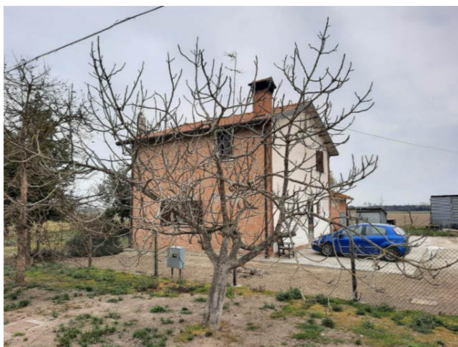
Figura 11 Foto Fonte: Regione Emilia-Romagna – Sopralluogo 2022
