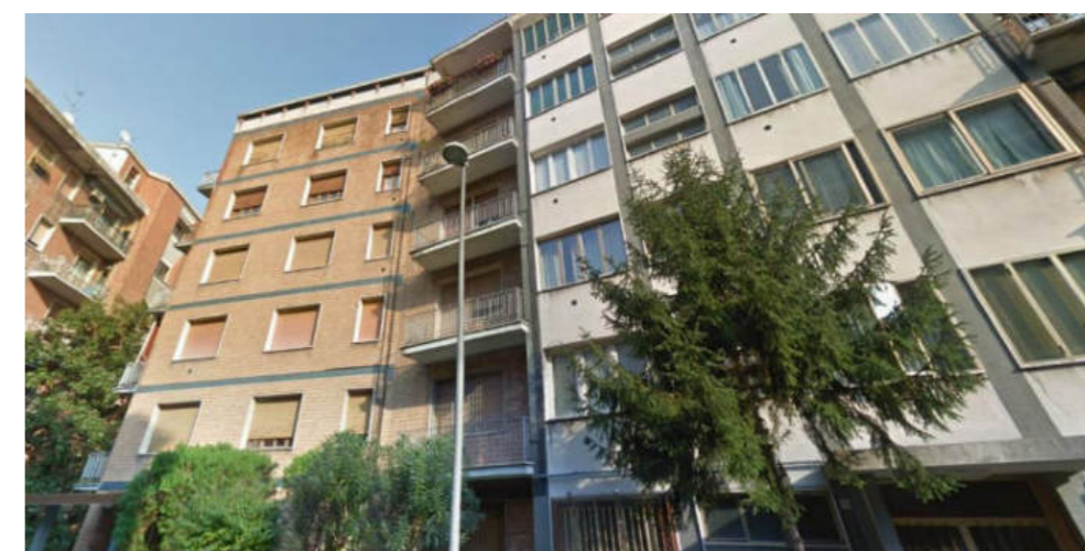
Figura 20-Vista frontale del complesso immobiliare
