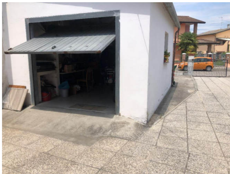
Figura 18. Foto fonte: Regione Emilia-Romagna – sopralluogo 2022
