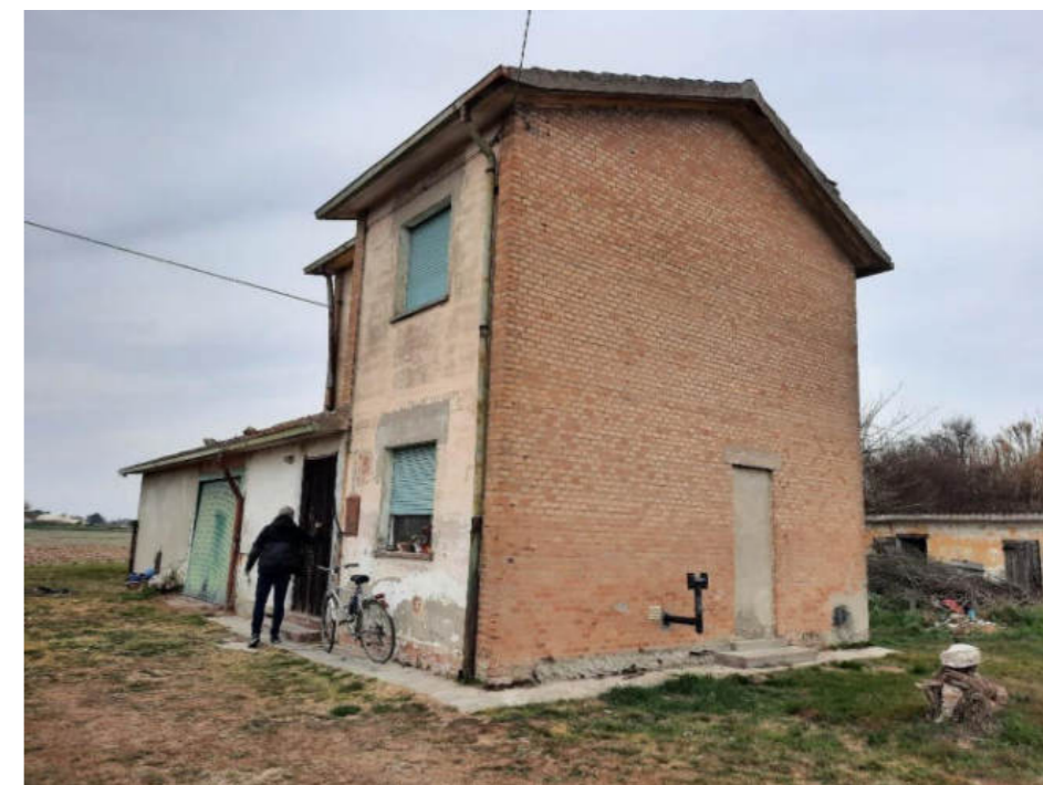
Figura 10. Foto Fonte: Regione Emilia-Romagna – sopralluogo 2022
