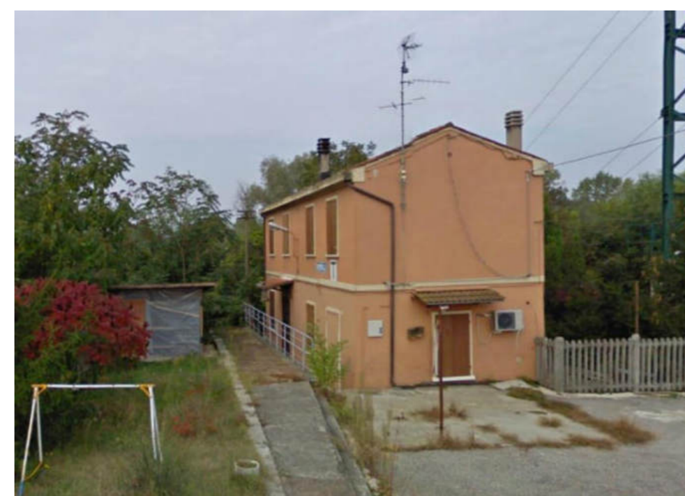
Figura 24 - Foto vista Casa cantoniera interno alla particella 17 del foglio 130
