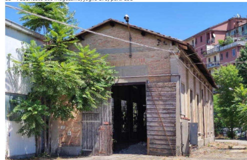
14 – Fabbricato ex lavaggio, foglio 175, part. 197 – Altra Vista
