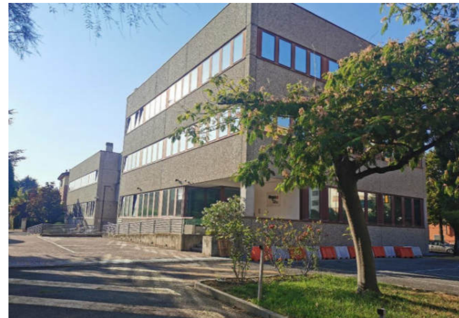
Figura 9. Foto Fonte: Regione Emilia-Romagna sopralluogo 2022
