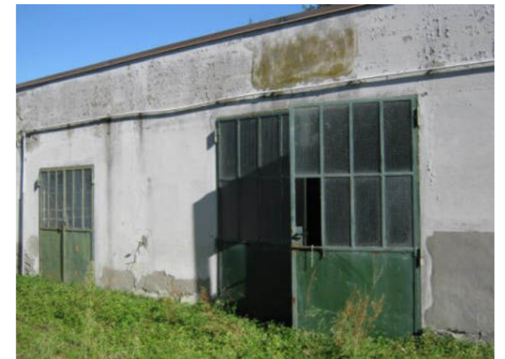
Figura 42. Fabbricato B - cantina e ricovero attrezzi. Piccolo edificio costruito in muratura di mattoni con copertura piana in laterocemento, della superficie lorda complessiva di circa 75,00 mq, disposta sul solo piano terra e suddivisa in due locali.
