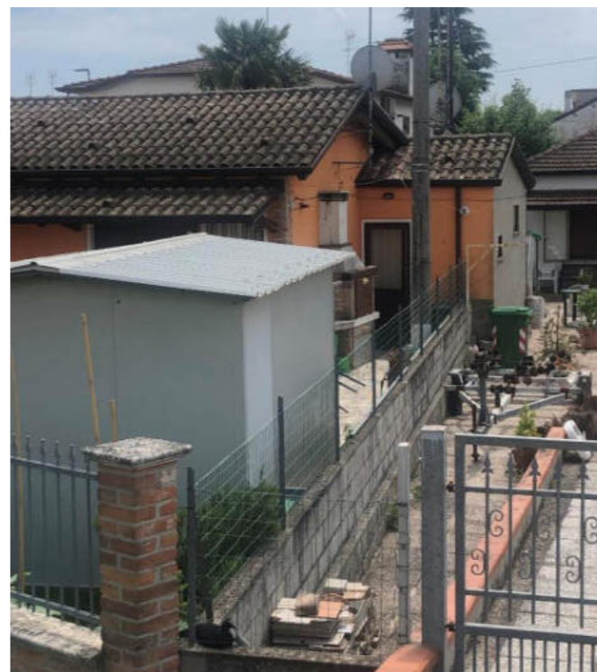
Figura 22. Foto fonte: Regione Emilia-Romagna – sopralluogo 2022
