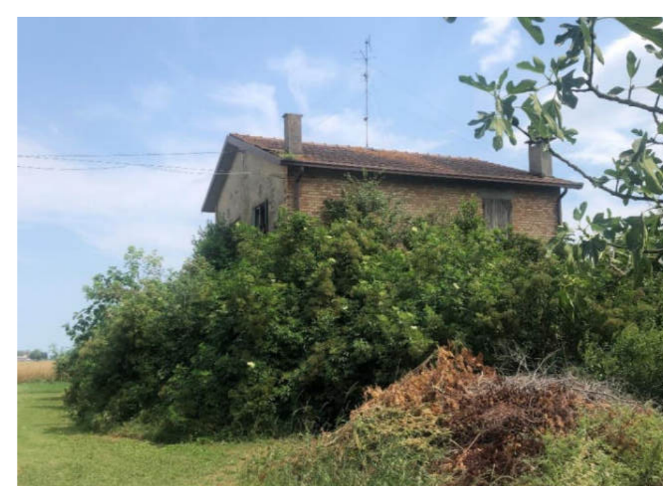
Figura 2. Foto Fonte: Regione Emilia-Romagna – sopralluogo 2022
