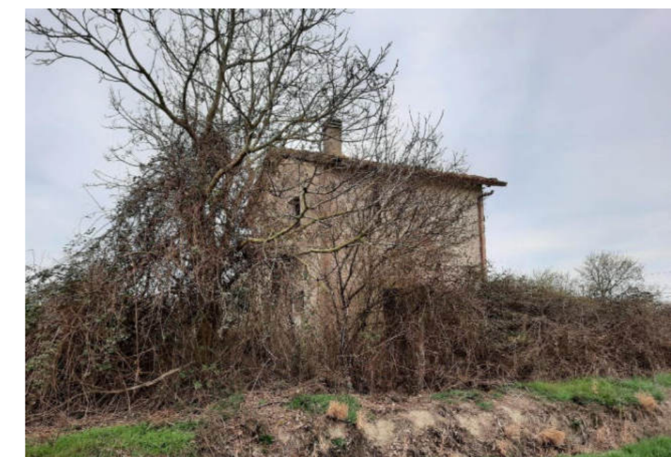
Figura 17. Foto Fonte: Regione Emilia-Romagna – Sopralluogo 2022
