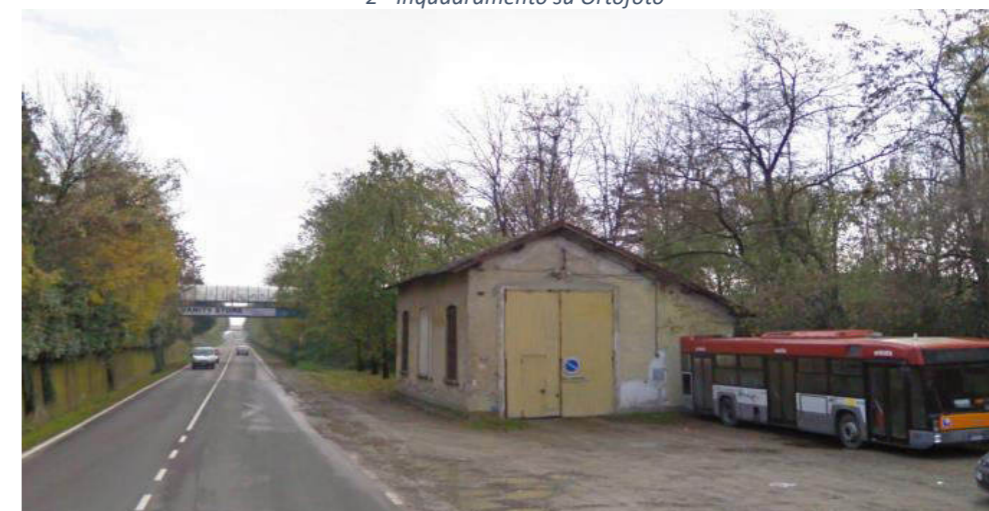
4 - Inquadramento ex deposito locomotori, foglio 19, particella 412
