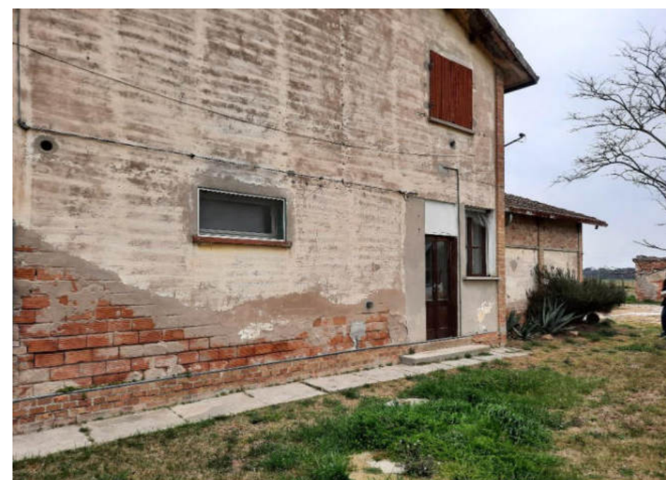
Figura 14. Foto Fonte: Regione Emilia-Romagna – Sopralluogo 2022
