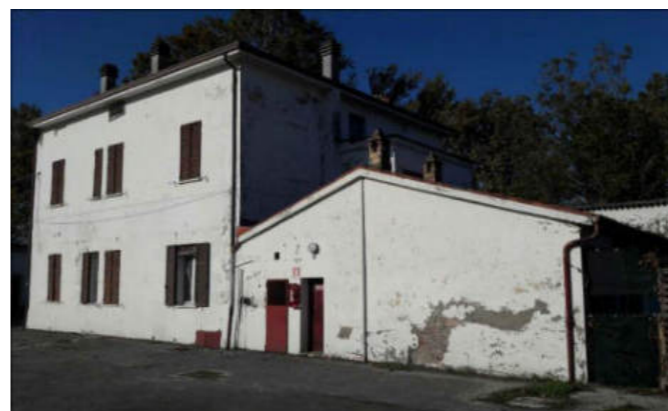
EDIFICIO 5: CASA CUSTODE. L'edificio è una casa colonica in muratura intonacata e tinteggiata, costituita da due piani fuori terra e un piano sottotetto, oltre a un magazzino di un piano fuori terra. Gli infissi esterni sono con telai in legno. La copertura, a padiglione nella porzione adibita ad abitazione e a due falde nella porzione adibita a servizi, presenta una struttura portante con orditura lignea ed uno strato superiore di finitura in laterizio.
