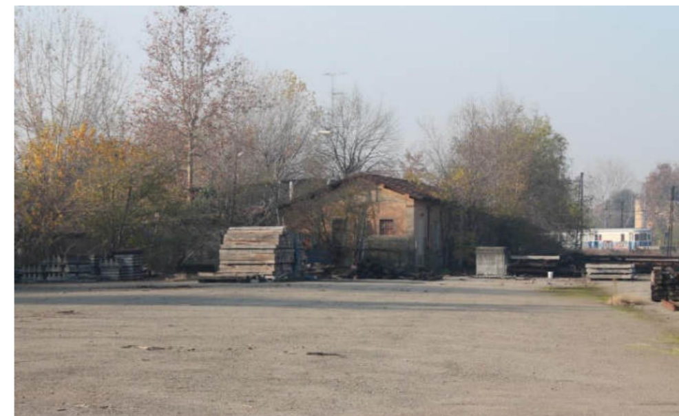
8 – Fabbricato ex circolo ferroviario, foglio 175, part. 204
