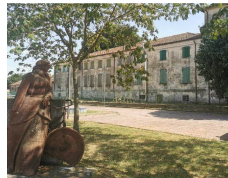
Figura 35. Foto Fonte: Regione Emilia-Romagna sopralluogo 2022
