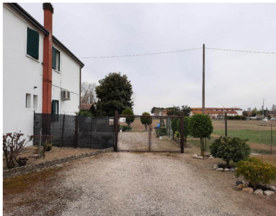
Figura 7. Foto Fonte: Regione Emilia-Romagna – sopralluogo 2022
