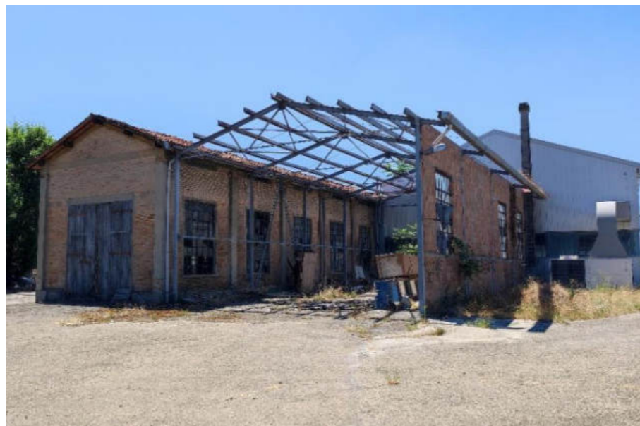
14 – Fabbricato ex lavaggio, foglio 175, part. 197
