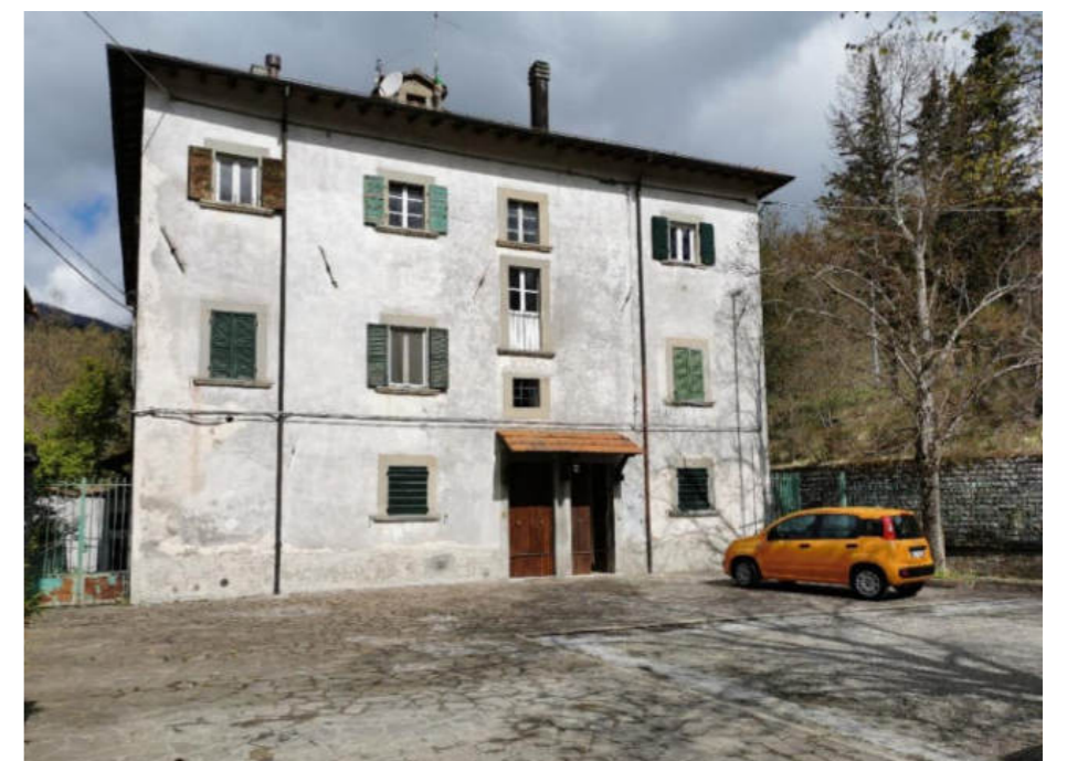
Figura 12. Foto Fonte: Regione Emilia-Romagna sopralluogo 2021
