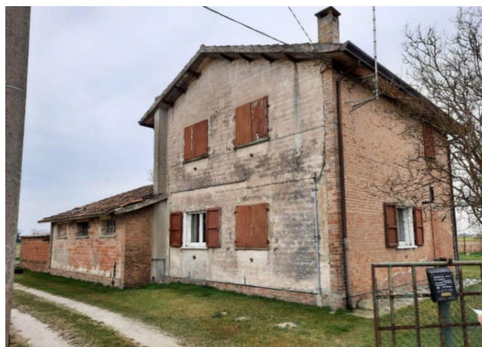
Figura 13. Foto Fonte: Regione Emilia-Romagna – Sopralluogo 2022
