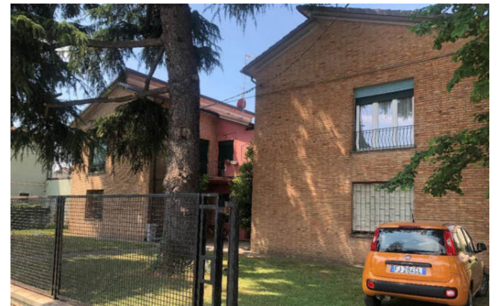
Figura 14. Foto Fonte: Regione Emilia-Romagna - sopralluogo 2022
