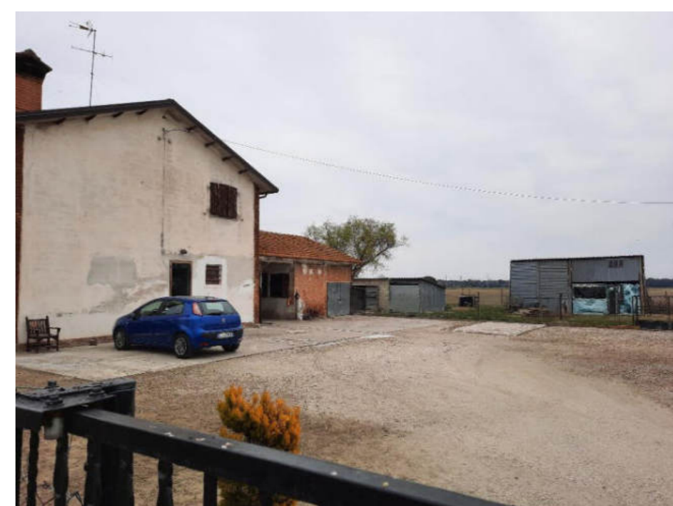
Figura 12 Foto Fonte: Regione Emilia-Romagna – Sopralluogo 2022
