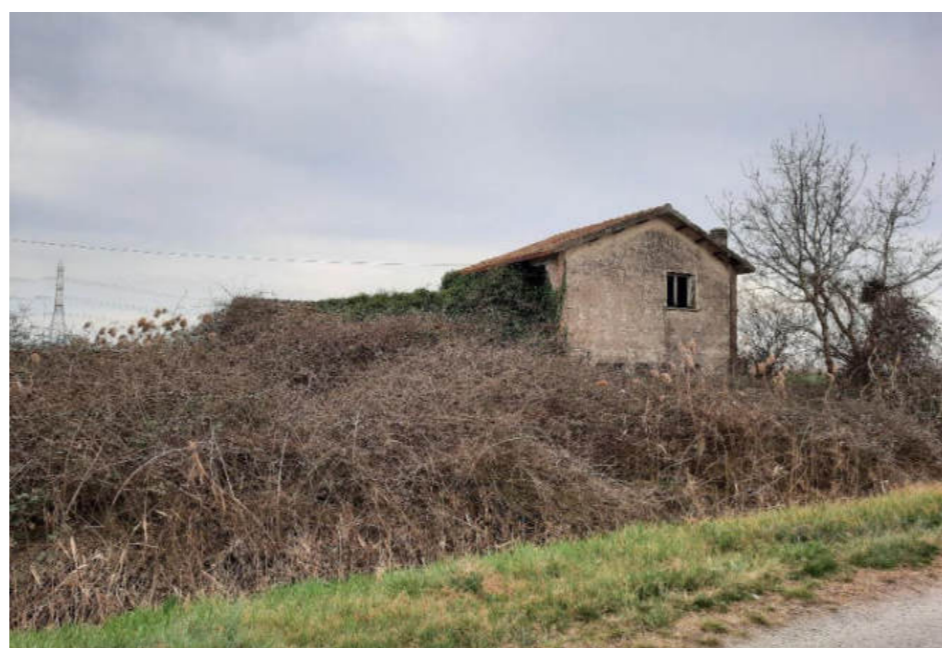
Figura 16. Foto Fonte: Regione Emilia-Romagna – Sopralluogo 2022
