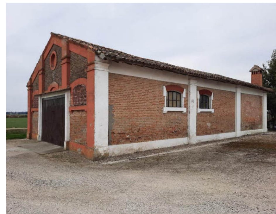
Figura 8. Foto Fonte: Regione Emilia-Romagna – sopralluogo 2022
