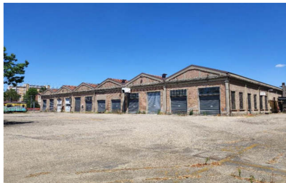
11 – Officina riparazione rotabili, foglio 175, part. 200
