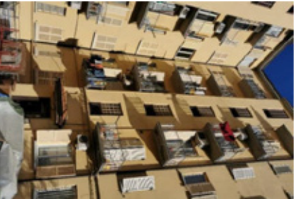
Figura 3. Foto Fonte: Regione Emilia-Romagna sopralluogo 2022
