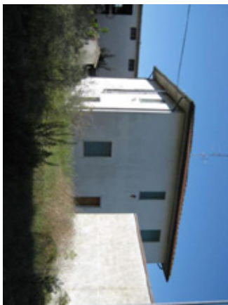
Figura 39. Fabbricato A - palazzina uffici e abitazione del custode. Edificio in muratura e cemento armato originariamente costruito dal solo piano terra, poi oggetto di un intervento di sopraelevazione che ne ha determinato l'attuale consistenza di circa 38,00 mq a piano.
