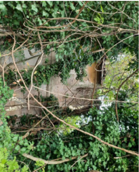
3 - Inquadramento casa cantoniera ex tratt. Ferrovia Bagnolo – Carpi
