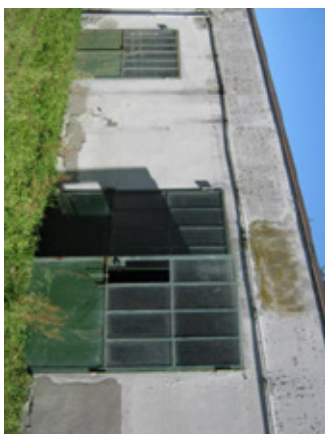
Figura 42. Fabbricato B - cucina e ricovero attrezzi. Piccolo edificio costruito in muratura di mattoni con copertura piena in laterocemento, della superficie lorda complessiva di circa 75,00 mq, disposta sul solo piano terra e suddivisa in due locali.
