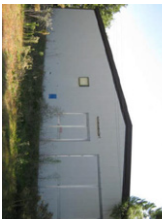
Figura 42. Fabbricato B - cucina e ricovero attrezzi. Piccolo edificio costruito in muratura di mattoni con copertura piena in laterocemento, della superficie lorda complessiva di circa 75,00 mq, disposta sul solo piano terra e suddivisa in due locali.
