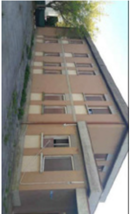
EDIFICIO 4: PALAZZINA UFFICI. L'edificio, di tipologia tradizionale a forma di C, è formato da due piani fuori terra. Presenta una struttura mista in muratura e cemento armato con tamponamenti laterali in laterizio intonacati e tinteggiati, e copertura piana con finitura superficiale in guaina ordessata.
