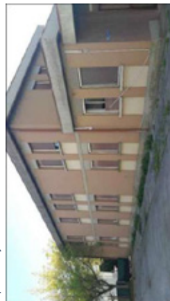
EDIFICIO 2: EX INCUBATORIO. Il complesso è una tipologia "in linea" con struttura mista in muratura e cemento armato con tamponamenti laterali in intonacati e tinteggiati; il tutto sormontato, nella porzione principale, da una copertura voltata con finitura superficiale in guaina ardesiata, mentre nella porzione di fabbricato ad ovest è presente una copertura a falde in laterizio.
