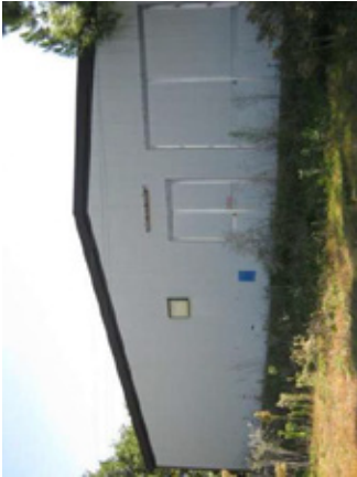
Figura 46. Fabbricato B - cantina e ricovero attrezzi. Piccolo edificio costruito in muratura di mattoni con copertura piana in laterocemento, della superficie lorda complessiva di circa 75,00 mq, disposto sul solo piano terra e suddiviso in due locali.
