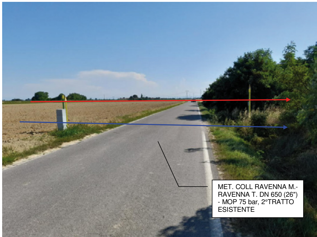
FOTO N.1 – Secondo attraversamento S.P. 99 senso gas
