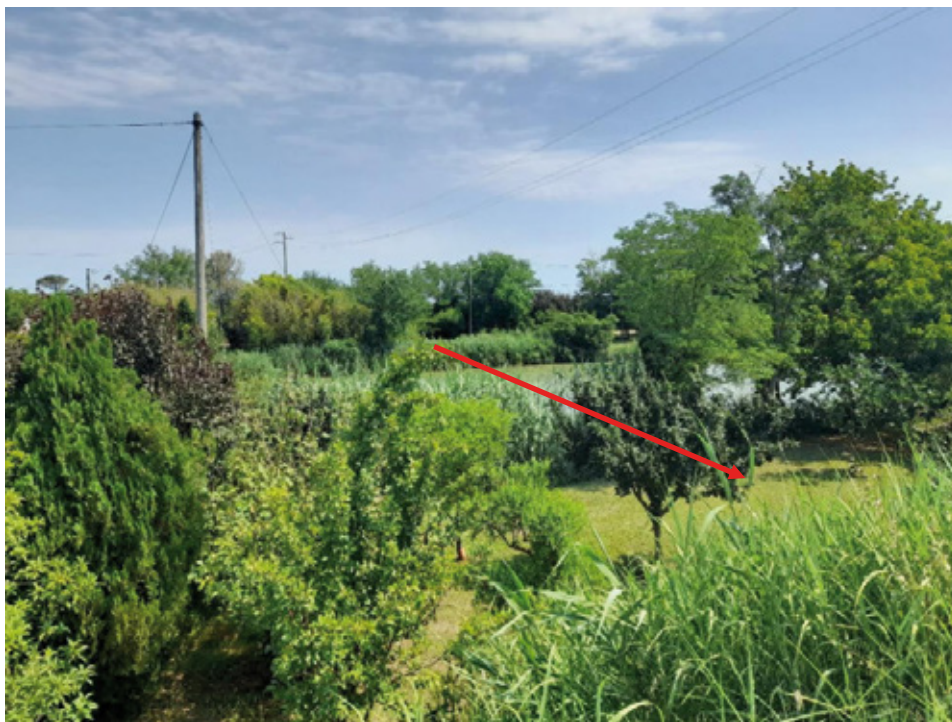
Figura 3.1: Panoramica della zona dell'attraversamento (in rosso l'andamento qualitativo della tubazione)
