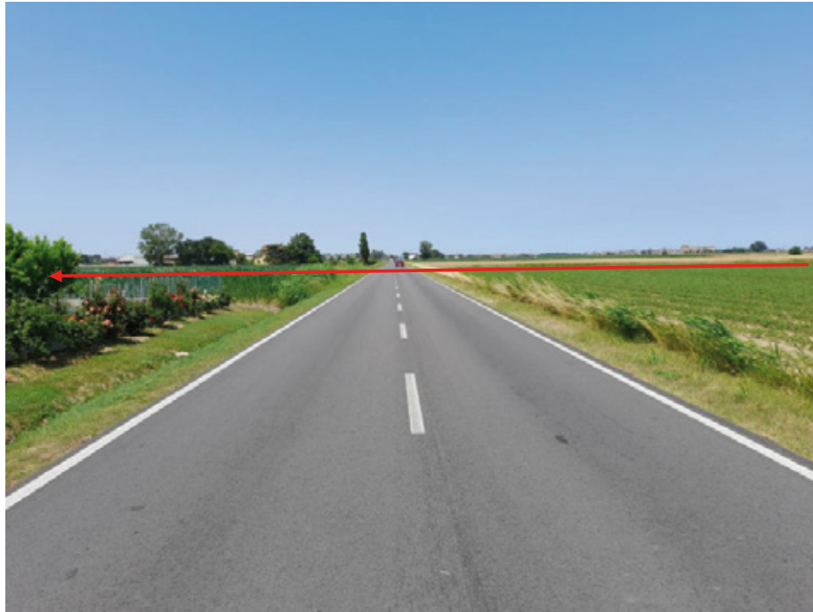
FOTO N.1 - Attraversamento S.P. 118 contro senso gas
