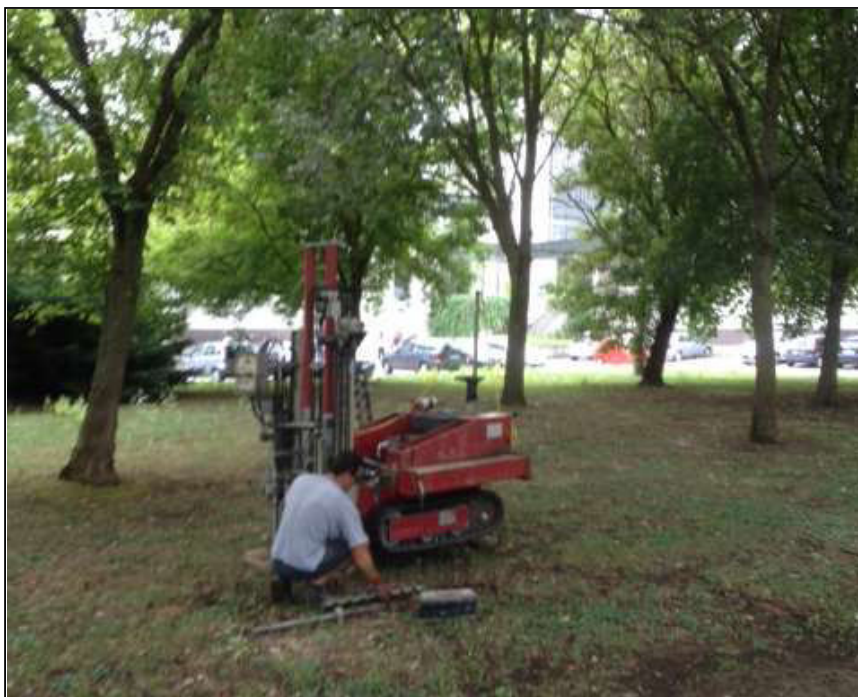
Figura 2.7-5 Esecuzione prova CPTU2
