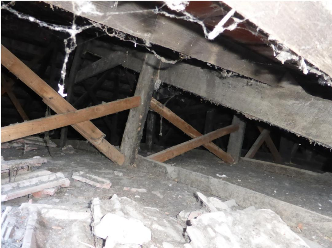
**Figura 30:** Copertura lignea, particolare delle tavole di irrigidimento in direzione longitudinale e trasversale.
