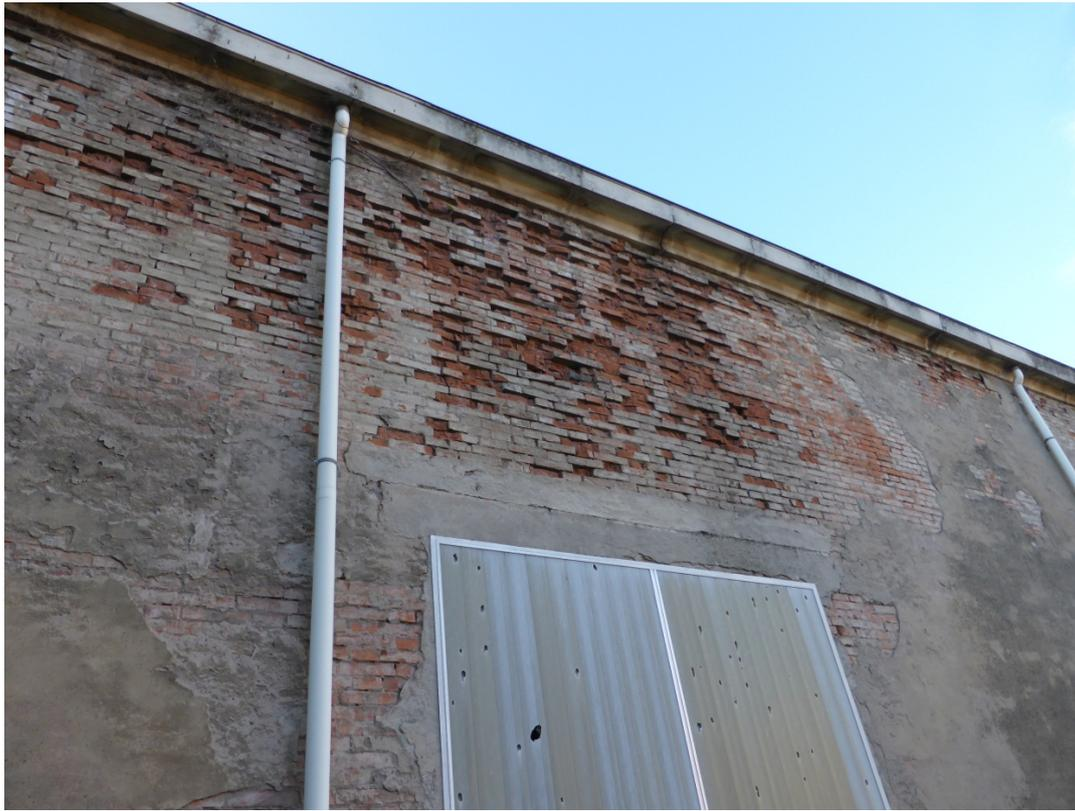
**Figura 21:** Degrado dei laterizi sul paramento murario esterno, lato corte.
