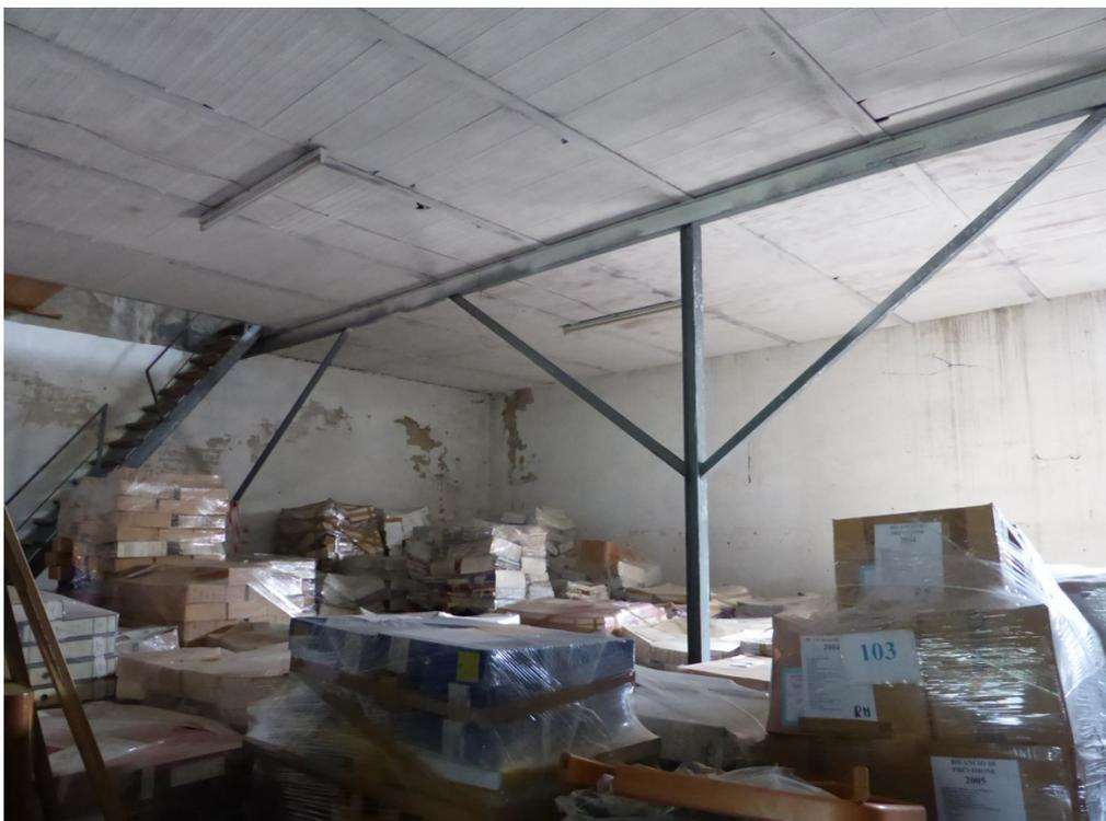
**Figura 31:** Corpo nord-ovest, solaio intermedio in putrelle HEA100 e tavelloni, sostenuto da telai interni in profilati metallici, poco efficienti ai fini sismici.
