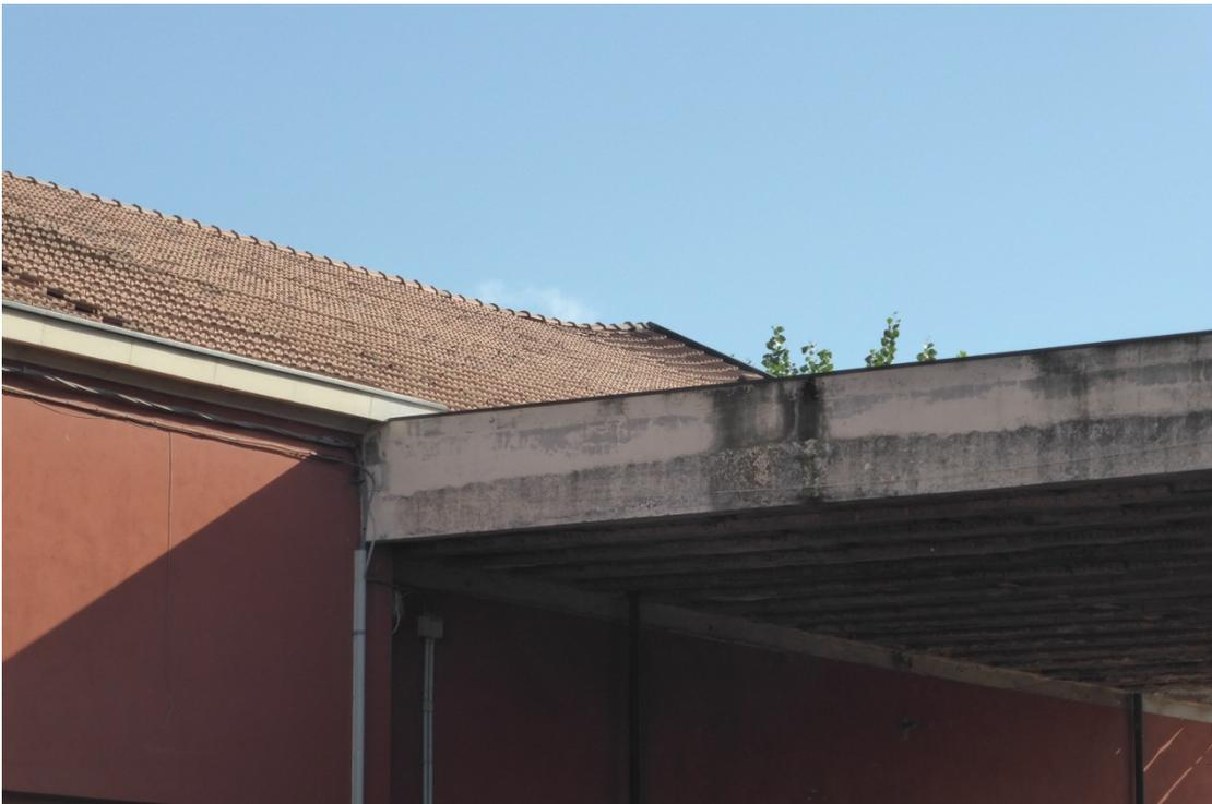
**Figura 27:** Avvallamenti nel manto di copertura.
