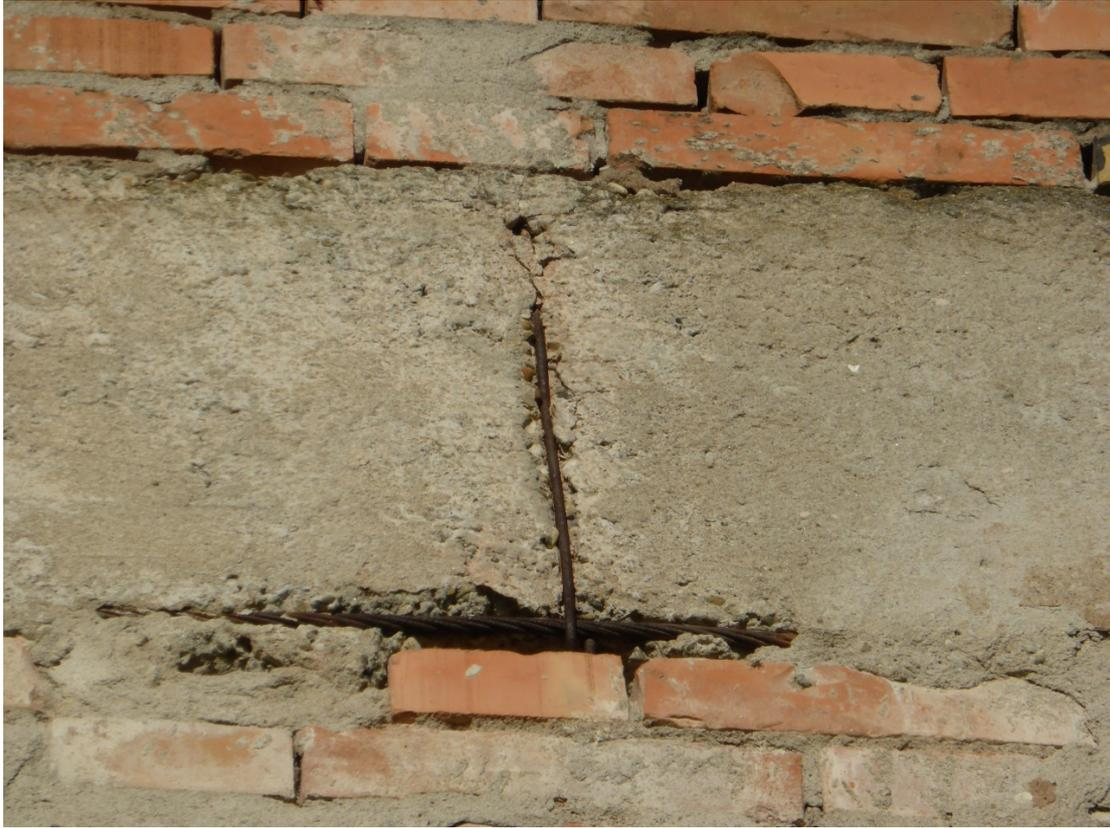
**Figura 17:** Particolare di degrado del copriferro sul cordolo del fronte est.
