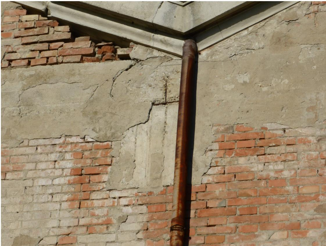
**Figura 18:** Dettaglio dell'innesto della trave del telaio in c.a. interno nella muratura perimetrale.
