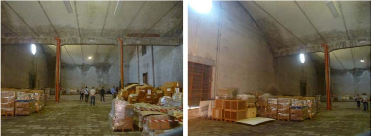
**Figura 4:** Sala Schellenberg, vista dall'interno con catene a contrasto della spinta dei solai voltati.
