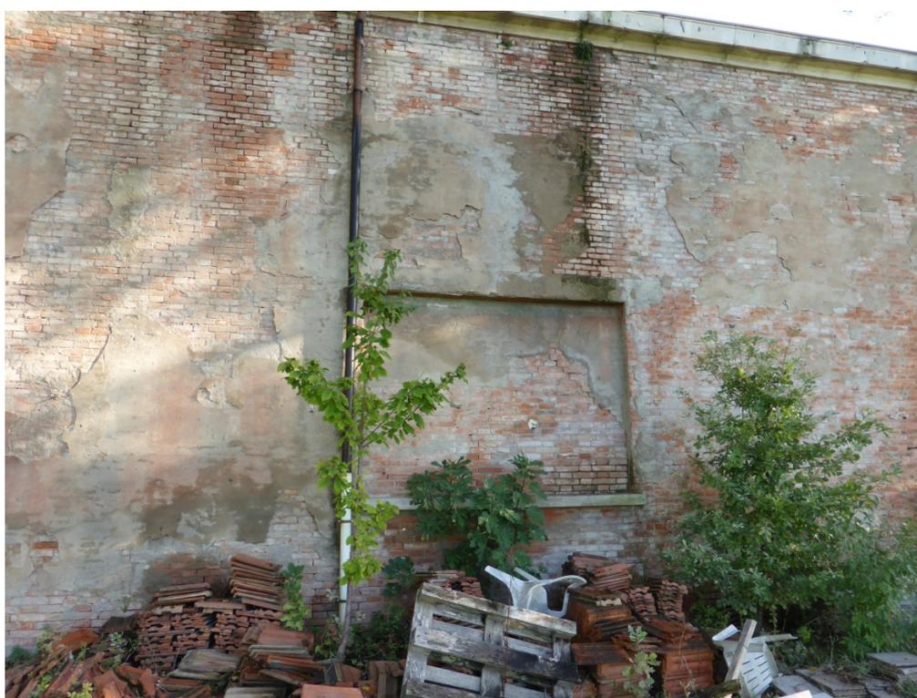
**Figura 14:** Fessurazioni murarie verticali e sintomi di degrado delle murature sul fronte sud.
