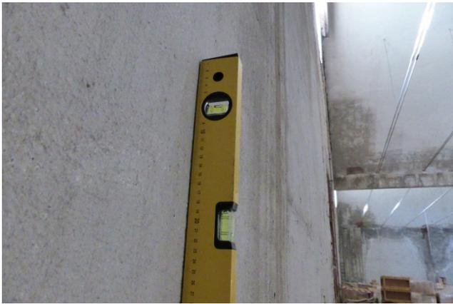
**Figura 26:** Distacchi fra le volte interne in latero-cemento e le pareti perimetrali esterne, con leggerissimo fuori piombo delle stesse verso l'esterno.
