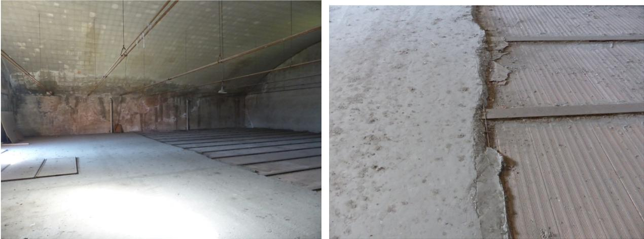
**Figura 32:** Solaio intermedio del corpo di nord-ovest, si nota la presenza di una cappa in c.a. con rete elettrosaldata soltanto su metà della superficie dell’impalcato.
