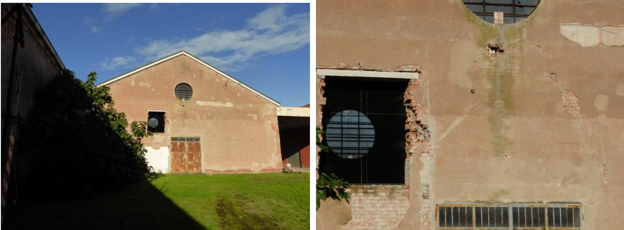
**Figura 22:** Prospetto sulla corte interna della porzione di nord-ovest, con indebolimento della muratura indotto da un'apertura in posizione sfavorevole, che (dettaglio a destra) ha agevolato la formazione di fessurazioni in corrispondenza della fascia di piano.
