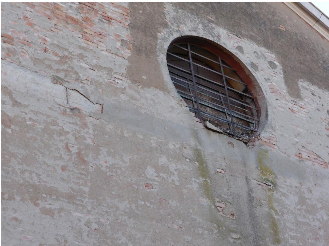
**Figura 20:** Degrado su un rosone che affaccia sul cortile interno.
