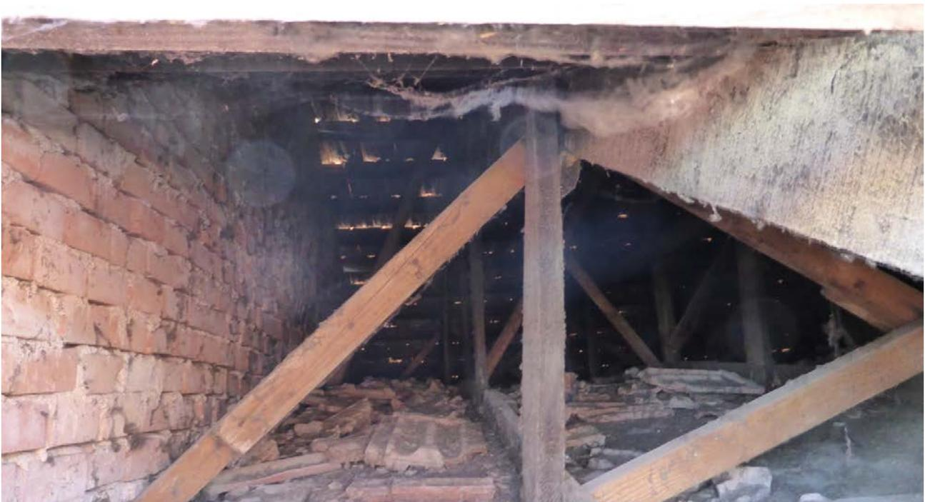
**Figura 29:** Intercapedine fra il solaio voltato e la copertura in legno, si nota la precarietà della struttura lignea che sostiene il manto in tegole marsigliesi.
