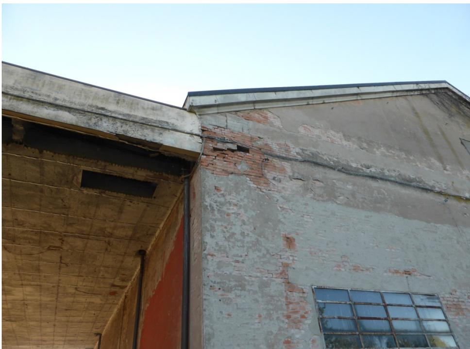
**Figura 10:** Dettaglio delle lesioni ai cantonali lato nord presumibilmente indotte dai lavori di demolizione.
