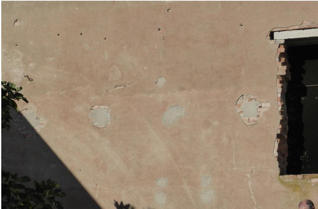
**Figura 28:** Porzione di nord-ovest, tracce indicanti gli innesti delle travi metalliche del solaio intermedio posticcio.
