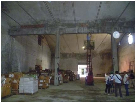
Calcestruzzi ammalorati causa percolazione e infiltrazione acqua
