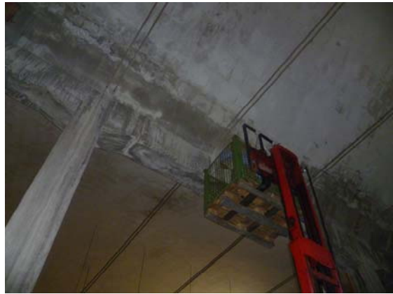
Calcestruzzi ammalorati causa percolazione e infiltrazione acqua
