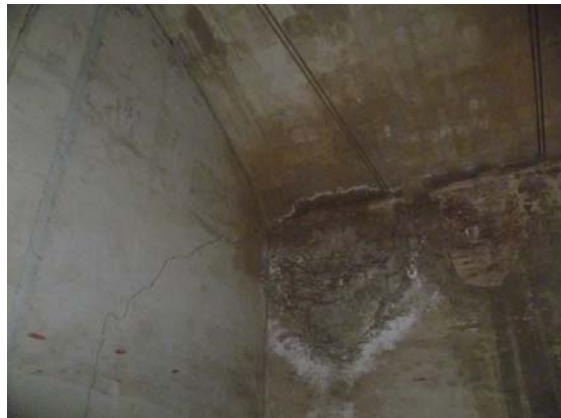
Lesione diagonale nella parete interna parallela alla volta
