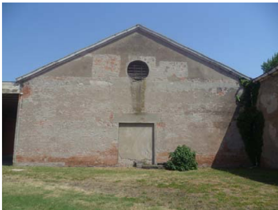
Mancanza e distacco di intonaco nelle facciate
