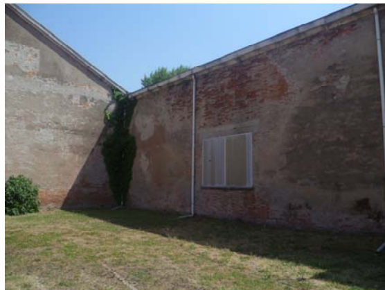
Mancanza e distacco di intonaco nelle facciate
