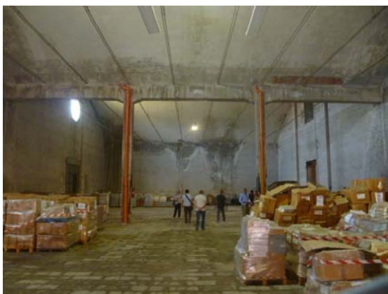
Calcestruzzi ammalorati causa percolazione e infiltrazione acqua
