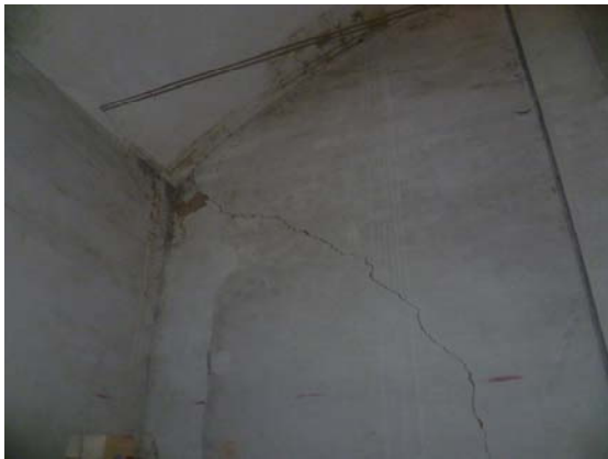
Lesione diagonale nella parete interna parallela alla volta
