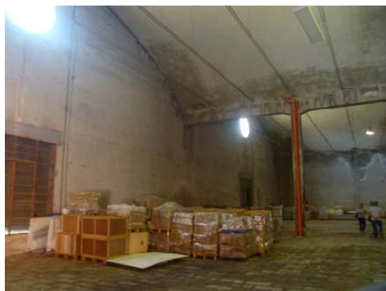
Calcestruzzi ammalorati causa percolazione e infiltrazione acqua
