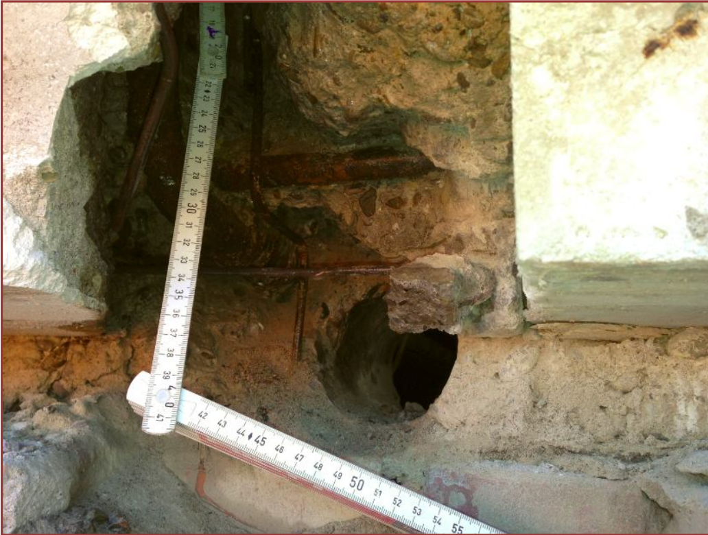
Foto 14: Prova su catena: indagine esterna misurazioni
