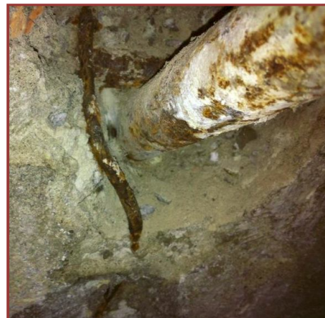
Foto 2: Prova su catena: ispezione dall'interno
