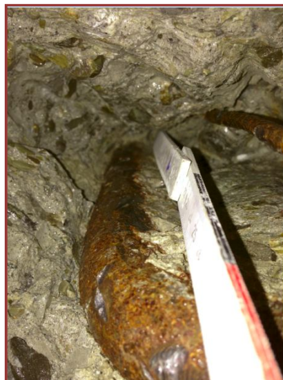
Foto 11-12-13: Prova su catena: indagine esterna misurazioni
