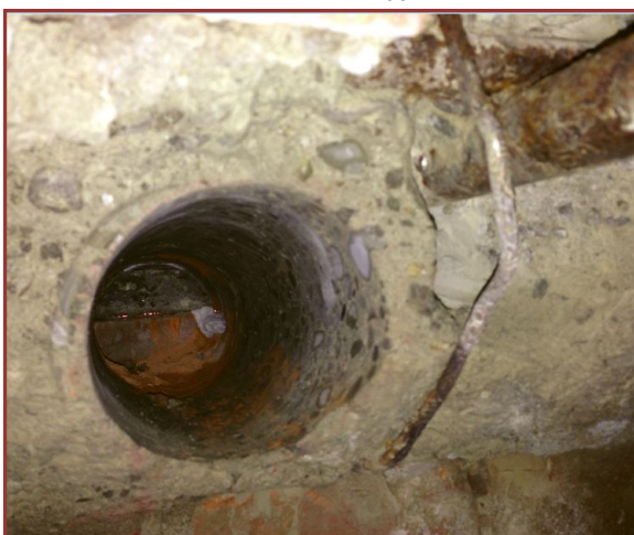
Foto 5: Prova su catena: foro carota diametro 10 cm
