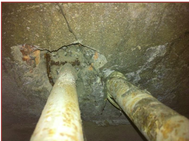
Foto 1: Prova su catena: ispezione dall'interno
