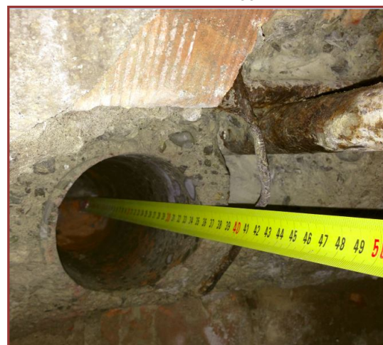
Foto 6: Prova su catena: foro carota diametro 10 cm
