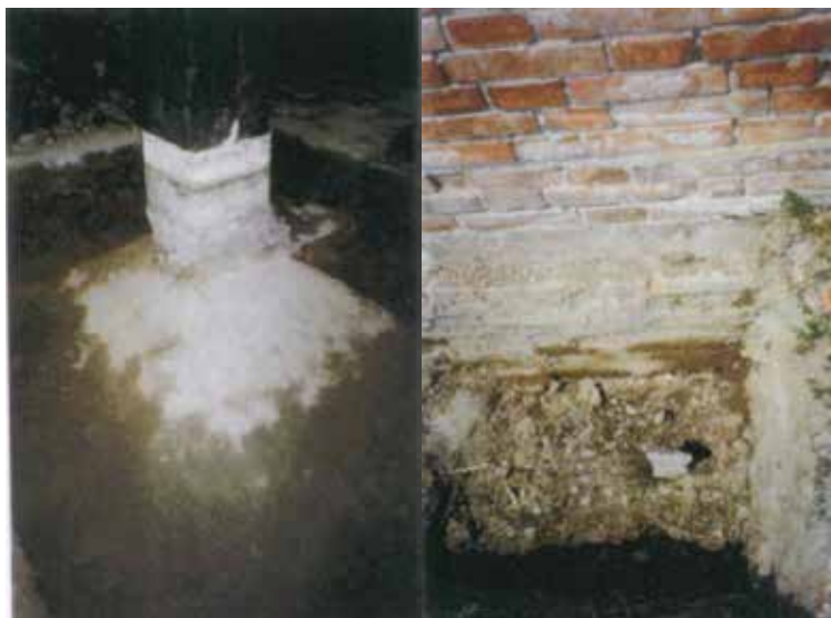
Figura 7: Saggi esplorativi sulle fondazioni dei pilastri interni in c.a. e delle murature esterne.
