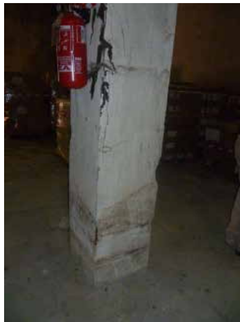
Mancanza di copriferro in alcuni punti dei pilastri in c.a.
