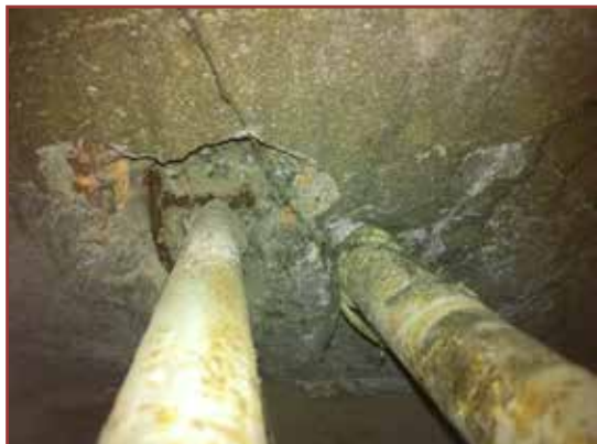
Foto 1: Prova su catena: ispezione dall'interno
