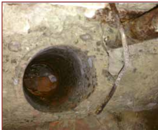
Foto 5: Prova su catena: foro carota diametro 10 cm
