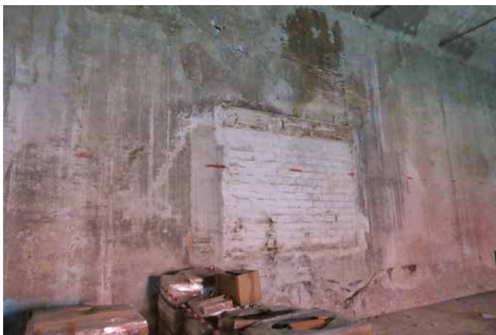
Figura 24: Apertura tamponata sulla muratura esterna della sala Brenneke.
