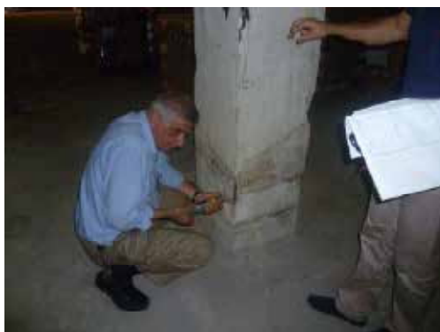
Mancanza di copriferro in alcuni punti dei pilastri in c.a.
