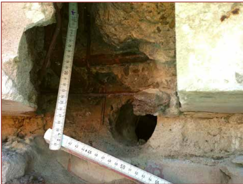
Foto 14: Prova su catena: indagine esterna misurazioni
