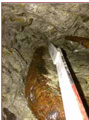
Foto 11-12-13: Prova su catena: indagine esterna misurazioni
