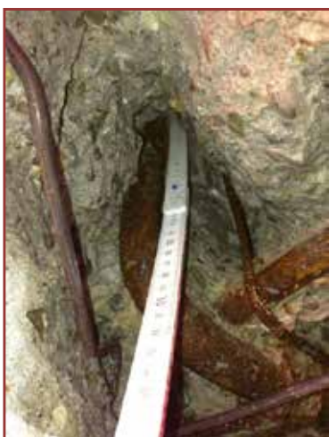
Foto 11-12-13: Prova su catena: indagine esterna misurazioni
