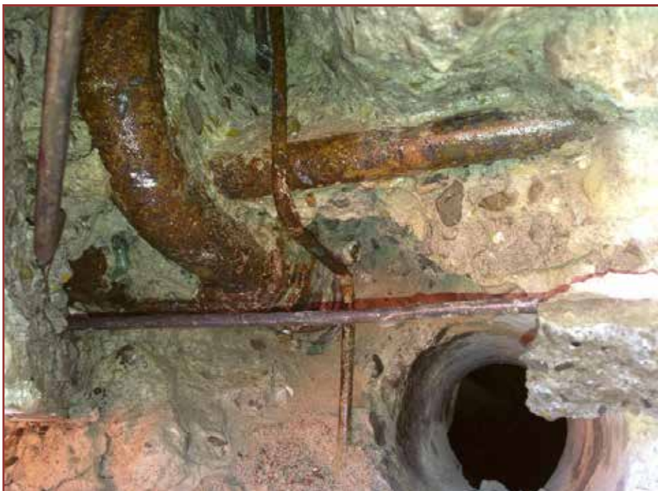
Foto 15: Prova su catena: indagine esterna
