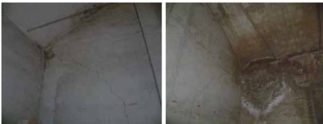
Figura 9: Vista ravvicinata delle lesioni diagonali sulle murature trasversali interne.
