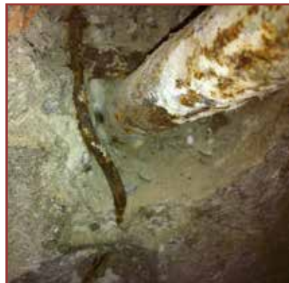
Foto 2: Prova su catena: ispezione dall'interno
