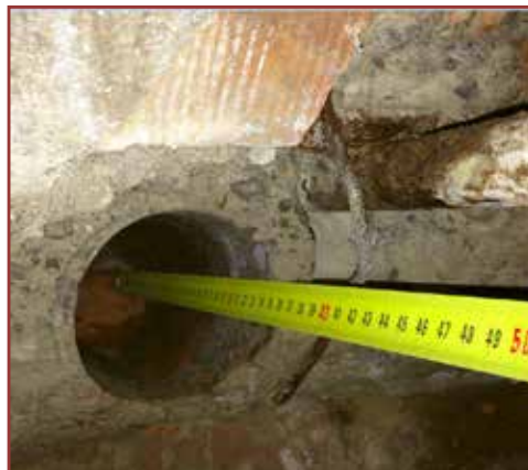
Foto 6: Prova su catena: foro carota diametro 10 cm
