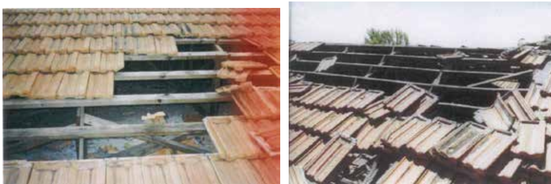
Figura 5: Particolari della copertura lignea sovrastante le volte in latero-cemento.
