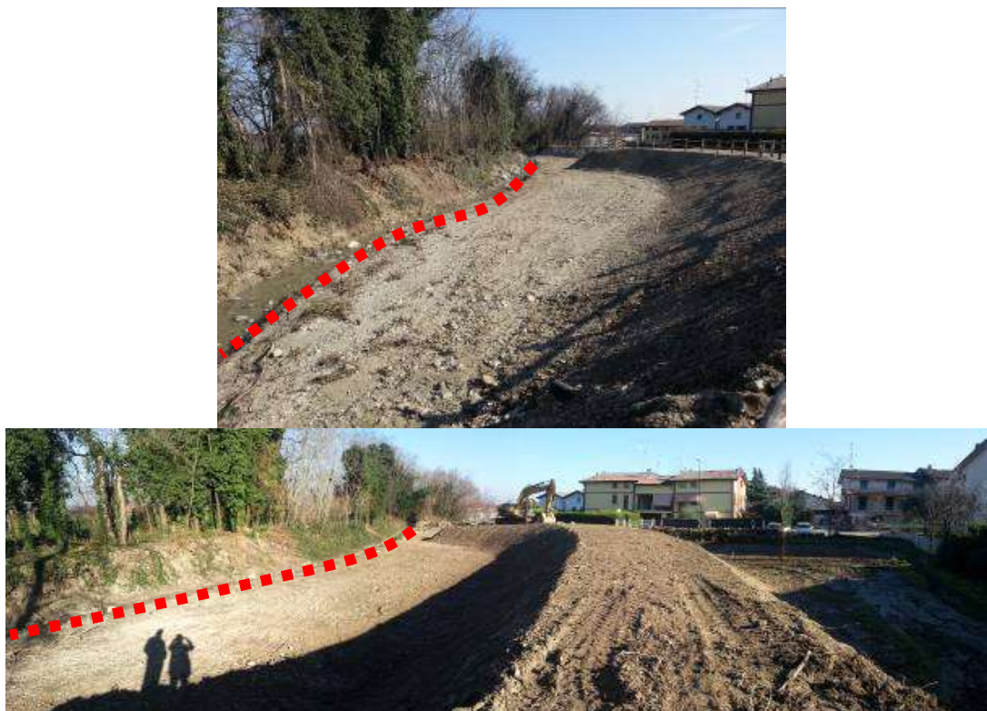
Figura 7 - Esempio di arretramento arginale lungo il rio Enzola (Provincia di Reggio Emilia).
