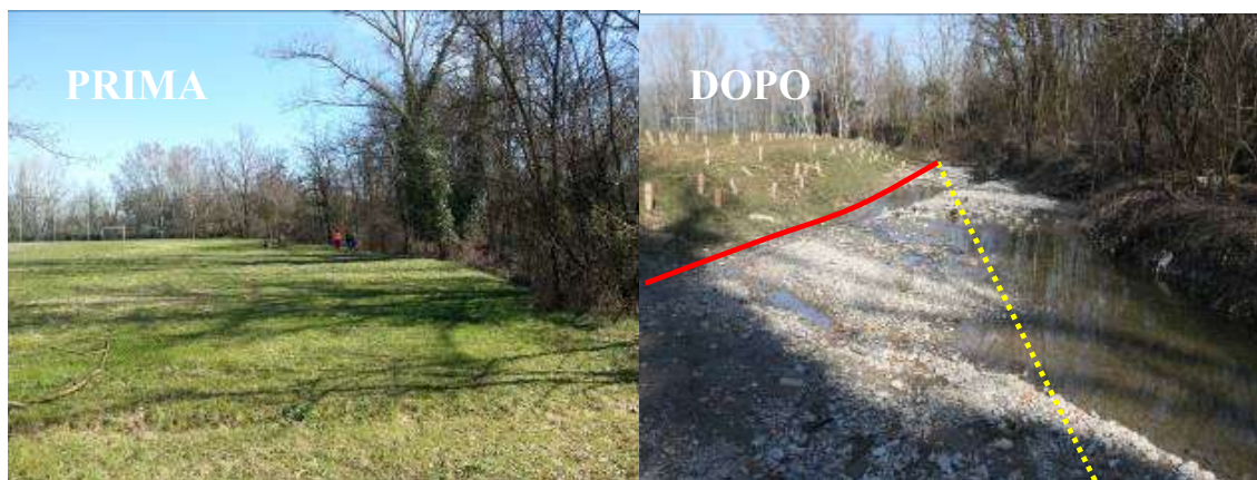
Figura 12 - Esempio di creazione di piana inondabile in un corso d'acqua non arginato mediante abbassamento del piano campagna (rio Lavezza, Comune di Albinea in Provincia di Reggio Emilia).
