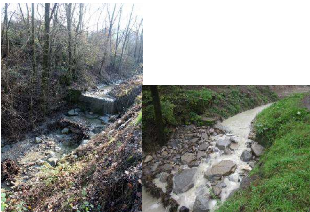
Figura 34 - Esempio di modifica di una briglia lungo il rio Enzola nel Comune di Quattro Castella (RE).
