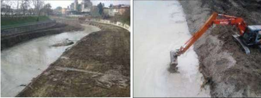
Figura 42 – Esempio di reimmissione di sedimenti lungo il fiume Montone (Forlì).
