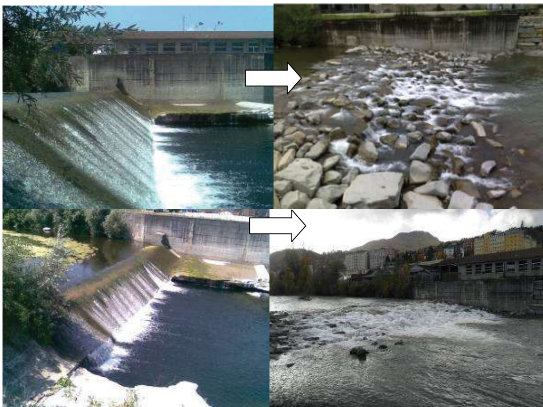
Figura 33 – Demolizione di una briglia in cemento armato e sostituzione con rampa in massi ciclopici nel tratto del fiume Reno che segna il confine tra il territorio comunale di Porretta Terme (BO) e Castel di Casio (BO).
