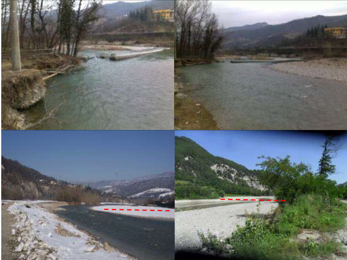
Figura 31 – Rimozione della briglia di Loriano sul torrente Setta (comuni di Marzabotto e Monzuno, provincia di Bologna).
