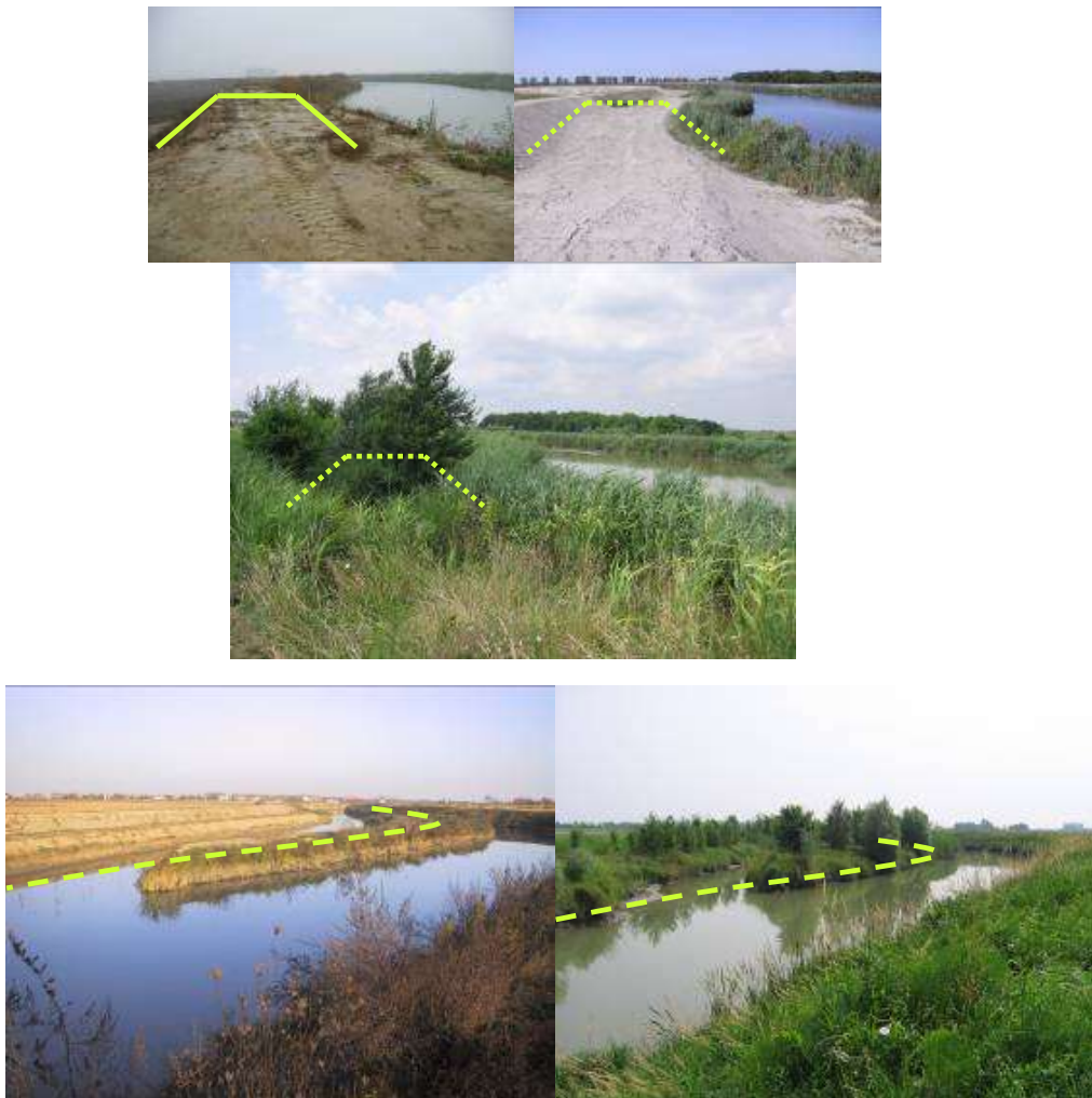
Figura 6 – Esempio di arretramento arginale sul fiume Zero (Provincia di Venezia). Il fiume Zero è un corso d’acqua di risorgiva di origine naturale, canalizzato già in epoca storica, oggi quasi irreversibilmente integrato nella rete idraulica della bonifica e considerato e gestito alla stregua dei canali di origine artificiale. Gli interventi di riqualificazione qui mostrati fanno parte di un più ampio piano di riqualificazione ambientale del Bacino Scolante nella Laguna di Venezia, il Piano Direttore 2000 (“Piano per la prevenzione dell’inquinamento ed il risanamento delle acque del bacino idrografico immediatamente sversante nella Laguna di Venezia” - L.139/1992), che trae origine dalla Legislazione Speciale per Venezia e mira alla salvaguardia fisica, ambientale e socio-economica della città e della sua Laguna. Già a partire dagli anni ‘90 è cominciata la realizzazione di interventi di riqualificazione dei canali e dei corsi d’acqua naturali sversanti in Laguna, al fine sia di contenere l’immissione in essa dei nutrienti presenti nelle acque, sia di diminuire il rischio da esondazione che insiste sul territorio attraversato. Il progetto “Interventi di riqualificazione ambientale lungo il basso corso del fiume Zero per il controllo e la riduzione dei nutrienti sversati nella Laguna di Venezia” ha previsto un aumento dei volumi di invaso attraverso appositi ampliamenti di sezione, ottenuti mediante arretramento degli argini e creazione di aree golenali. Nelle prime tre foto in alto è indicato in giallo l’argine prima della
