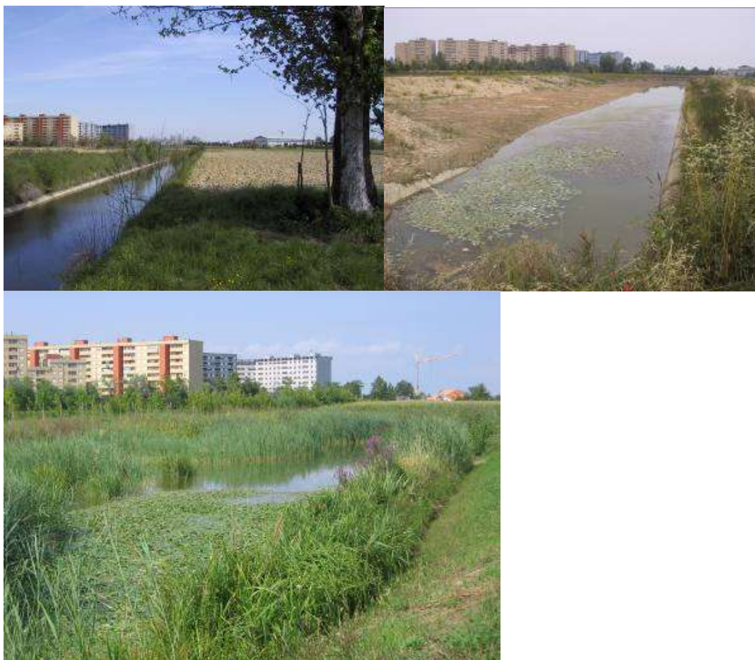
Figura 23 – Intervento di rimozione di difese spondali lungo la Fossa Pagana, corso d’acqua naturale gestito dal Consorzio di bonifica Acque Risorgive (Mestre - Venezia).
