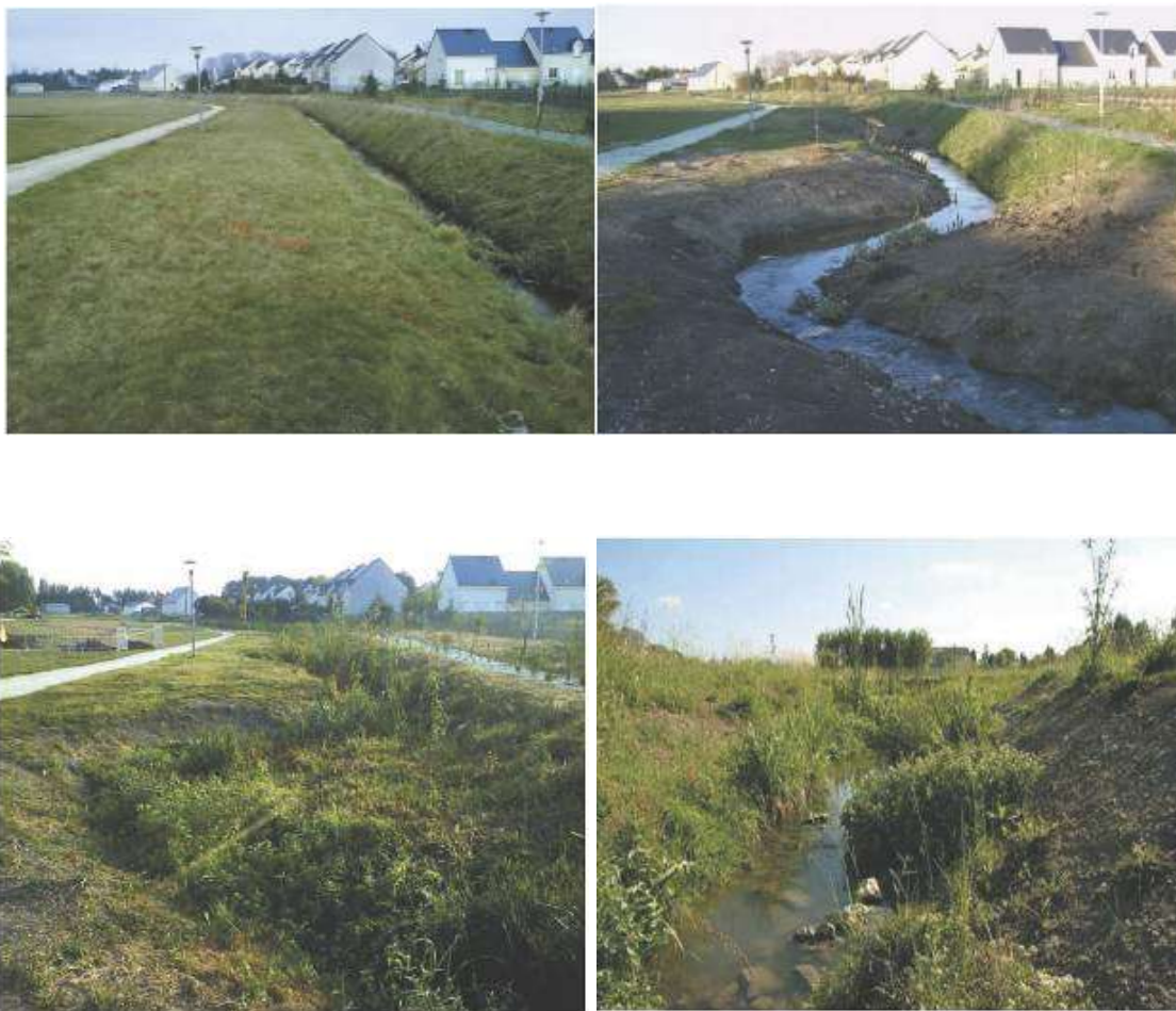
Figura 50 – Esempio di incremento della sinuosità del tracciato lungo il rio Mardereau presso Sorigny (Bacino della Loira – Francia).
