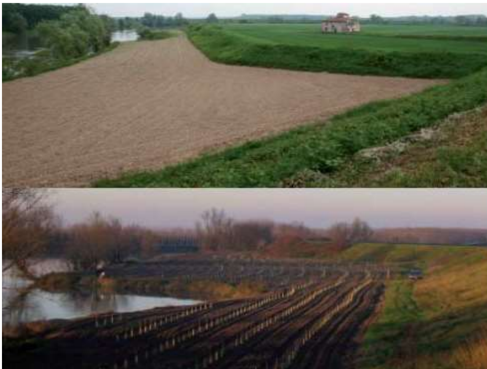
Figura 17 – L'immagine mostra un intervento di forestazione in una golenia del fiume Oglio, con effetti che possono essere sia naturalistici sia di tipo idraulico, grazie al rallentamento della corrente esercitato dagli alberi. Sebbene non realizzato per fini idraulici, l'intervento rappresenta una possibile applicazione dell'azione descritta. Intervento realizzato dal Parco fluviale Oglio Sud (Regione Lombardia). Foto: Bruno Boz.
