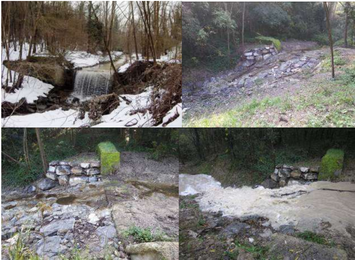
Figura 35 – Esempio di modifica di una briglia lungo il rio Lavezza nel Comune di Albinea (RE)
