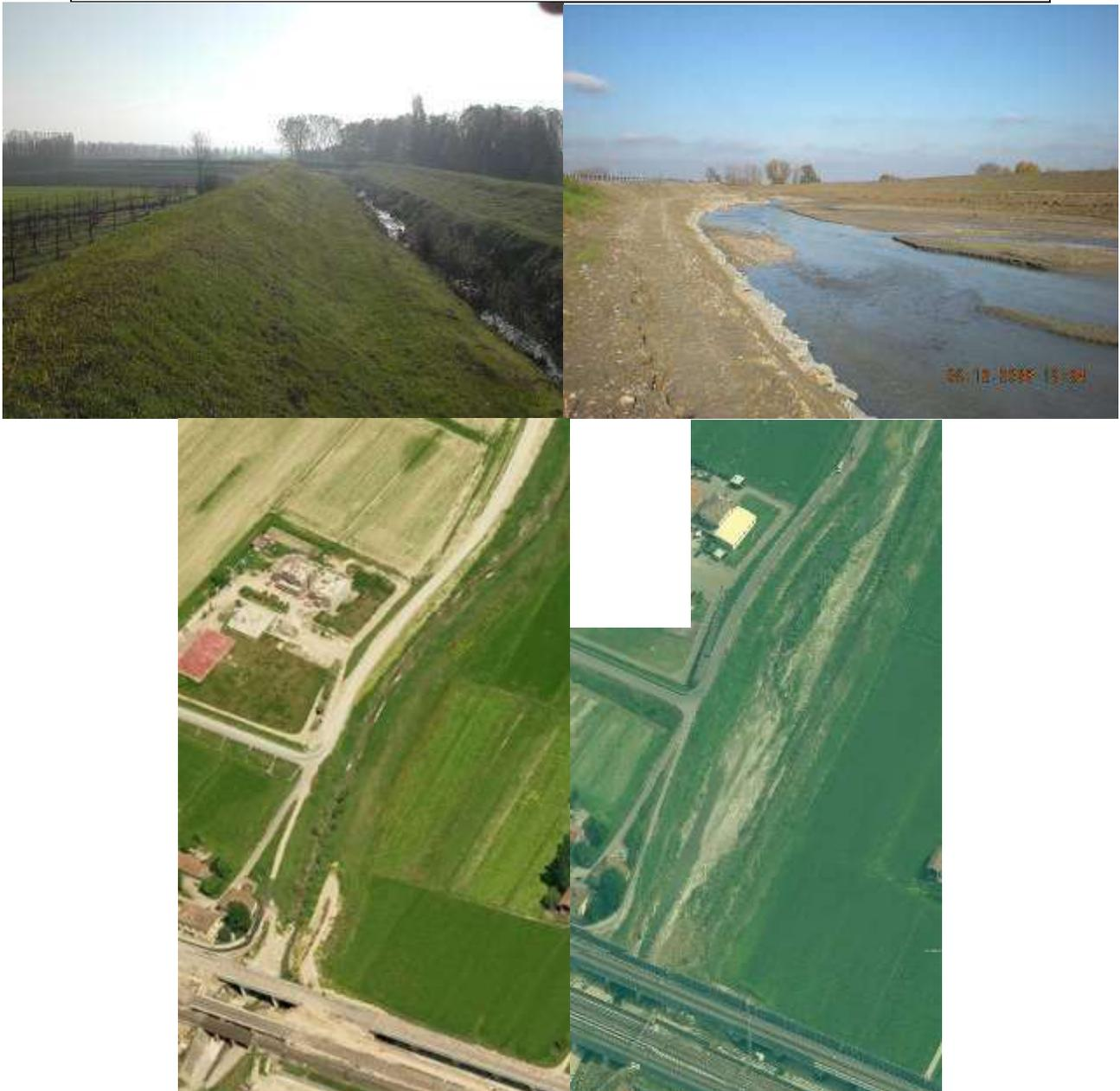
Figura 8 - Esempio di arretramento arginale lungo il torrente Lavino, in comune di (Provincia di Bologna). Il torrente Lavino nasce in Comune di Monte San Pietroe, dopo un percorso collinare, entra in pianura in prossimità della via Emilia, nel Comune di Zola Predosa, per poi immettersi nel torrente Samoggia, di cui è il principale affluente, in località Forcelli. A
