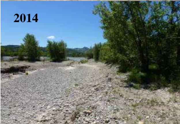
*Figura 25 - Riapertura di un alveo secondario interrato lungo il Fiume Taro realizzato nel Comune di Medesano all'interno del Parco fluviale del fiume Taro (Macroarea dell'Emilia Occidentale).*
