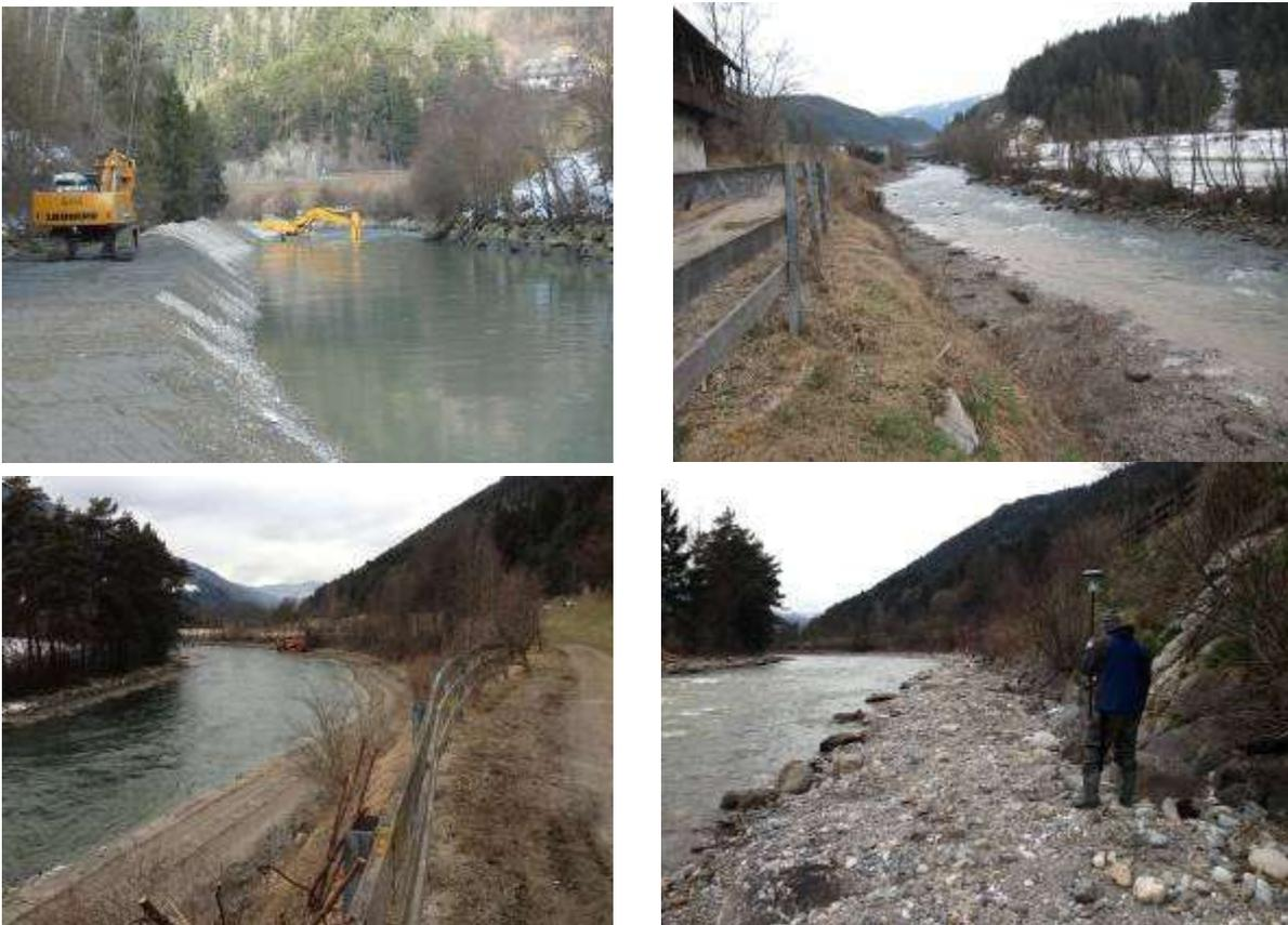
Figura 43 - Reintroduzione di sedimenti a valle di uno sbarramento idroelettrico sul fiume Rienza (Provincia Autonoma di Bolzano – Ripartizione Opere Idrauliche).
