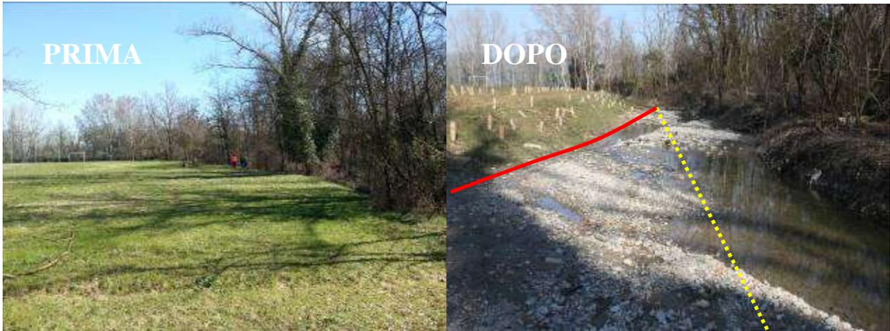
*Figura 12 - Esempio di creazione di piana inondabile in un corso d'acqua non arginato mediante abbassamento del piano campagna (rio Lavezza, Comune di Albinea in Provincia di Reggio Emilia).*
