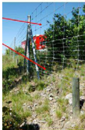
Figura. Esempio di rete a maglia diversificata posta lungo una strada ad intenso traffico per evitare l'attraversamento.
