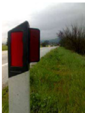
Figura. Esempio di dissuasore riflettente per la fauna selvatica montato su paracarro lungo una strada provinciale.
