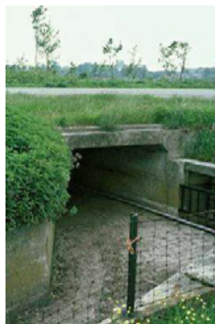
Figura. Esempio di sottopasso a sezione rettangolare; la pavimentazione in cemento rende il sottopasso meno gradevole alla fauna (da Infra Eco Network Europe).
