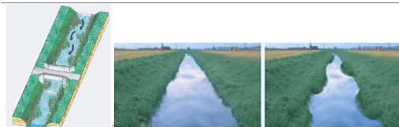
Figura. Esempio di creazione di canale di corrente sinuoso con l'asportazione parziale della vegetazione erbacea (da Piano di tutela delle acque della Provincia di Bologna).
