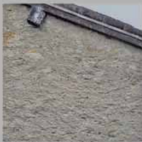
Intonaco a rinzaffo
