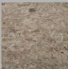
Intonaco spianato e battuto stilo con lama
