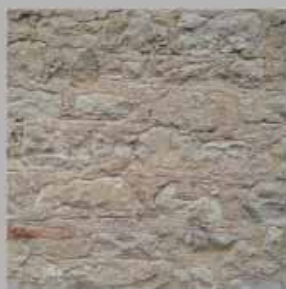
Intonaco spianato e battuto stilo con lama
