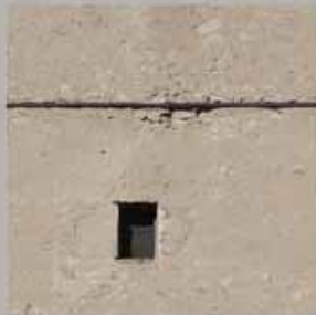
Intonaco spianato e battuto a cazzuola
