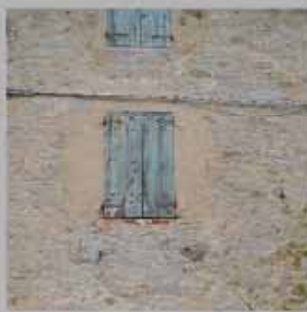
Intonaco spianato e battuto stilo con lama
