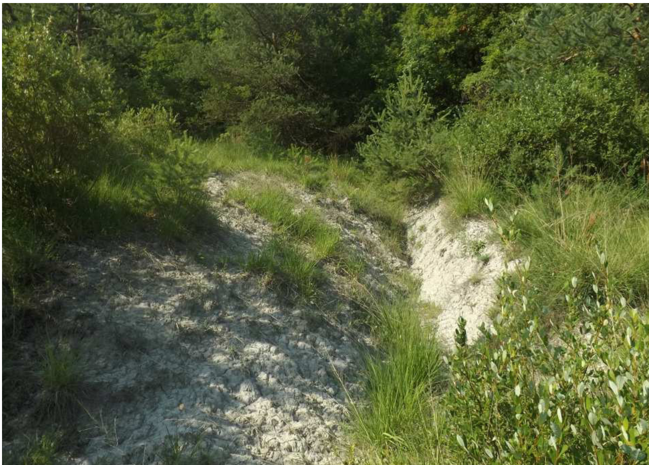
Foto n° 5 – fosso di scolo delle acque meteoriche presente lungo il versante a monte dello stabilimento
