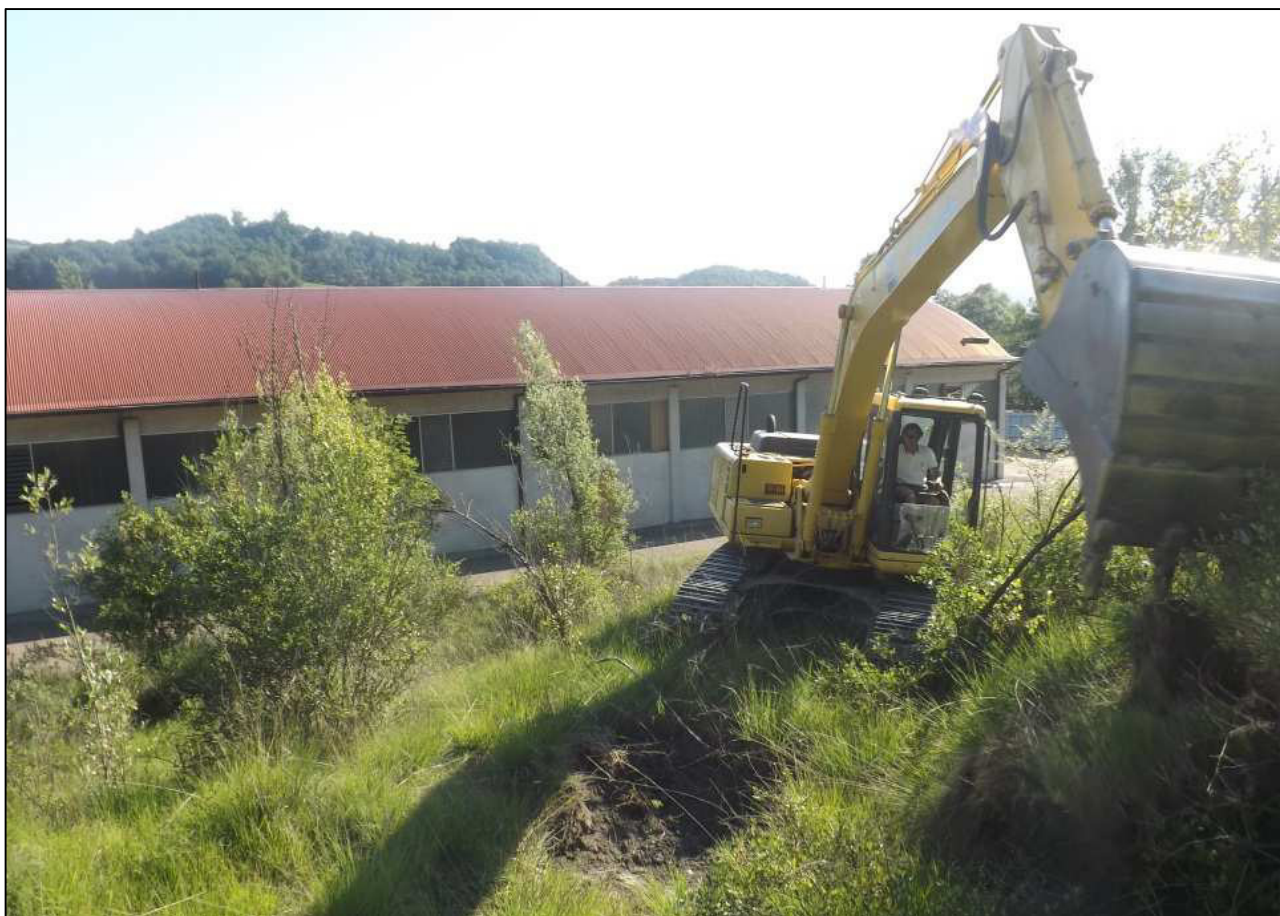
Foto n° 3 – esecuzione sondaggi con escavatore
