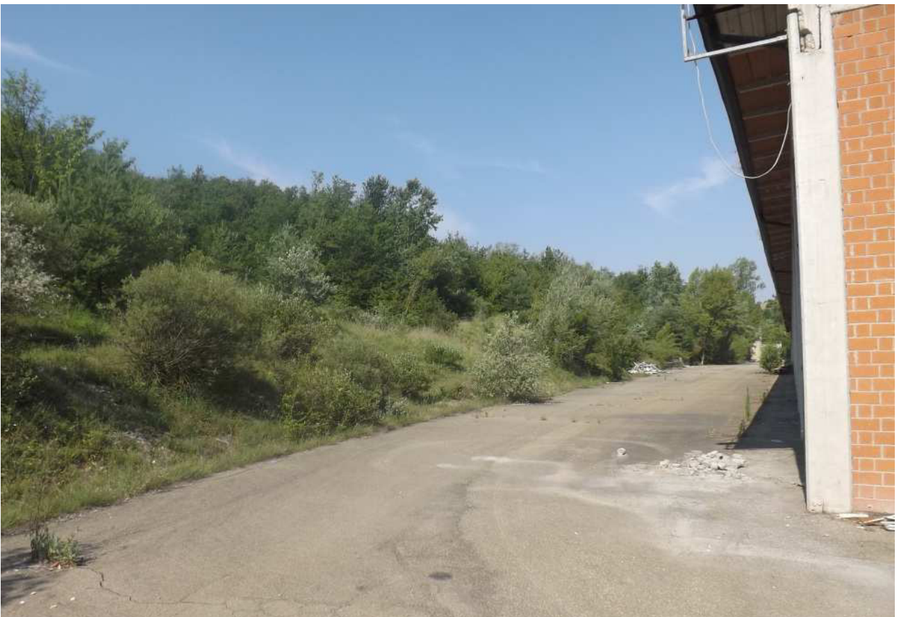
Foto n° 2 – Vista sul retro del capannone industriale dismesso
