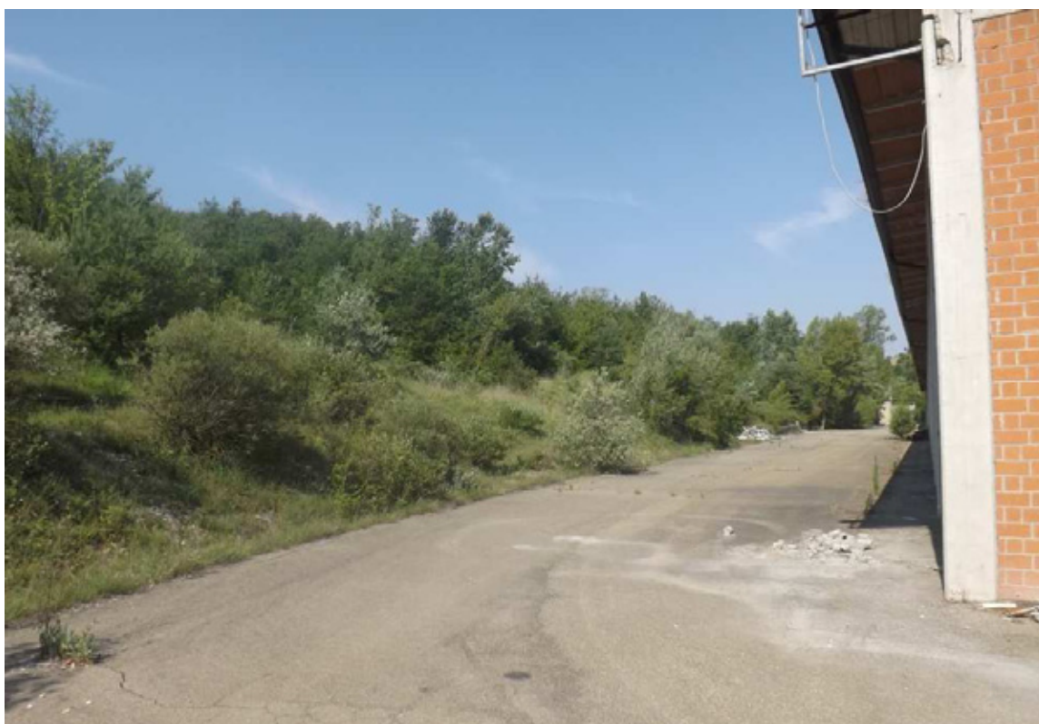
Foto n° 2 – Vista sul retro del capannone industriale dismesso
