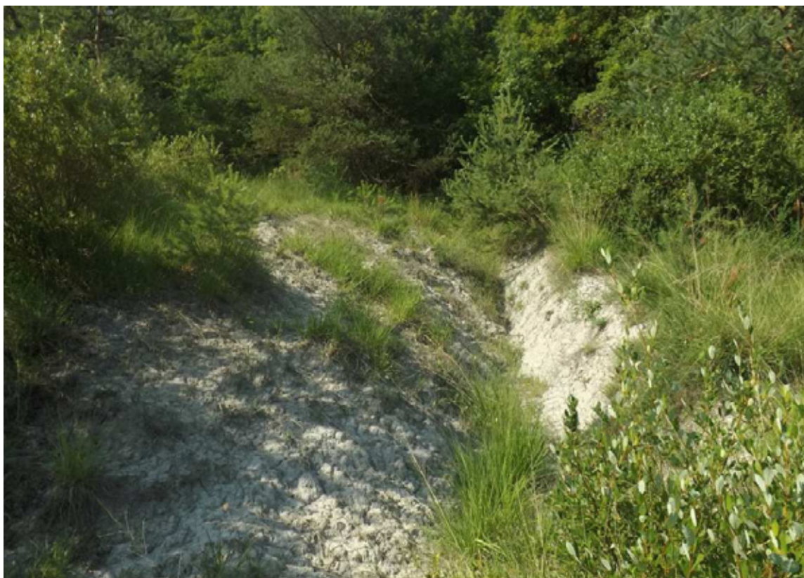
Foto n° 5 – fosso di scolo delle acque meteoriche presente lungo il versante a monte dello stabilimento
