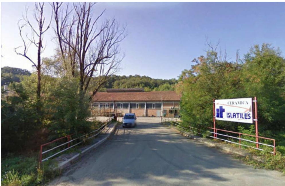
Fig. 3. Lo stabilimento visto dalla strada in corrispondenza dell'accesso
