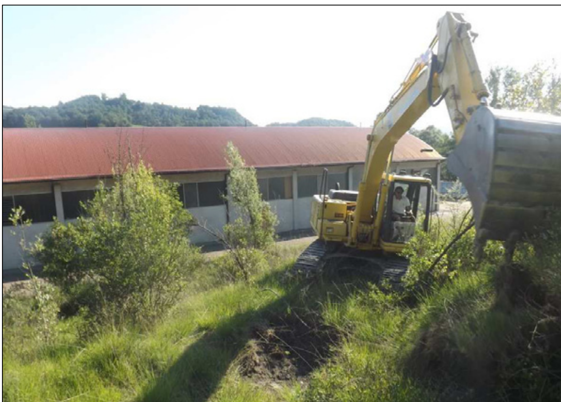
Foto n° 3 – esecuzione sondaggi con escavatore
