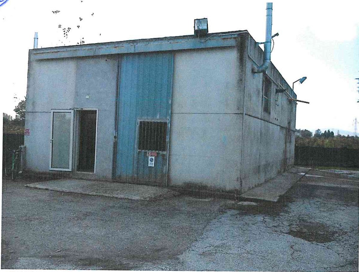
Edificio 4: VV.F (magazzino attrezzature-equipaggiamento di intervento)
