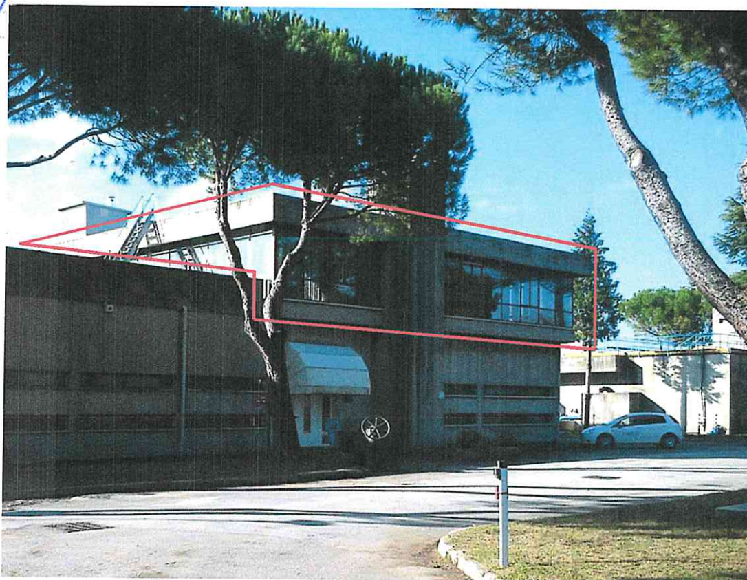
Edificio 2 (porzione relativa al primo piano): Protezione Civile (Centro Operativo Intercomunale)
