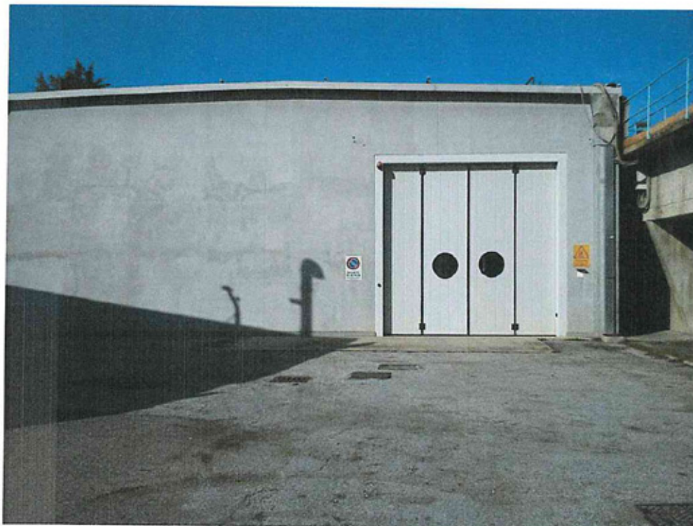
Edificio 3 (porzione): VV.F (Rimessa automezzi di intervento)
