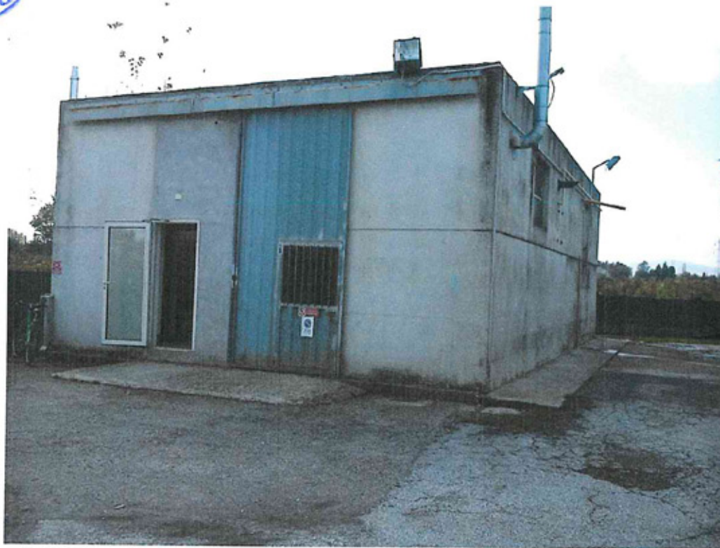
Edificio 4: VV.F (magazzino attrezzature-equipaggiamento di intervento)
