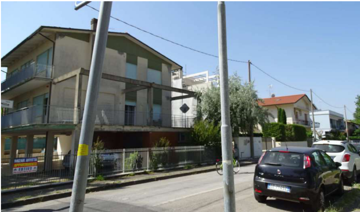
Foto 14 – Fabbricati residenziali, posti su Viale dei Mille
