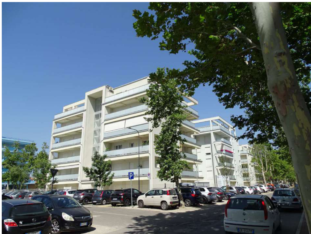
Foto 8 – Fabbricati residenziali posti in Viale Euclide n. 37, 37/A e 37/B, presa scattata tra angolo Viale G. Galilei e Viale Pitagora
