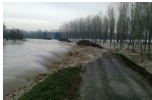
Figura 11: Rotture arginali
