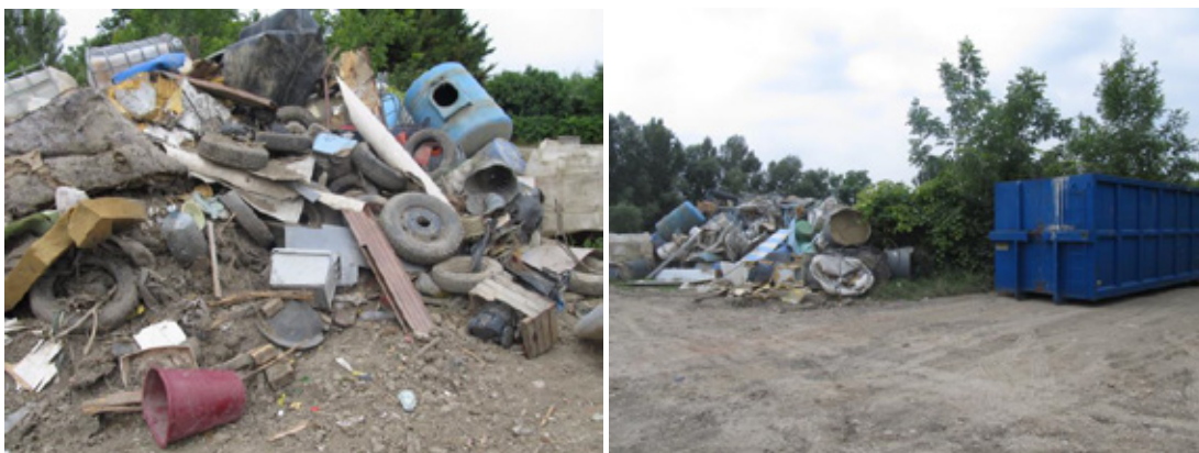
intervento2016 rimozione baracche e rifiuti, la separazione dei materiali
