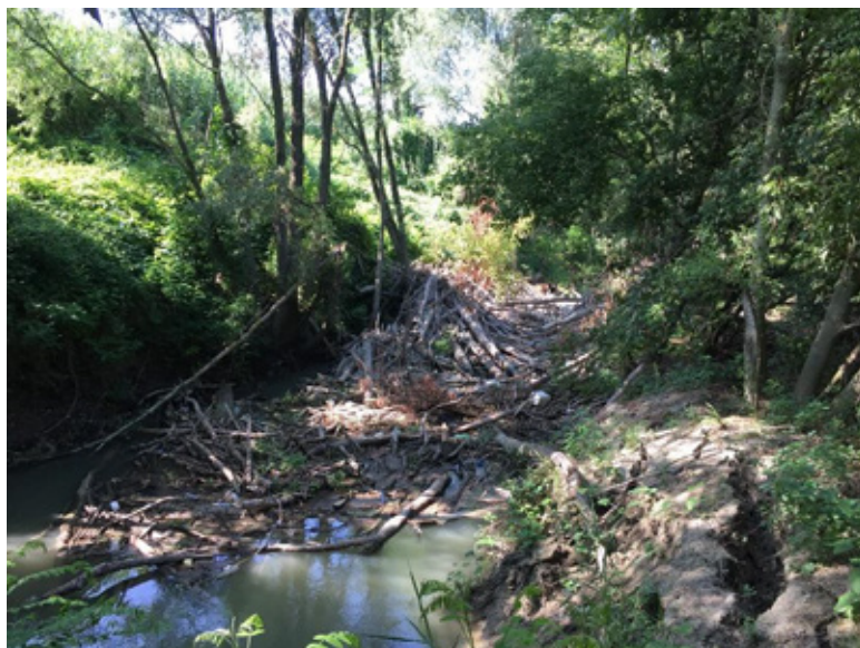
isola di legname/plastica che ostruisce completamente una sezione nella pianura arginata con notevoli erosioni sulle scarpate
