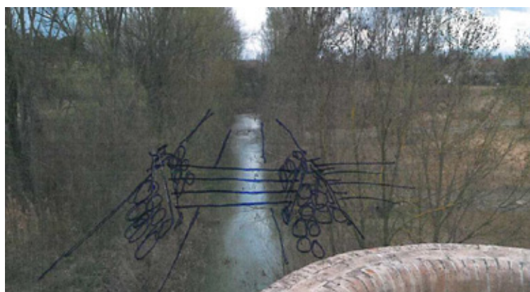
Fiume Rabbi vista verso Monte dal Ponte pedonale, con ipotesi briglia selettiva
