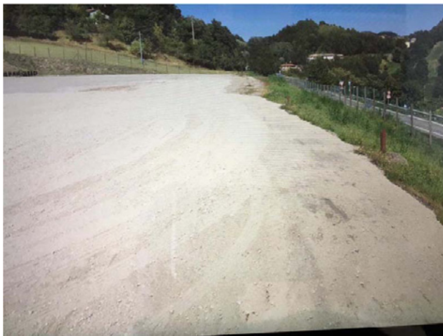
Vista dell'area a margine della S.S.63
