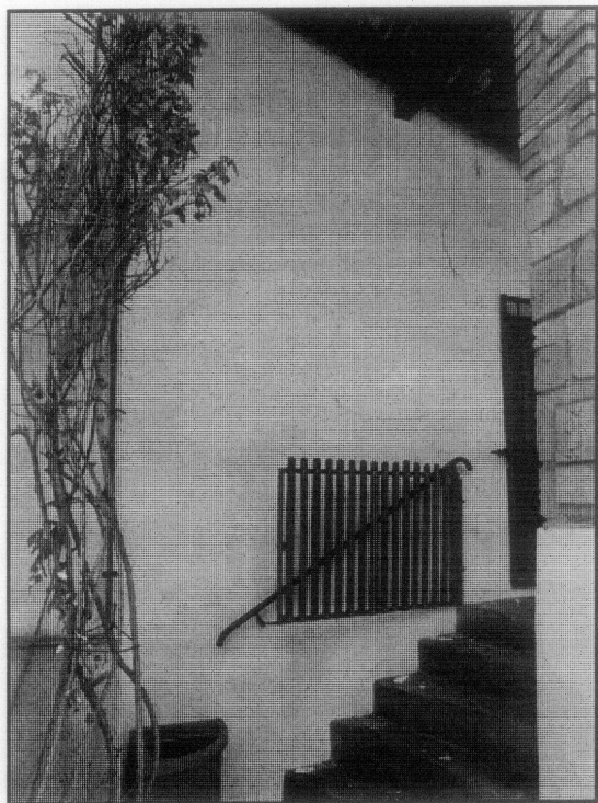
Foto n. 23 – Terenzo: lesioni in edificio in muratura nel centro del paese
