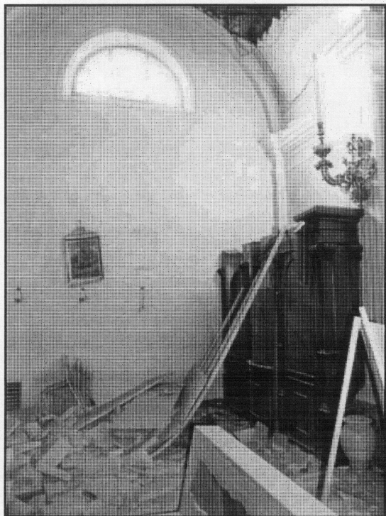
Foto n. 8 – Mamiano (Traversetolo): chiesa inagibile per crollo della volta in una cappella laterale
