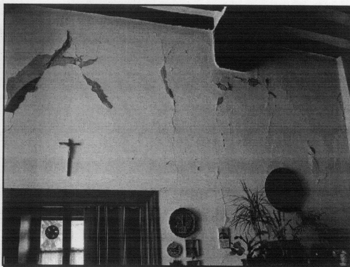
Foto n. 20 – San Vitale di B. (Sala Baganza): edificio privato, lesioni diffuse e distacco di intonaco
