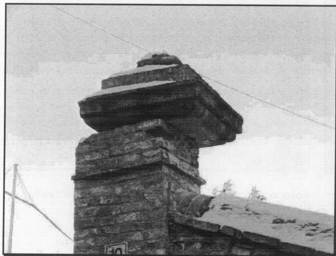
Foto n. 21 – San Vitale di B. (Sala Baganza): slittamento e parziale rotazione del capitello di una colonna in un muro di recinzione
