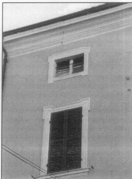
Foto n. 7 – Langhirano: esempio di lesione passante in edificio in muratura
