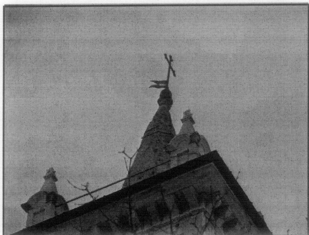
Foto n. 25 – Vezzano (Neviano degli Arduini): chiesa, rottura della parte sommitale della torre campanaria
