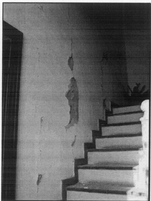
Foto n. 19 – San Vitale di B. (Sala Baganza): edificio privato, lesioni diffuse e distacco di intonaco
